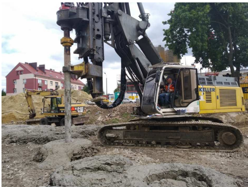
Рисунок 25 - Общий вид готовых грунтоцементных свай
