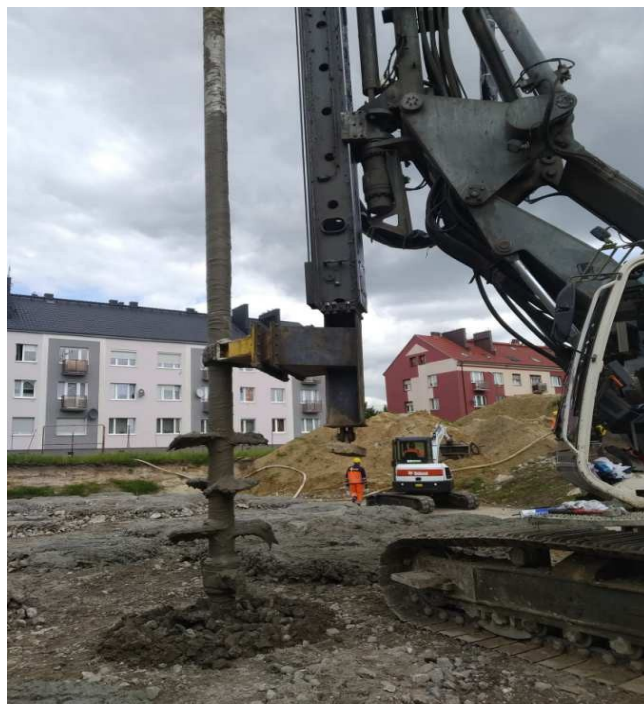
Рисунок Г.8 - Процесс устройства грунтоцементных колонн
