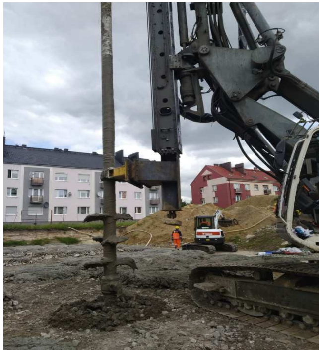
Г.8 сурет - Топырақцемент бағандарын орнату процесі
