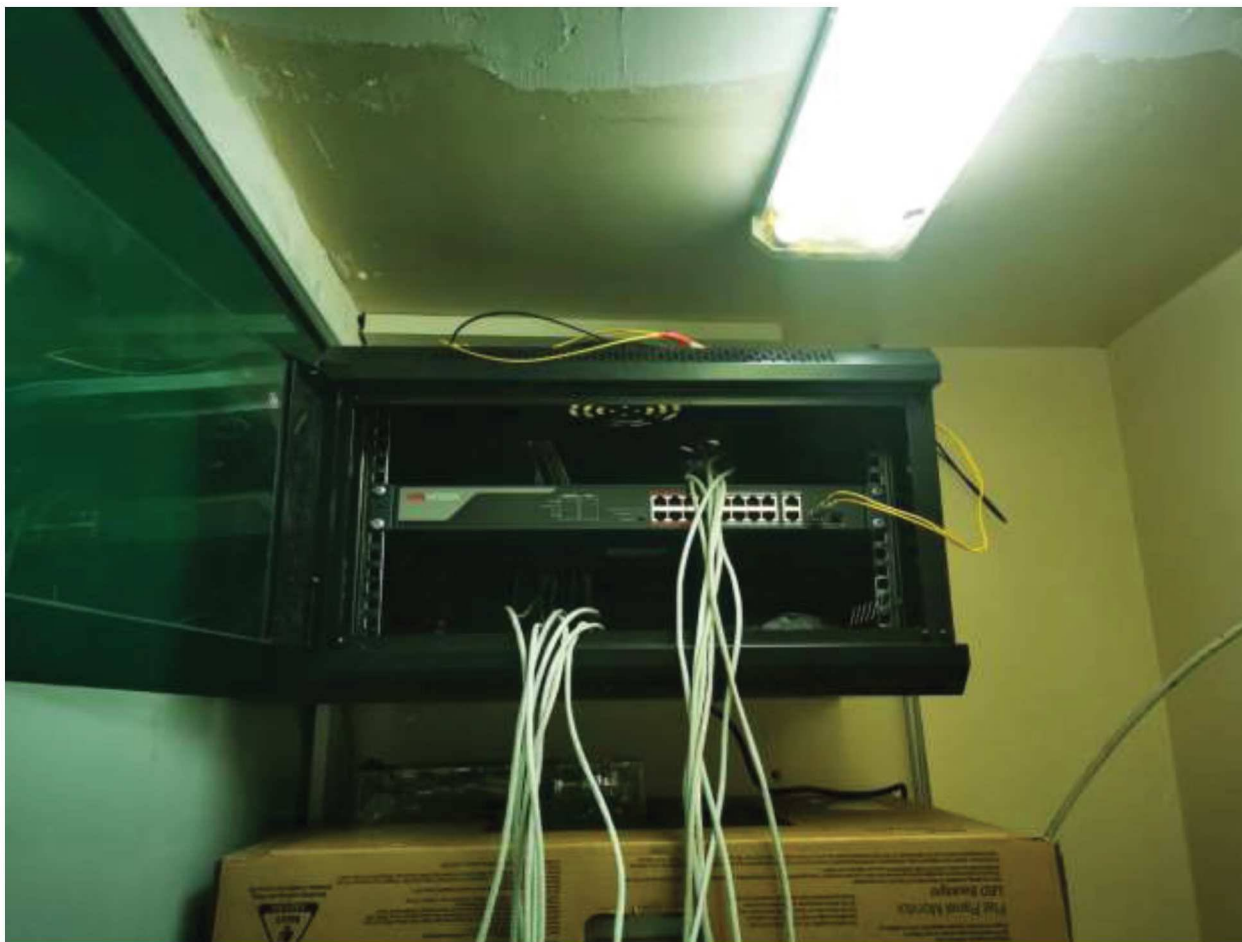
Рисунок 14 - установка коммутатора в телекоммуникационный шкаф
