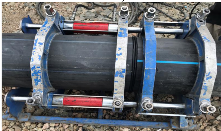
Рисунок 5 – Процесс стыковой сварки полимерных труб малых диаметров а – общий вид центратора и сварочного оборудования, б, в, г – установка труб на центратор, д, е – закрепление торцов труб на центраторе, ж, з – обработка торцов труб с помощью электрического дискового торцевателя, и, к - обработка торцов труб и установка нагревательного элемента («зеркала»), л - процесс охлаждения соединения после сварки
