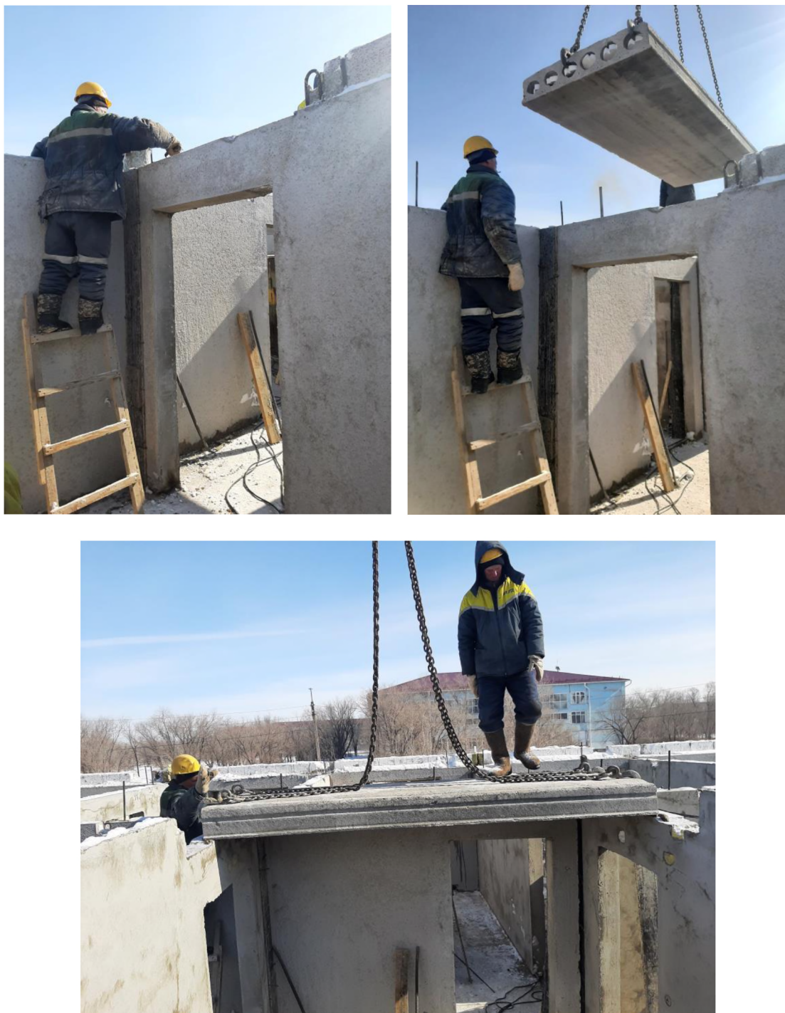
Рисунок 6 – Монтаж плит перекрытий
