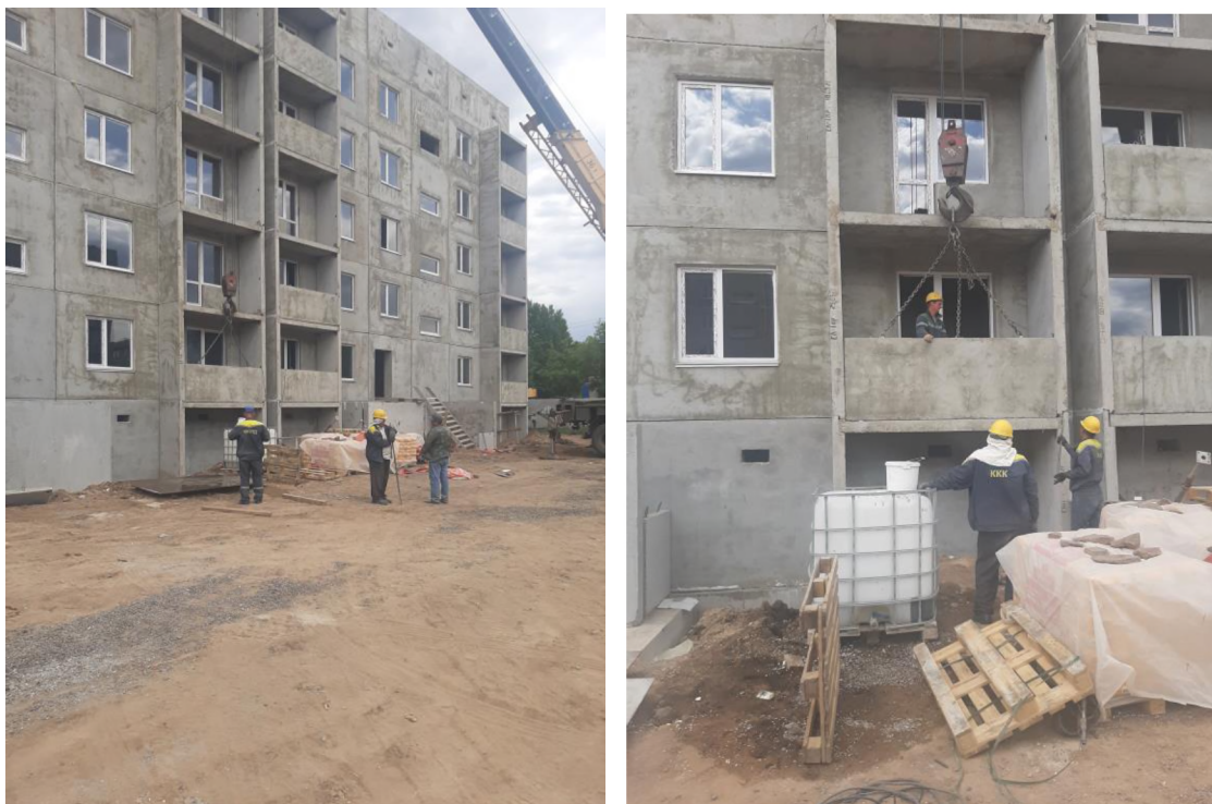
Рисунок 5 - Установка панели стенок и плит лоджий
