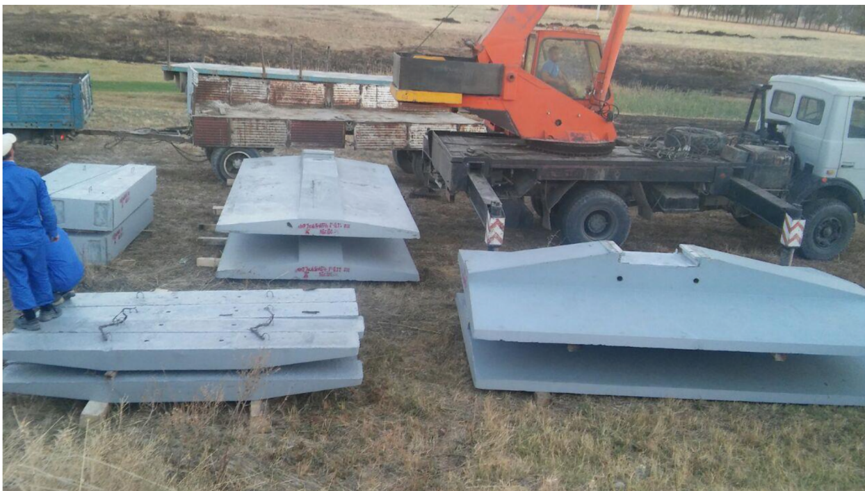
Рисунок 3- Складирование сборных фундаментов
