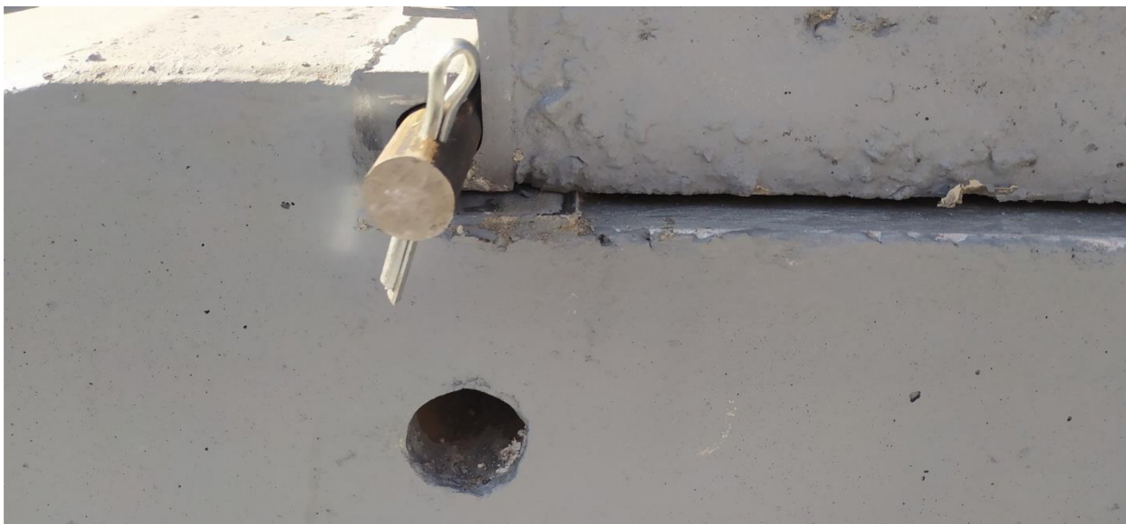
Рисунок 5 - Процесс сборки стойки и плиты
