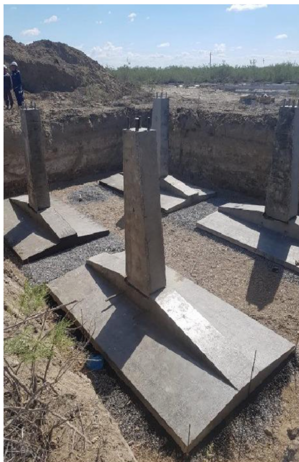
Рисунок 6 – Установка сборного фундамента
