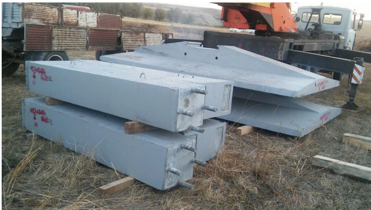
Рисунок 2 - Схема транспортировки сборных фундаментов по серии 3.407.1-144
