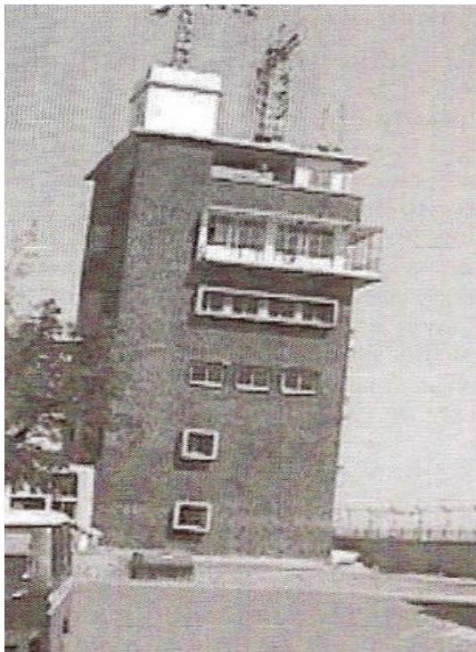
11.2-сурет – Bhuj-дегі жер сілкінісі кезінде қадалы іргетастарда тас қалаудан жасалған биік ғимараттың айналуы (Madabhushi et al. 2005)
