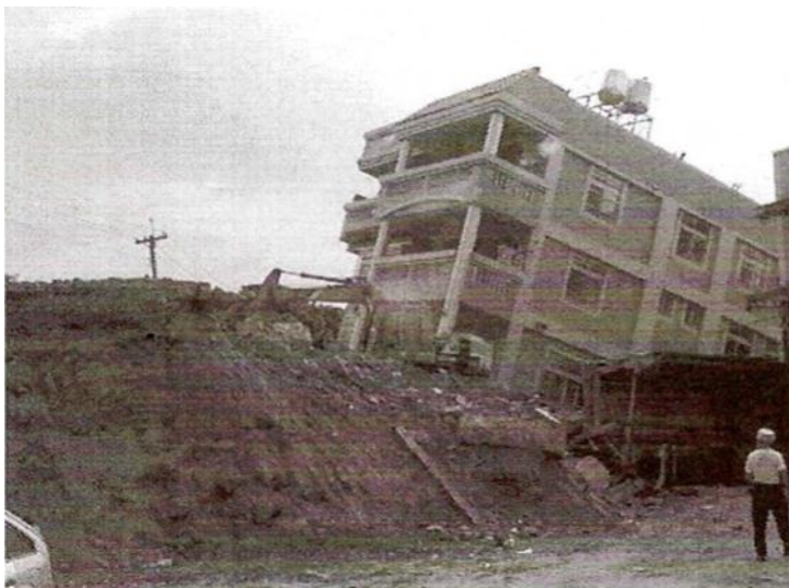
Рис. 7.1 Отрыв здания в результате сбросового разрыва – Землетрясение Ji-Ji, 1999
