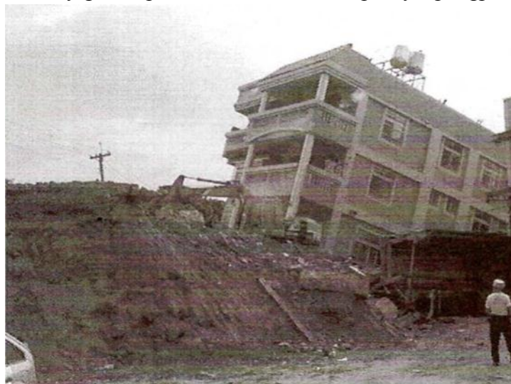
7.1-сурет. Опырылып жарылу нәтижесінде ғимараттың бөлінуі – Ji-Ji жер сілкінісі, 1999
