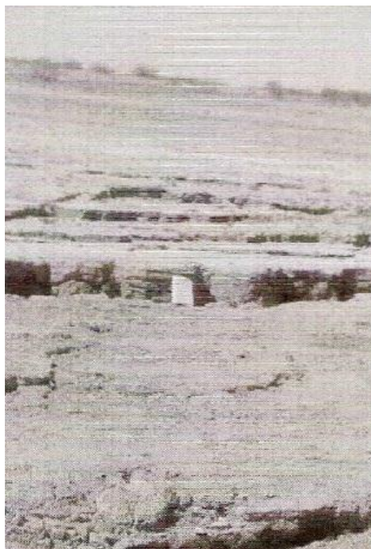
11.9-сурет Жер тоғанының құлама еңістері бойынша төмен қарай бүйірлік жылжу
