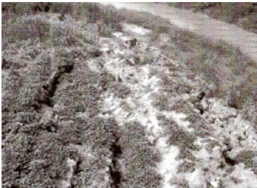
11.6-сурет. Тайваньның Taichung қаласындағы жаңа көпірдің аралық тірегі маңындағы бүйірлік жылжу
