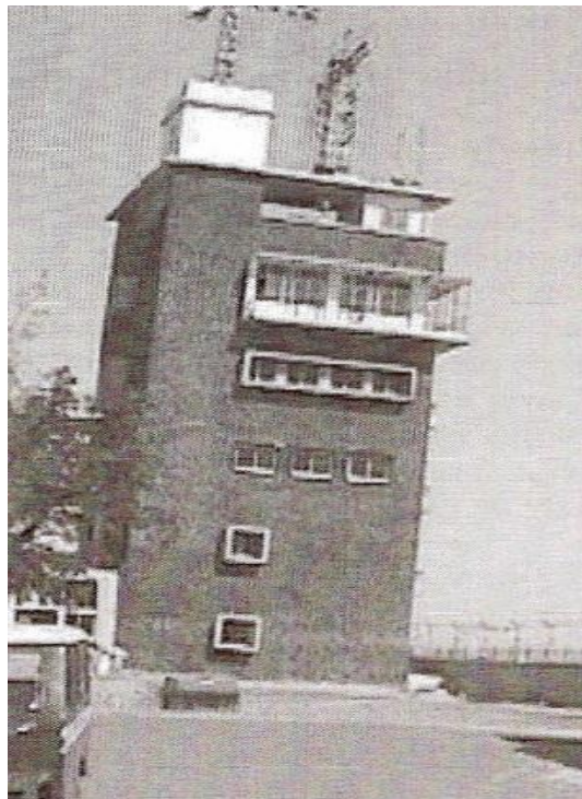
Рисунок 11.2 - Вращение высокого здания из каменной кладки на свайных фундаментах во время землетрясения Bhuj (Madabhushi et al. 2005)
