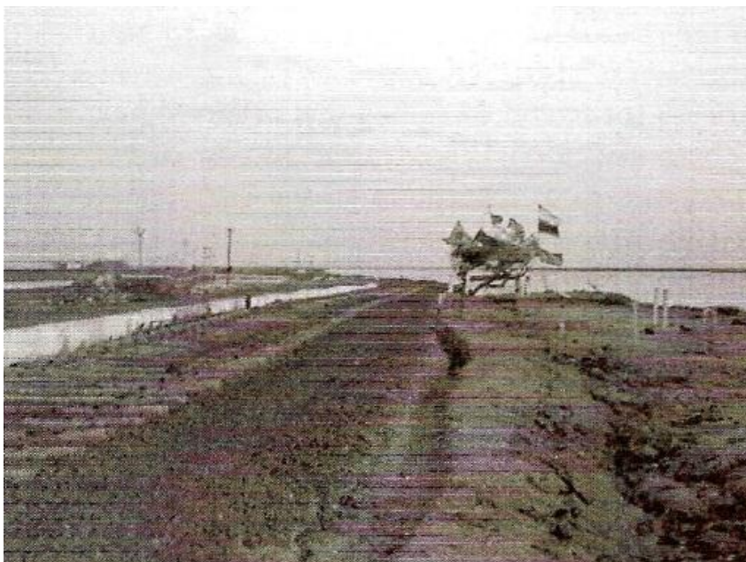
11.8-сурет Gujarat-ғы Navalakhi портындағы теміржол желісінің жанындағы бүйірлік таралу, Үндістан
