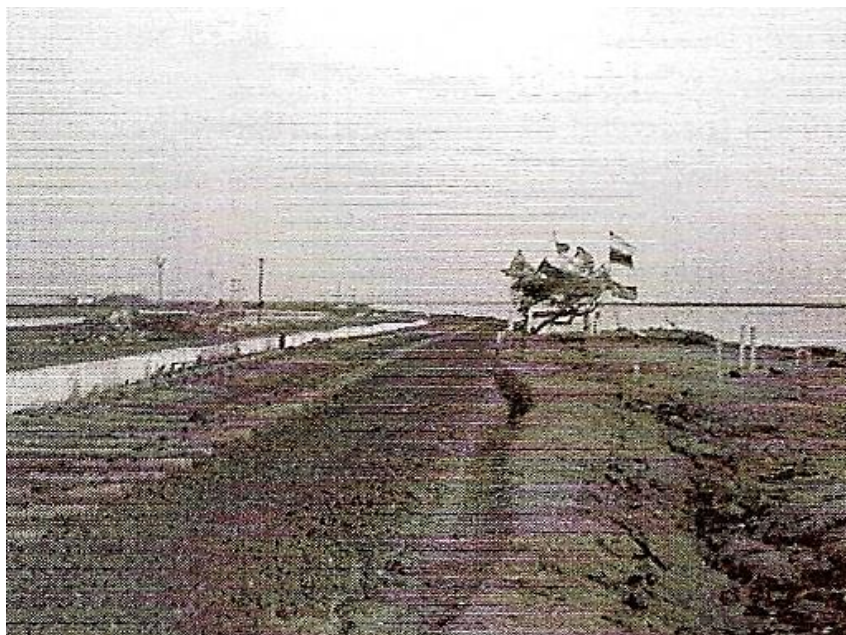
Рисунок 11.8 Боковое распространение рядом с железнодорожной линией в порту Navalakhi в Gujarat, Индия
