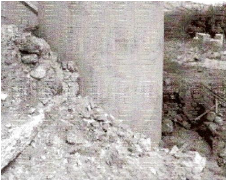
11.6-сурет. Тайваньның Taichung қаласындағы жаңа көпірдің аралық тірегі маңындағы бүйірлік жылжу
