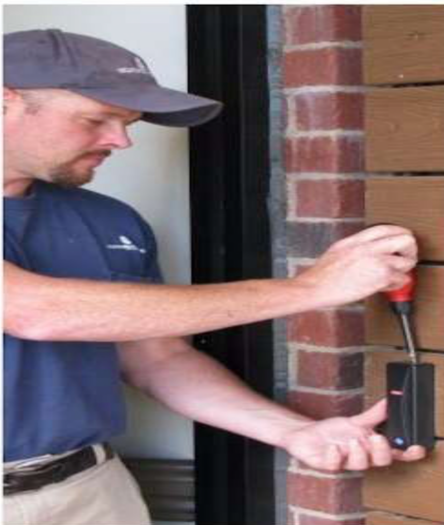
Рисунок 9 – монтажа считывателя
