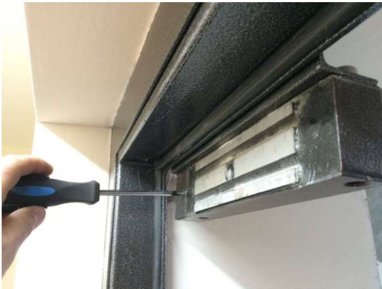
Рисунок 8 – установка электромагнитного замка
