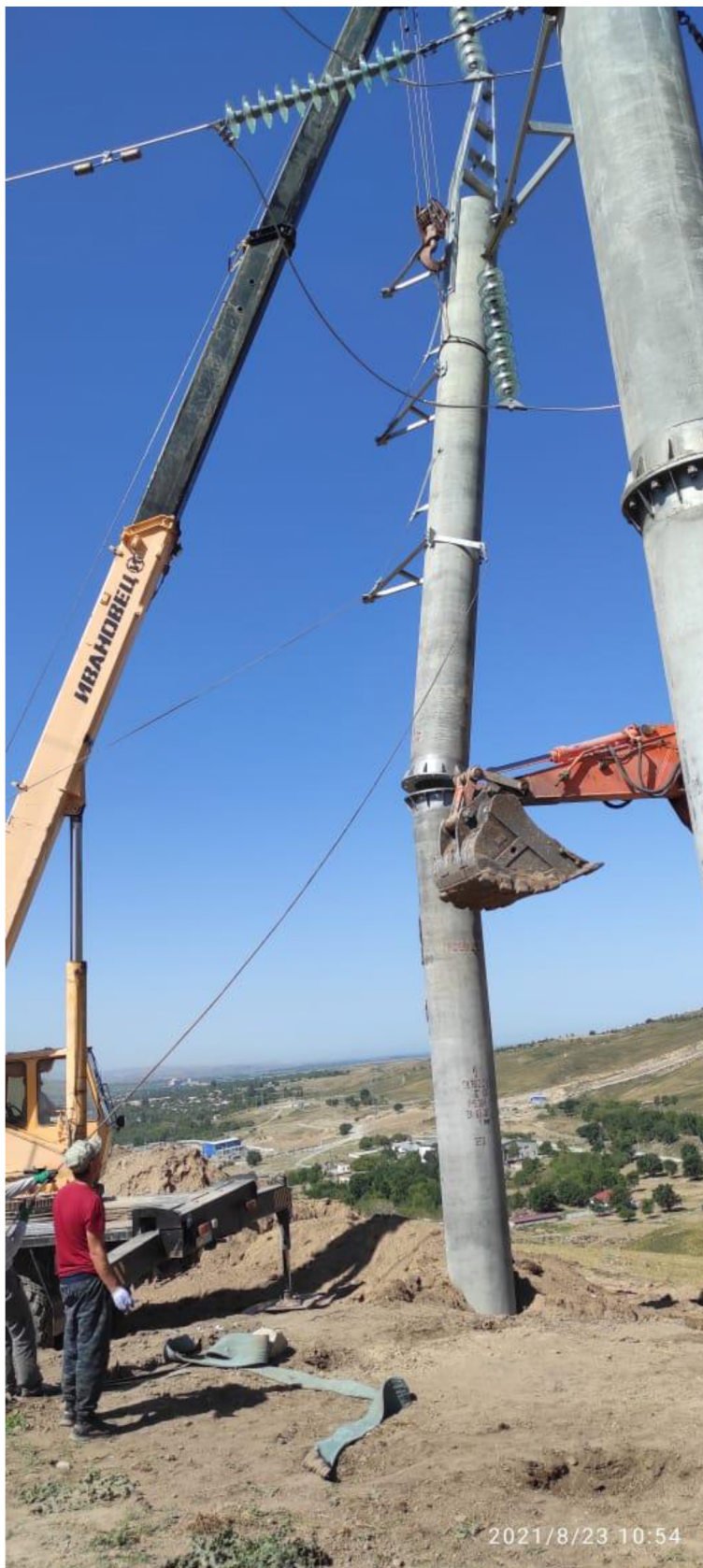
Рисунок 8 – Установка опоры
