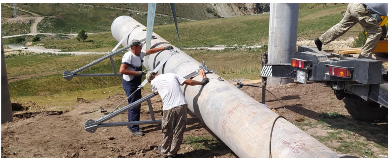
Рисунок 5 - Сборка траверс
