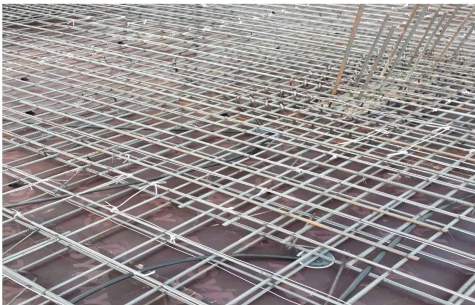
Рисунок 8 – Устройство проводок в монолитном перекрытии
