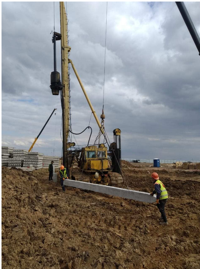
Рисунок 13 – Подача сваи к месту забивки
