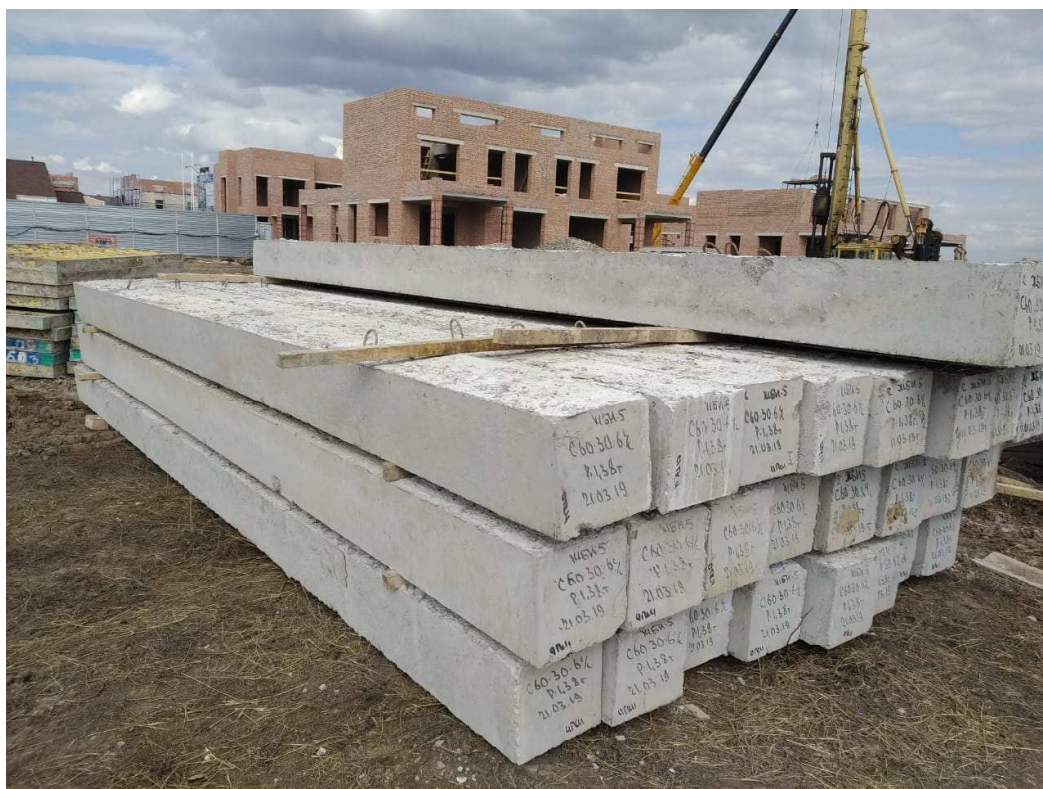
1-сурет – Қадалы қатарлап жинау схемасы
