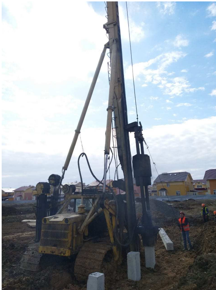
Рисунок 15 - Забивка свай
