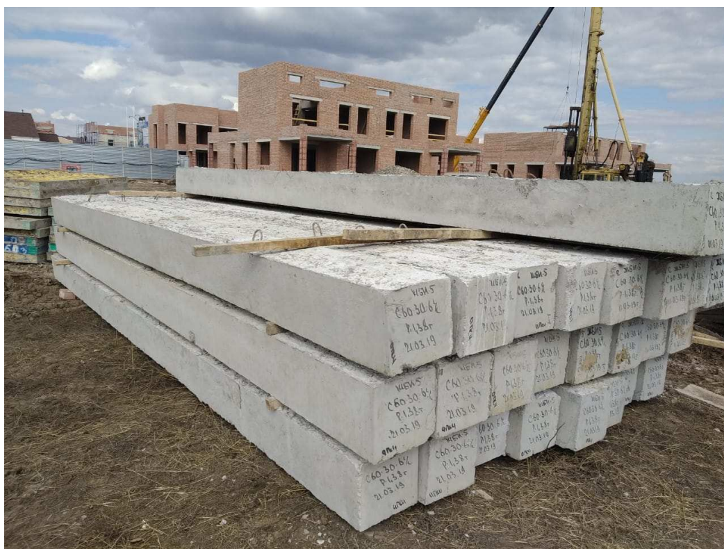
Рисунок 1 - Схема складирования свай в штабель
