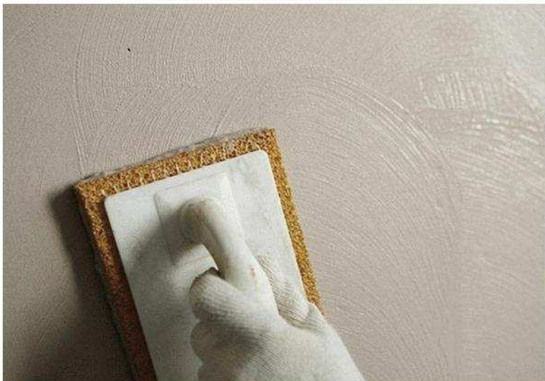
8-сурет-Беткі қабатты кеукті ысқышпен ысқылау
