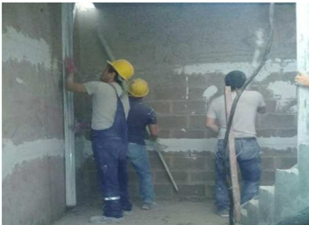
Рисунок 7 – Выравнивание растворной смеси
