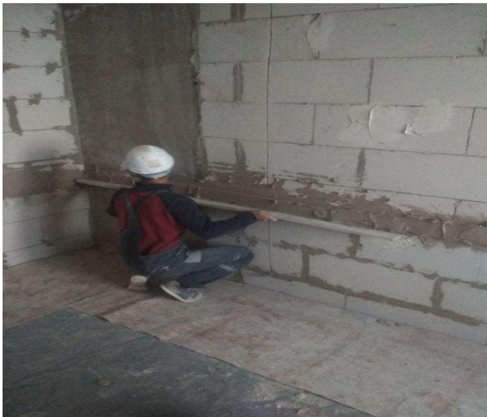
Рисунок 5 – Проверка установки маяков
