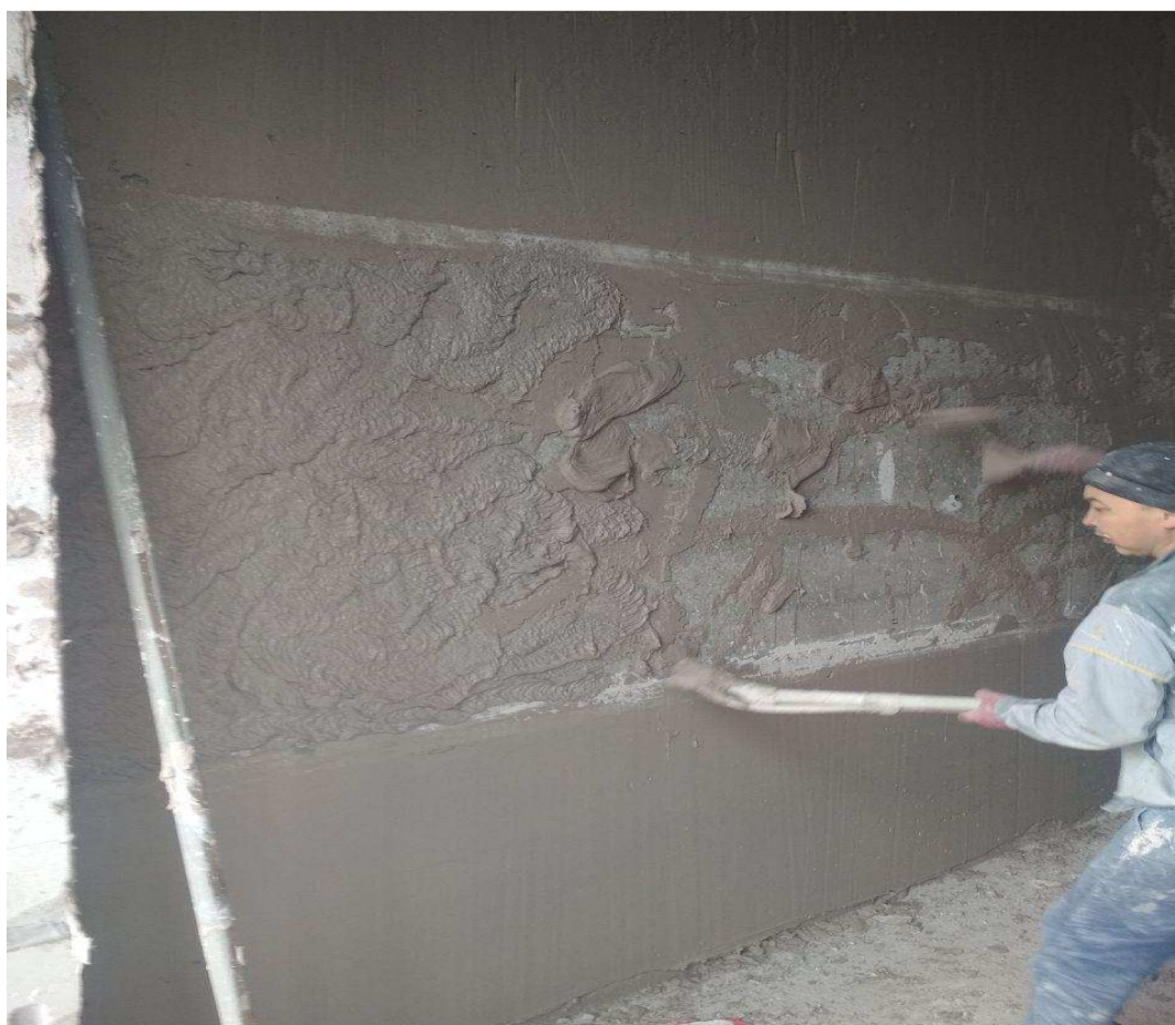
Рисунок 6 - Нанесение штукатурного раствора на стены
