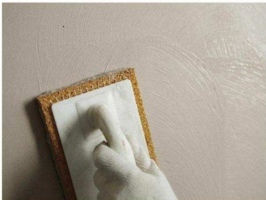
Рисунок 8 – Затирка поверхности губчатой теркой
