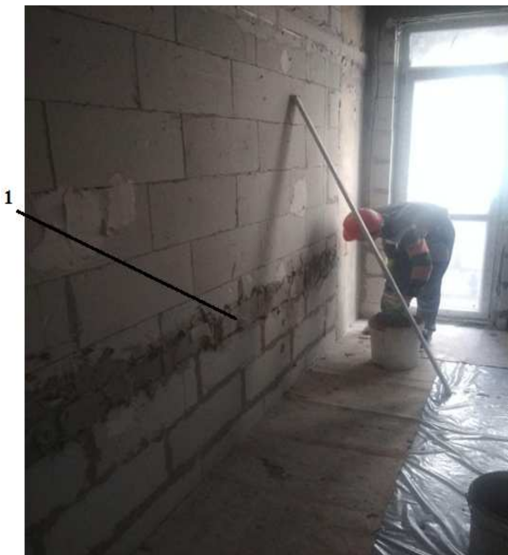
Рисунок 4 – Установка маяков
