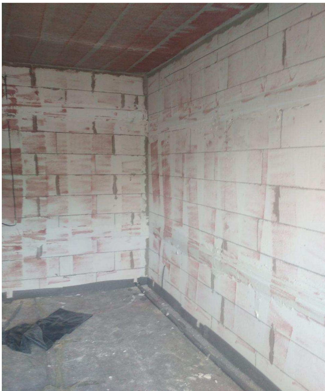
Рисунок 3 – Грунтованная поверхность стен
