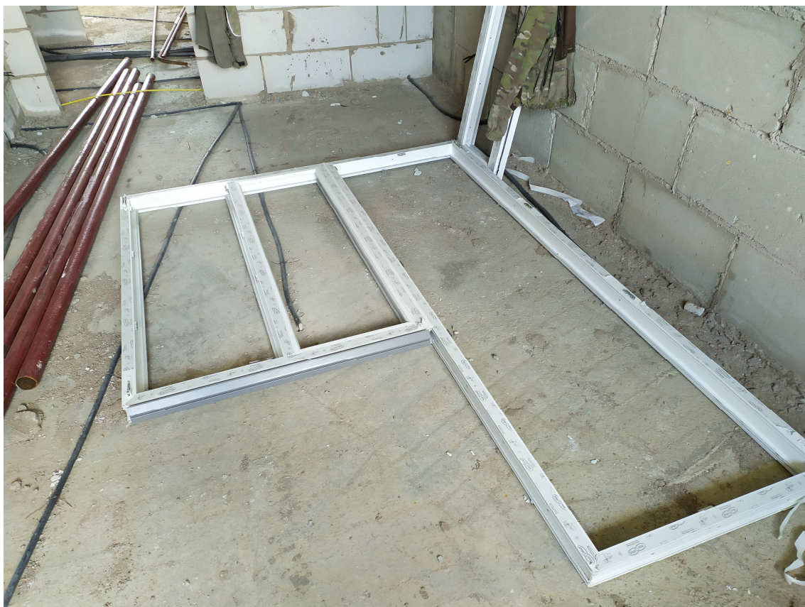
6-сурет-жиналған балкон секциясы
