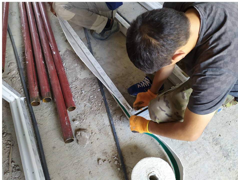
Рисунок 7 – Проклейка пароизоляционной ленты
