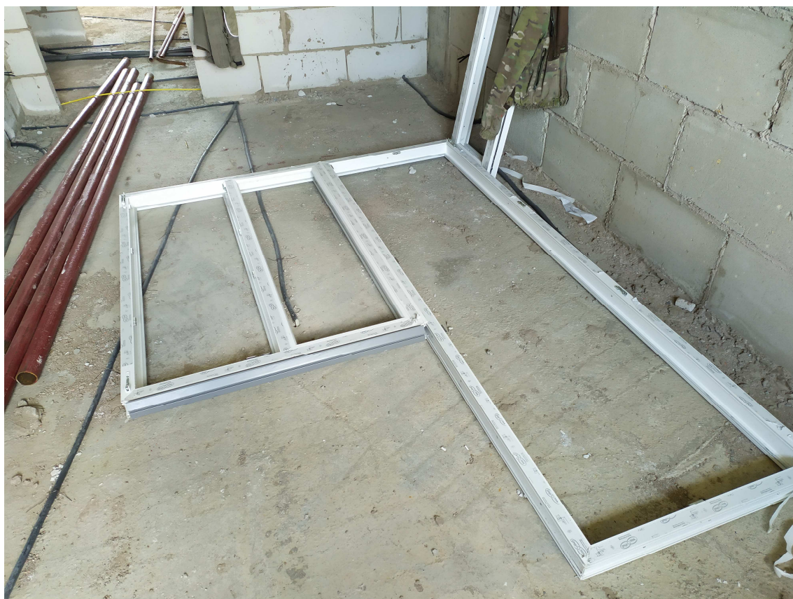
Рисунок 6 - Собранная балконная секция
