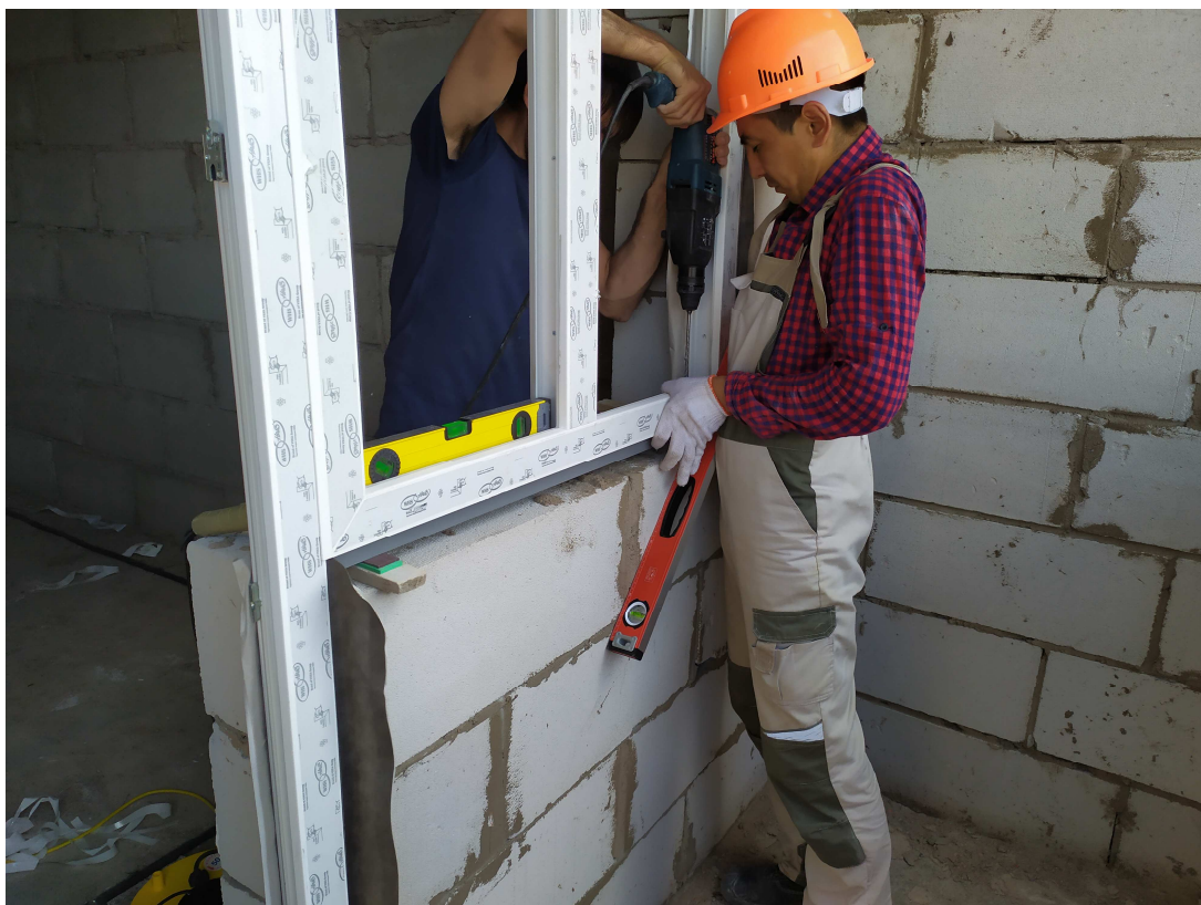
Рисунок 8 – Установка и фиксация блока балконной секции
