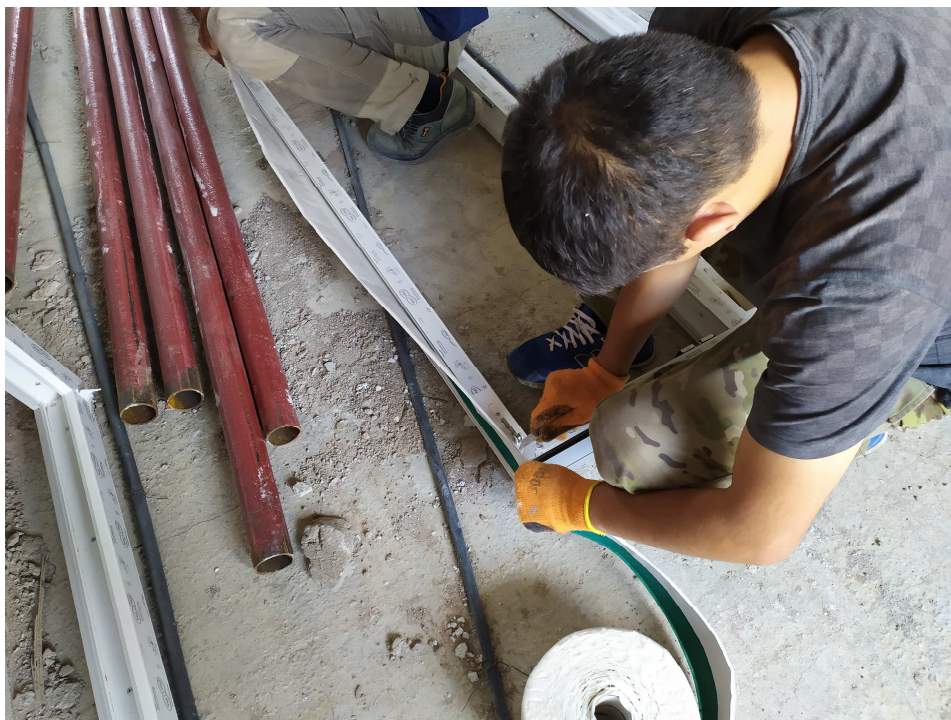
Сурет 7 - бу оқшаулағыш лентаны желімдеу
