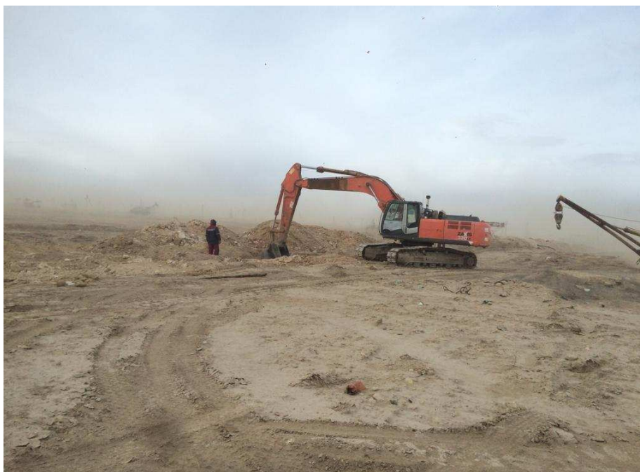
7-сурет-Ордағы топырақты шынжыр табанды жүрістегі кері күрегі бар бір шөмішті гидравликалық экскаватормен әзірлеу
