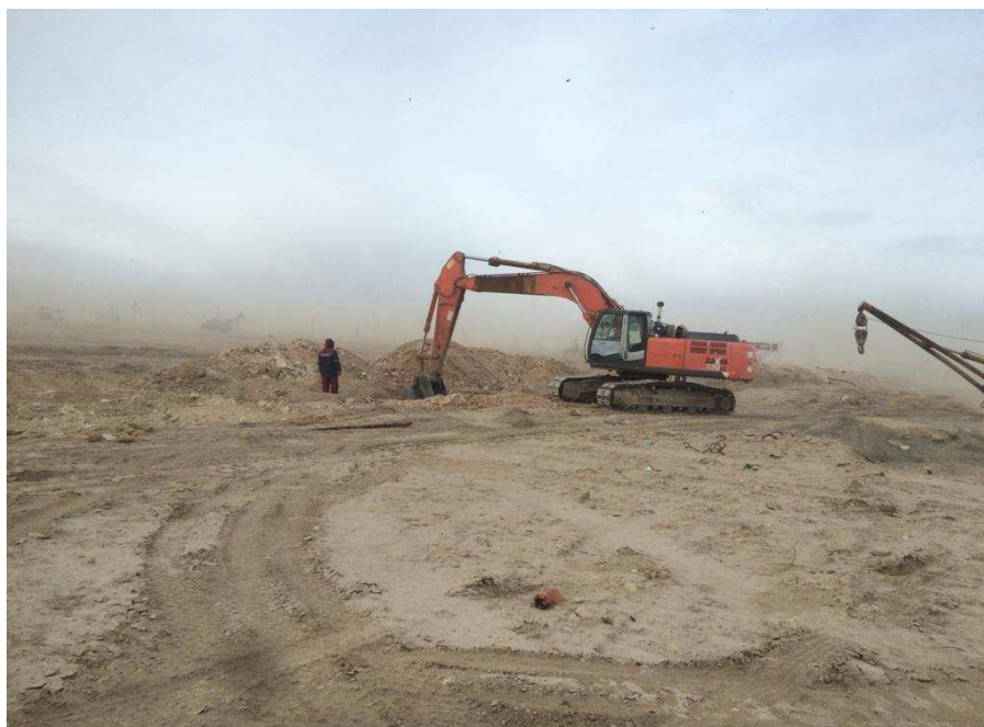
Рисунок 7 - Разработка грунта в траншее одноковшовыми гидравлическими экскаваторами с обратной лопатой на гусеничном ходу
