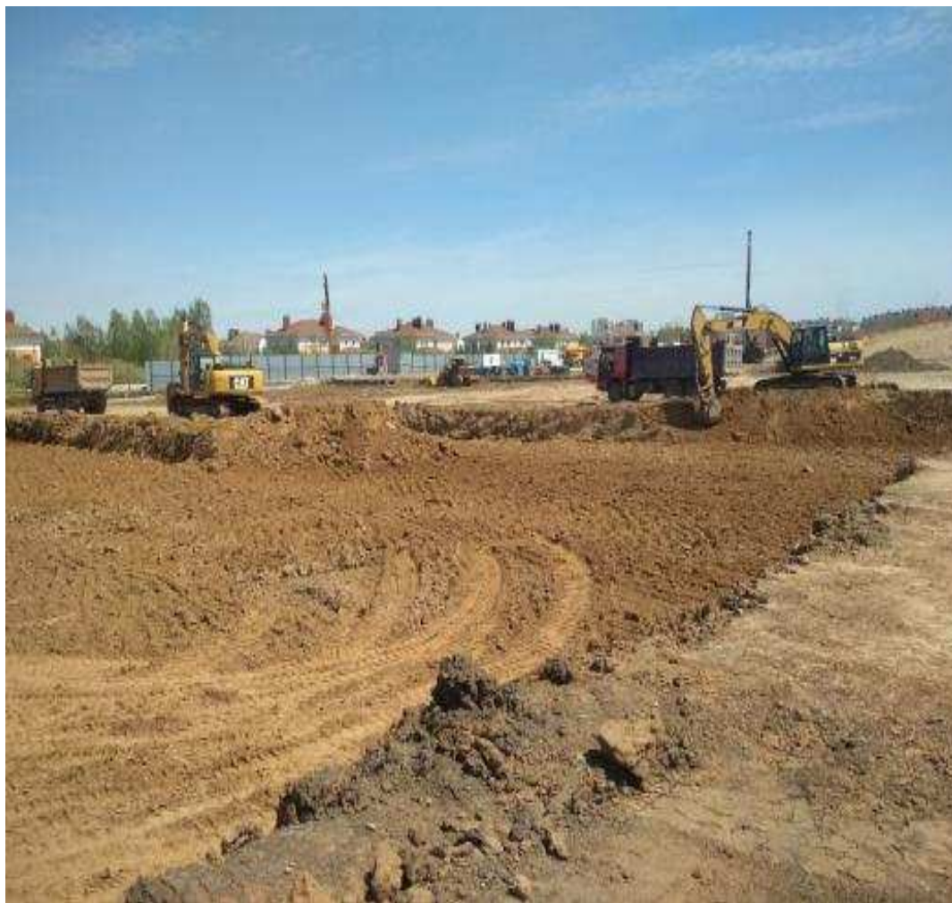
Рисунок 5 - Разработка грунта в котловане одноковшовыми гидравлическими экскаваторами с обратной лопатой на гусеничном ходу
