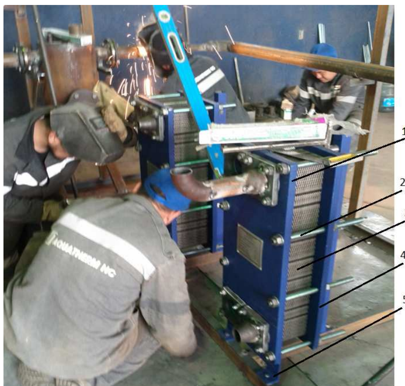
10-сурет – Пластина тәрізді жылу алмастырғыштарды орнату 1 – жылжымайтын тақта, 2 – тартпалы түйреуіш, 3 – жылу алмастырғыш пластина, 4 – қыспа тақта, 5 – пластина тәрізді жылу алмастырғышты бекіту орны
