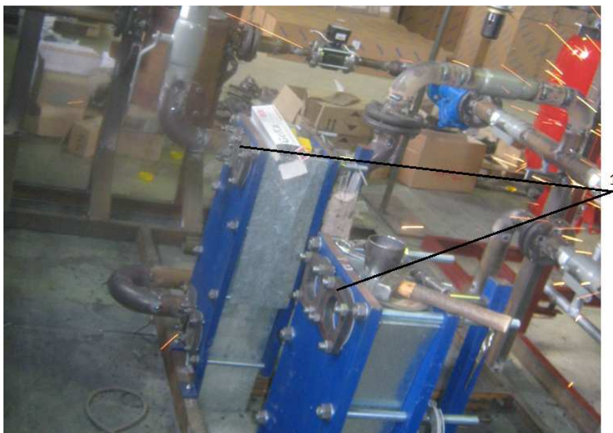
9-сурет – Ернемектердің пластина тәрізді жылу алмастырғыштың жылжымайтын тақтасына жалғанымы 1- біріктіргіш ернемек
