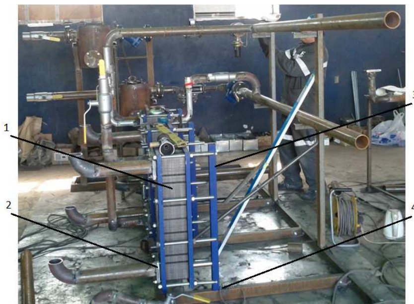
Рисунок 11 – Начало процесса обвязки пластинчатых теплообменников
