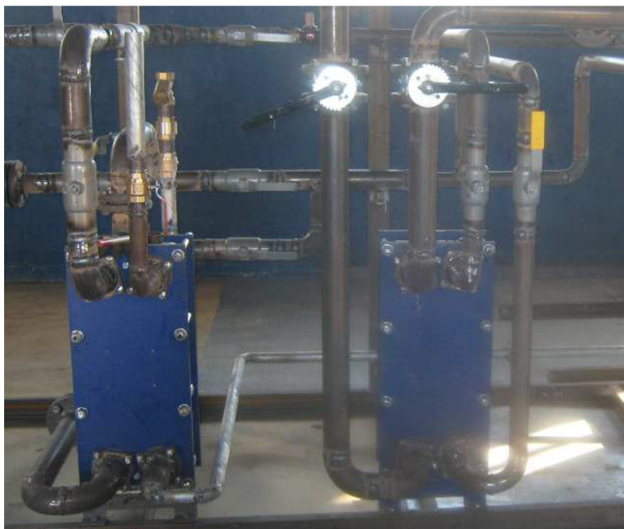
Рисунок 12 – Завершение обвязки пластинчатых теплообменников
