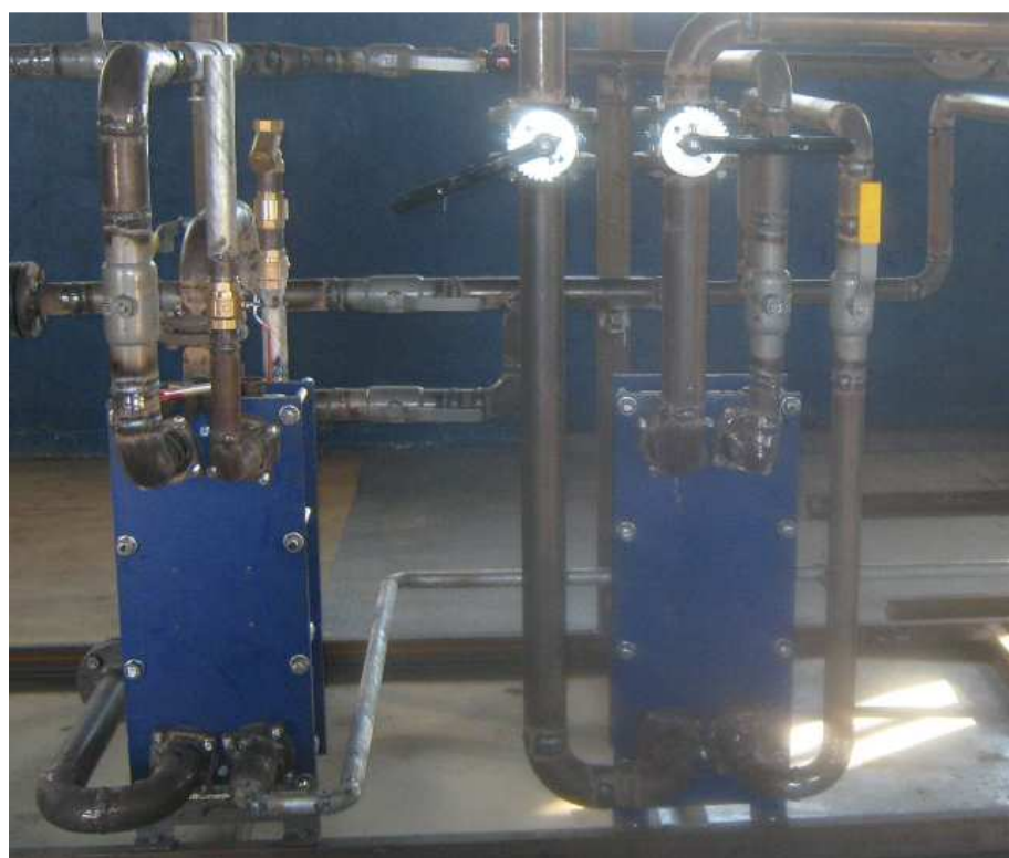
12-сурет – Пластина тәрізді жылу алмастырғыштарды орап байлаудың аяқталуы
