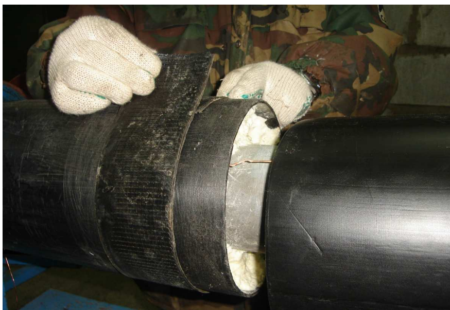
16-сурет – Қабыршақ-құбырда желімдік бітемелегіш таспаны бекіту операциясы
