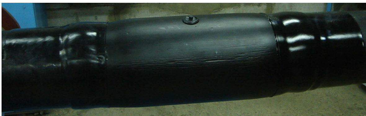
Рисунок 28 – Общий вид смонтированной термоусаживаемой муфты
