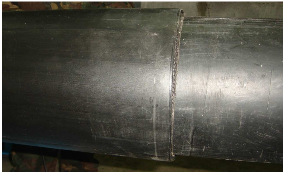
Рисунок 17 – Процесс установки термоусаживаемой муфты на место изолируемого сварного стыка
