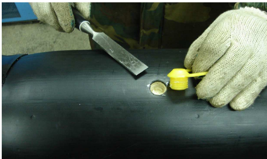
Рисунок 25 – Операция выпуска воздуха и последующего перекрытия заливочного отверстия при помощи пробки-воздушника
