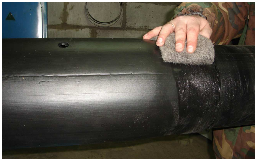
Рисунок 20 – Обработка растворителем на основе ацетона места усадки запорных манжет
