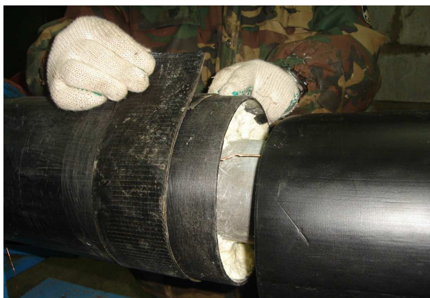
Рисунок 16 – Операция закрепления на трубе-оболочке клеевой герметизационной ленты
