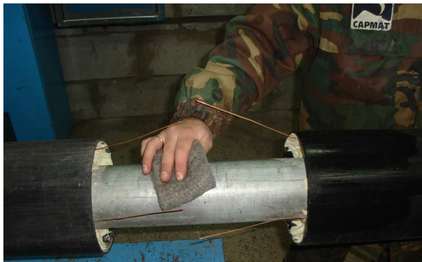
Рисунок 3 – Процесс механической очистки трубы от грязи
