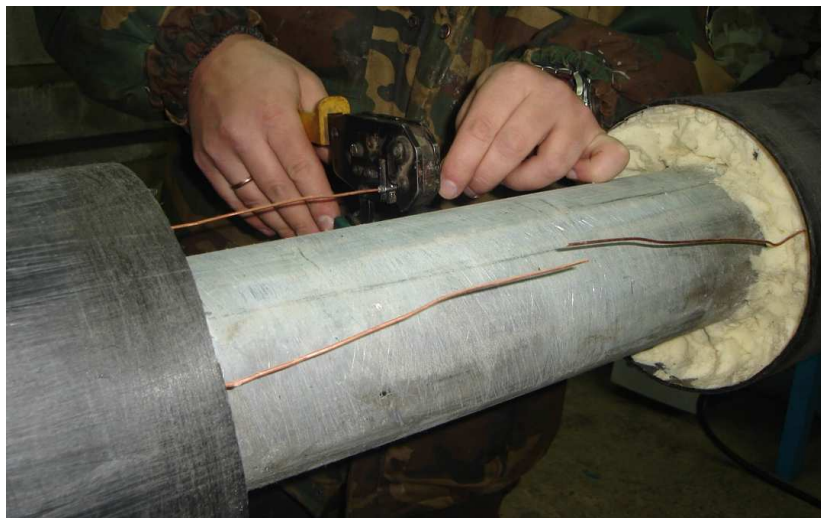
Рисунок 7 – Операция сращивания сигнальных проводов при помощи специальных обжимных клещей
