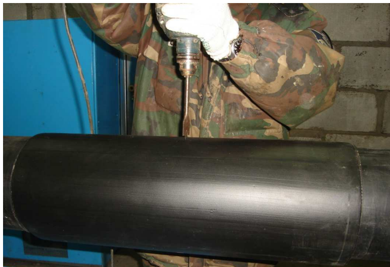
Рисунок 12 – Процесс устройства заливочного отверстия в термоусаживаемой муфте
