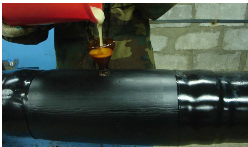
Рисунок 24 – Процесс заливки смеси компонентов пенополиуретана в полость термоусаживаемой муфты
