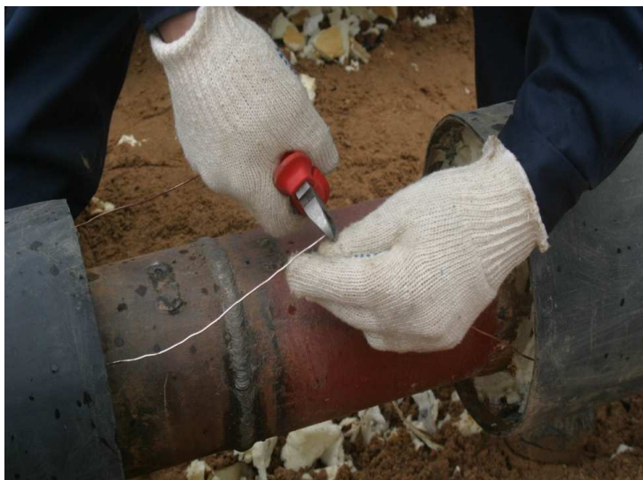
Рисунок 6 – Процесс обрезки сигнальных проводов для монтажа «встык»
