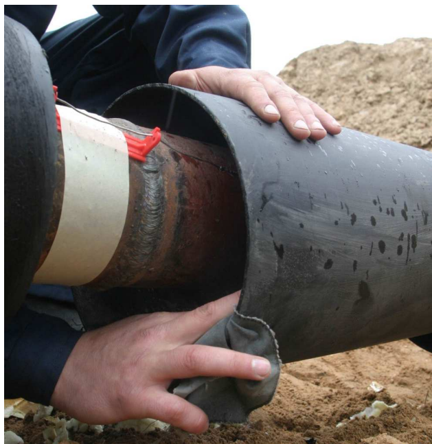
Рисунок 11 – Операция обезжиривания внутренней области усадки термоусаживаемой муфты
