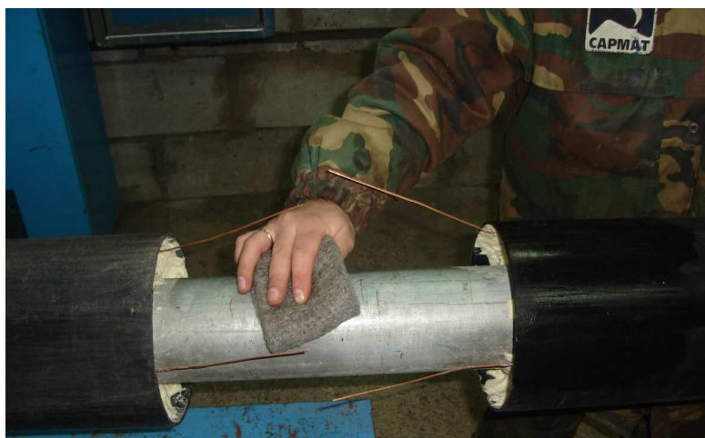
3-сурет – Құбырды лайдан механикалық тазалау барысы
