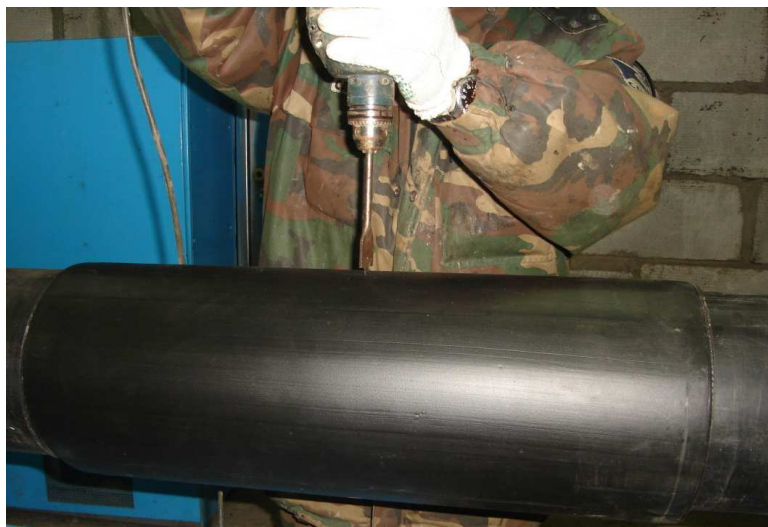
12-сурет – Термоотырғызылатын муфтада құю тесігі құрылғысының барысы
