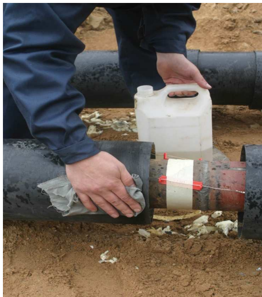
Рисунок 13 – Операция обезжиривания области усадки термоусаживаемой муфты на трубе-оболочке
