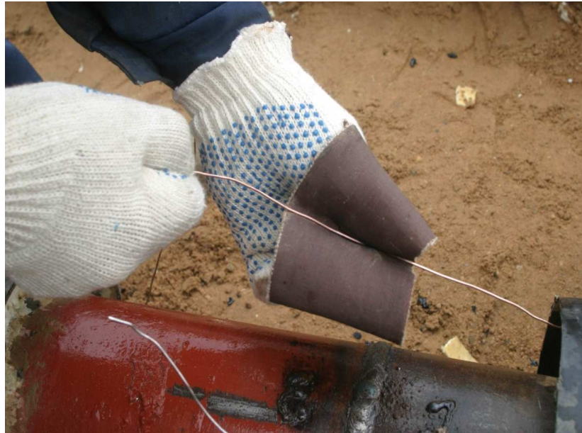
Рисунок 4 – Процесс выпрямления и зачистки проводов системы ОДК
