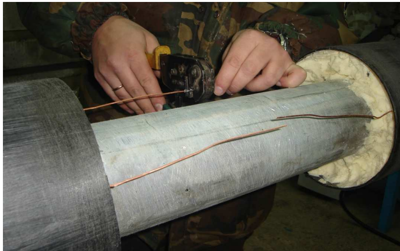
7-сурет – Арнайы қысқыш тістеуіктердің көмегімен дабылдық өткізгіштерді ұзарту операциясы
