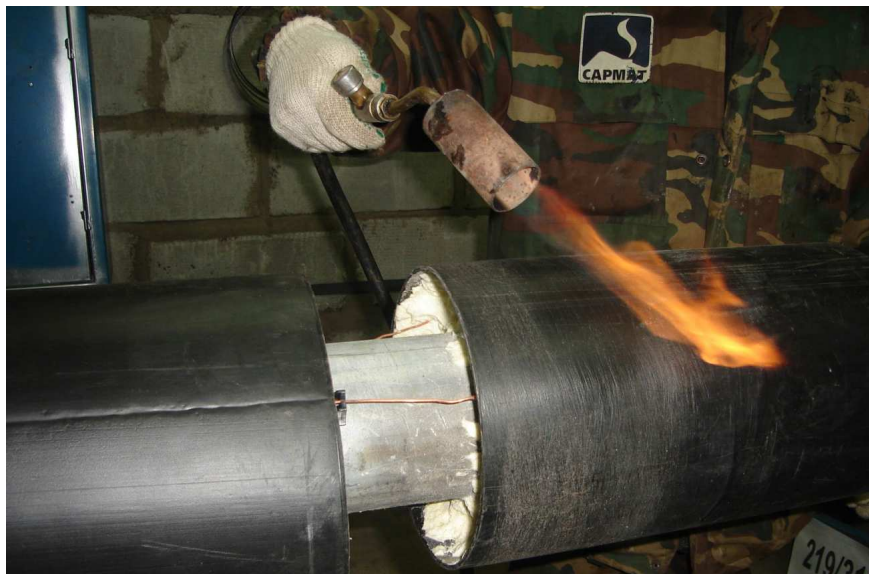
15-сурет – Желімдік бітемелегіш таспаны бекіту орнында қабыршақ-құбырды кептіру және қыздыру операциясы
