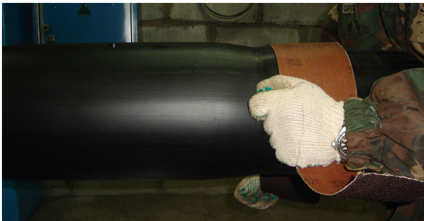
19-сурет – Муфтада және қабыршақ-құбырда термоотырғызылатын таспаны отырғызу орындарын зімпаралы қабықшамен өңдеу
