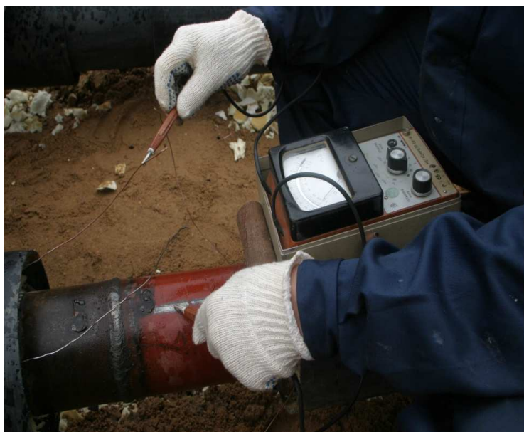
Рисунок 5– Операция измерения сопротивления изоляции перед началом монтажа системы ОДК
