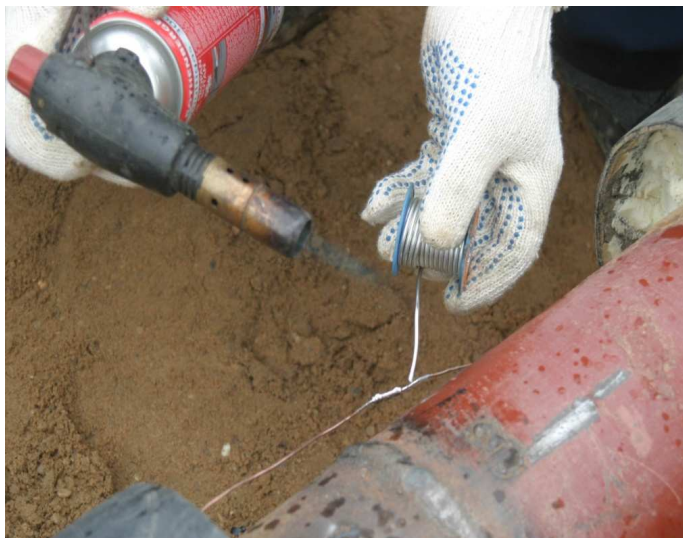
9-сурет – Арнайы тасымалды газбен дәнекерлегіштің көмегімен дабылдық өткізгіштердің жалғану орындарын дәнекерлеу барысы
