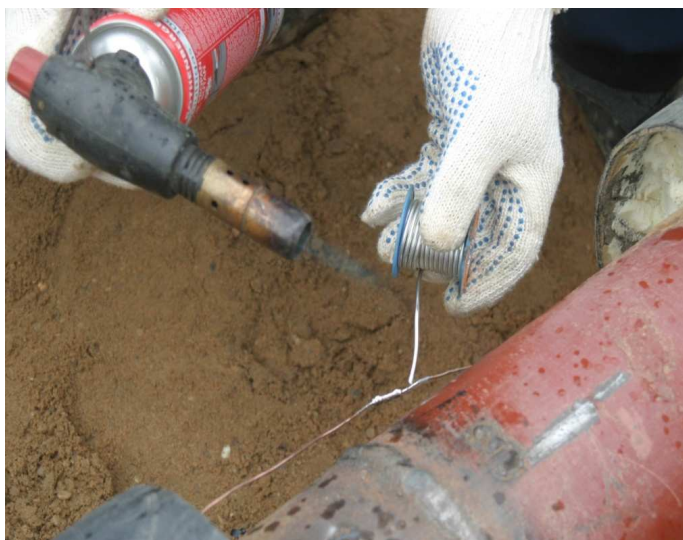
Рисунок 9 – Процесс пайки места соединения сигнальных проводов при помощи специального переносного газового паяльника
