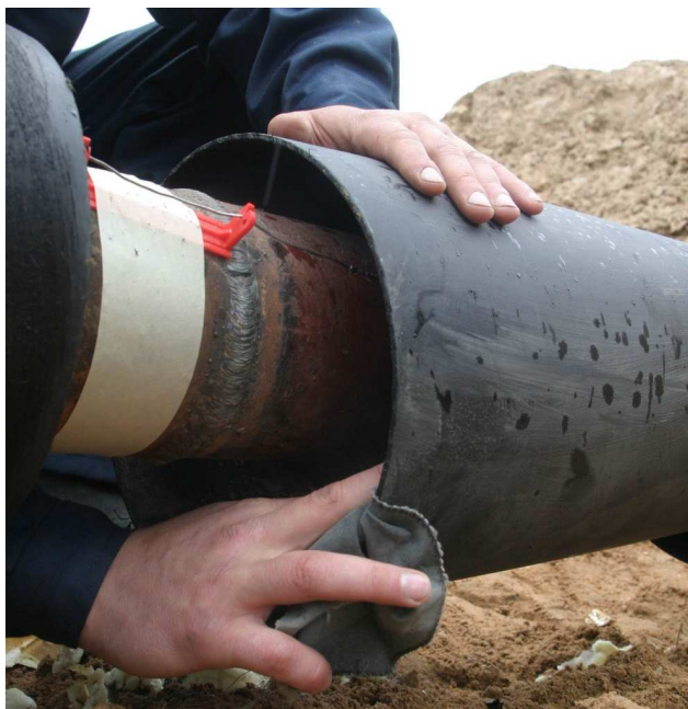
11-сурет – Термоотырғызылатын муфтаны отырғызудың ішкі аймағын майсыздандыру операциясы
