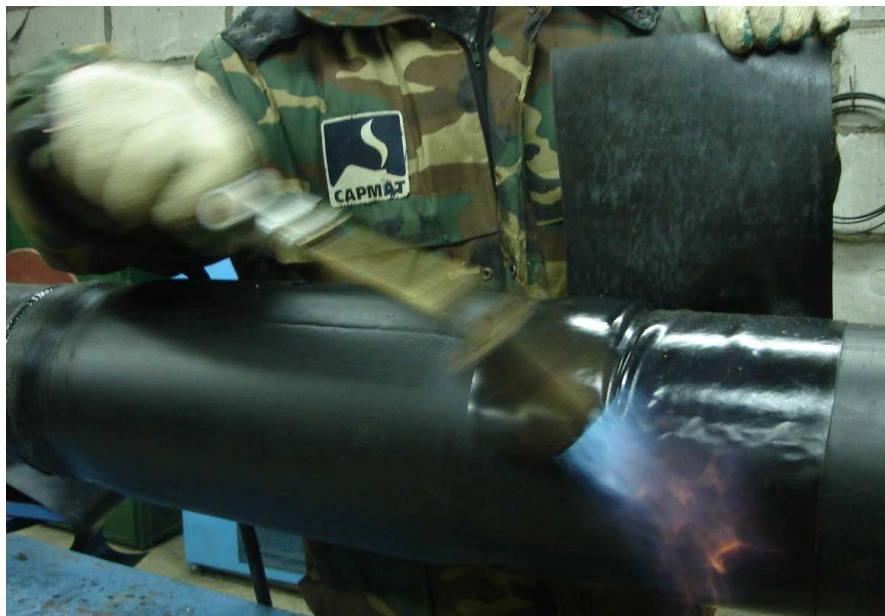
Рисунок 21 – Процесс усадки запорных манжет из термоусаживаемой ленты
