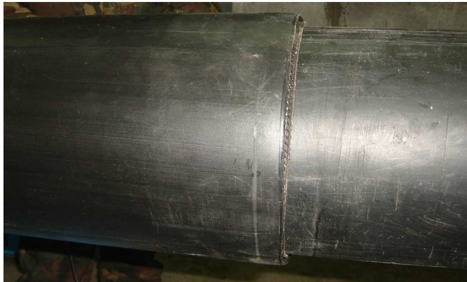
17-сурет – Термоотырғызылатын муфтаны оқшауланатын дәнекерленген жапсардың орнына орнату барысы
