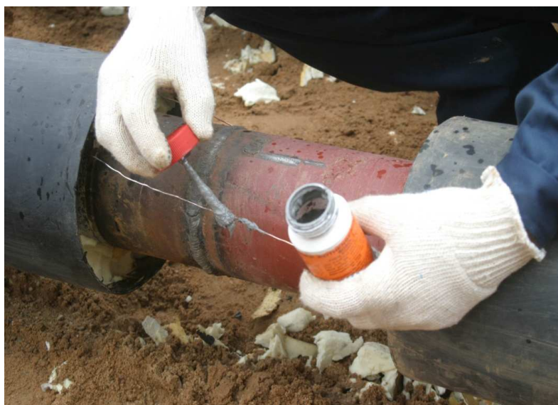
8-сурет – ЖҚБ жүйесінің өткізгіштері дәнекерлеу орнына белсенді емес флюсті жағу операциясы
