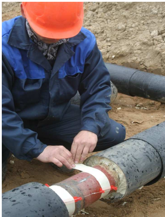
Рисунок 10 – Процесс монтажа держателей проводов и закрепления их на стальной трубе при помощи клейкой ленты
