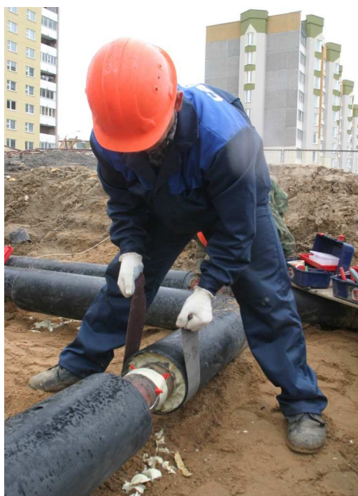
Рисунок 14 – Процесс зачистки трубы-оболочки в зоне усадки муфты
