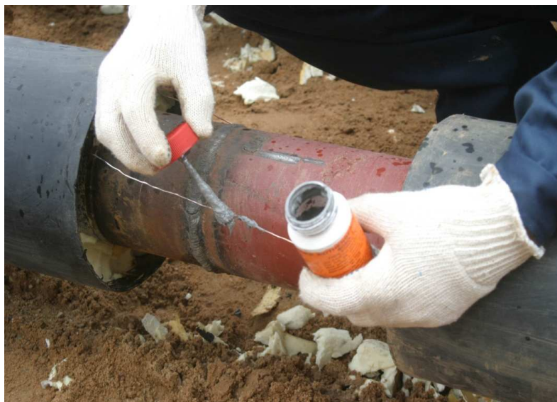
Рисунок 8 – Операция нанесения неактивного флюса на место пайки проводов системы ОДК
