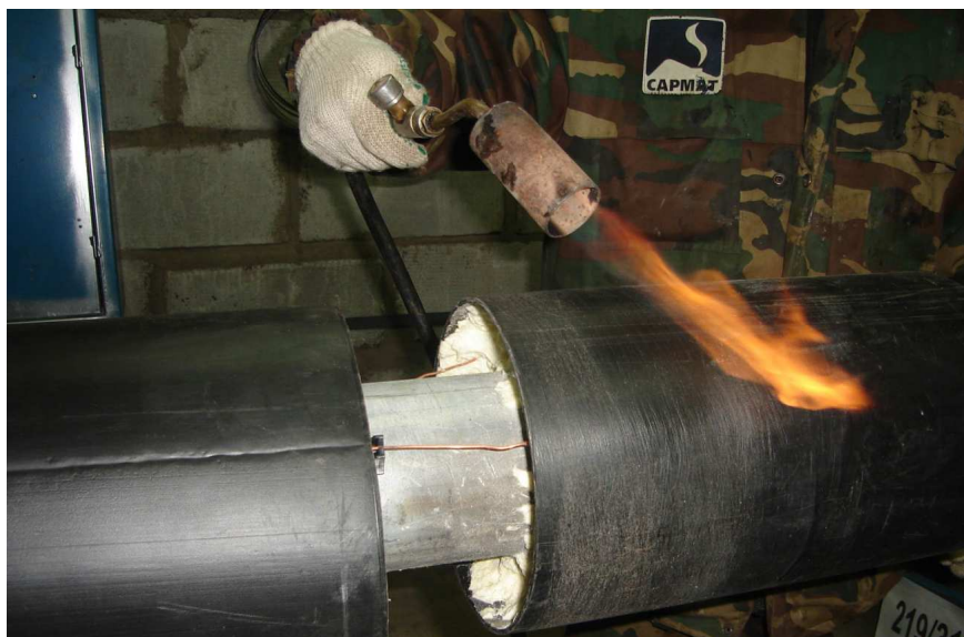
Рисунок 15 – Операция просушивания и разогрева трубы-оболочки в месте фиксации клеевой герметизационной ленты
