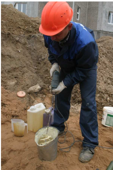
23-сурет – Арнайы саптамасы бар электр бұрғының көмегімен көбік-полиуретан құрамдауыштарын араластыру операциясы
