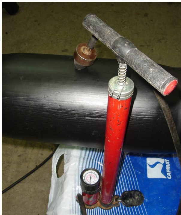
Рисунок 22 – Процесс опрессовки давлением воздуха внутренней полости смонтированной термоусаживаемой муфты
