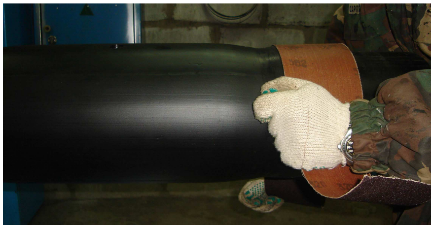
Рисунок 19 – Обработка наждачной шкуркой места усадки термоусаживаемой ленты на муфте и трубе-оболочке
