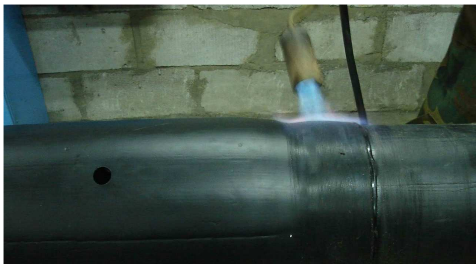
Рисунок 18 – Процесс усадки термоусаживаемой муфты при помощи газовой горелки
