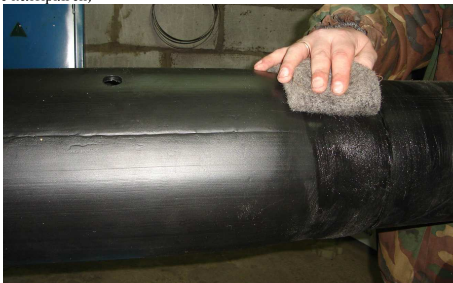
20-сурет – Бекіту манжеттерін отырғызу орындарын ацетон негізіндегі еріткішпен өңдеу
