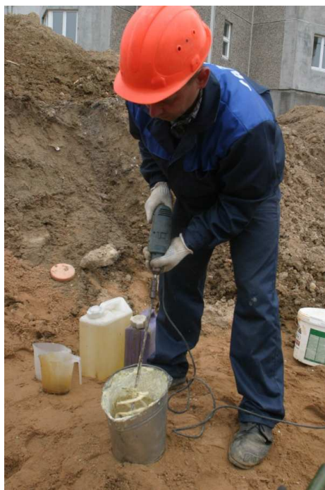
Рисунок 23 – Операция смешивания компонентов пенополиуретана при помощи электродрели со специальной насадкой
