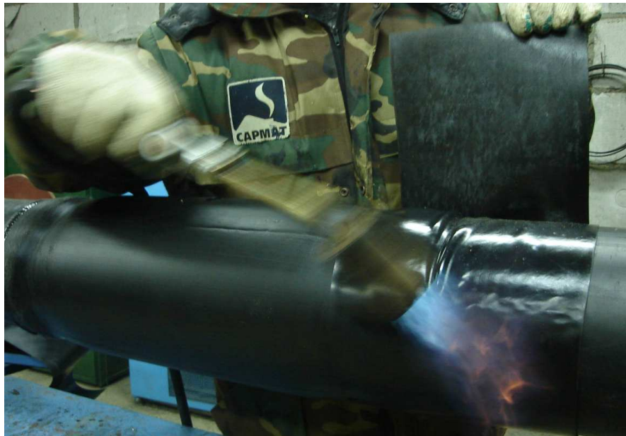
21-сурет – Термоотырғызылатын таспадан жасалған бекіту манжеттерін отырғызу барысы
