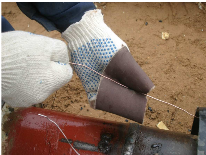
4-сурет – ЖҚБ жүйесінің өткізгіштерін түзету және тегістеу барысы
