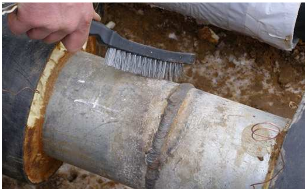
6-сурет - Дәнекерлеуден кейін жапсар учаскесінің сыртқы үстіңгі бетін тегістеу барысы
