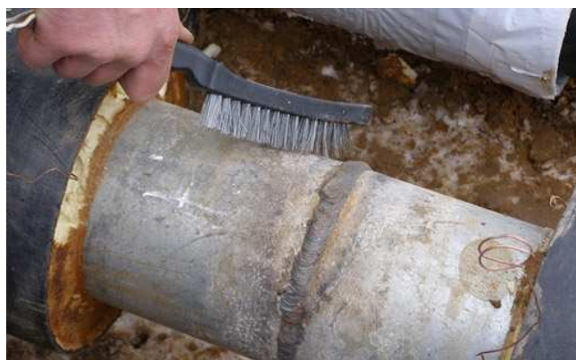
Рисунок 6 - Процесс зачистки наружной поверхности участка стыка после сварки
