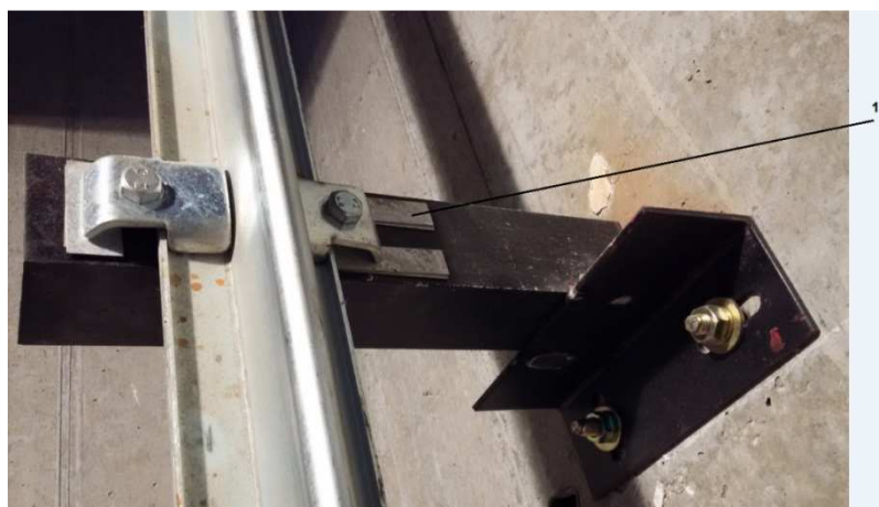
Рисунок 62 – Закрепленная направляющая (1 – пластина для регулировки)
