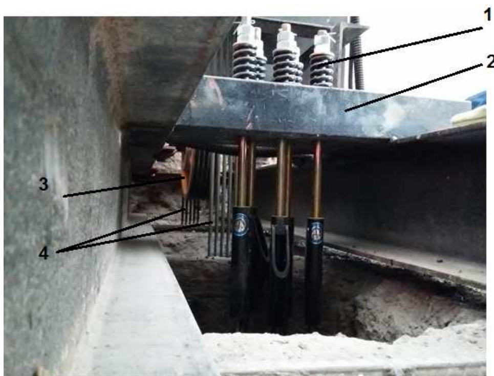
55-сурет – Арқандарды монтаждау (байлау)
