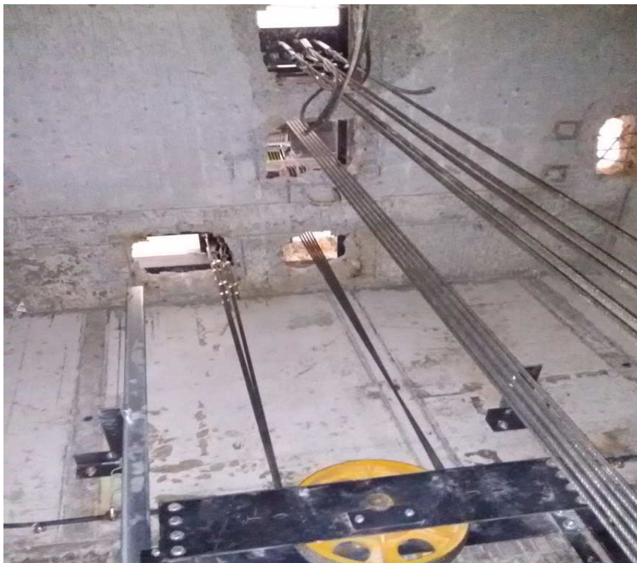
57-сурет – Арқандарды монтаждау (байлау)
