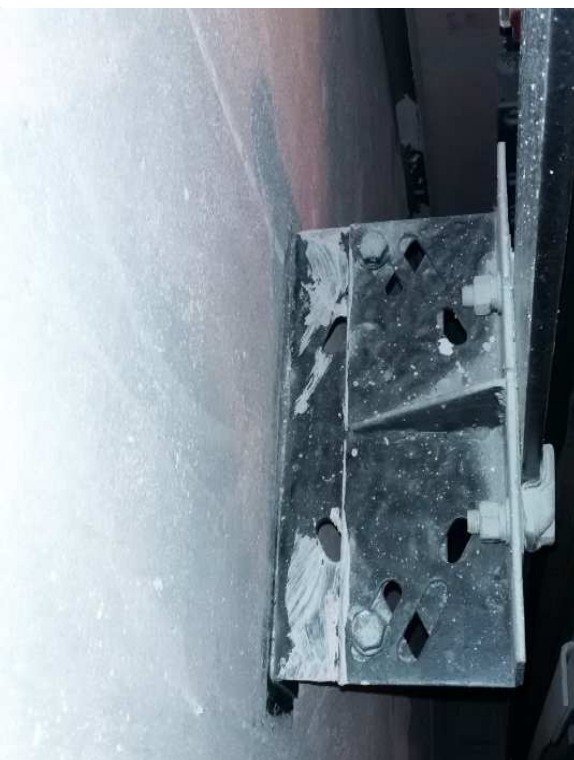
42-сурет – Кабина мен қарсы салмақтың кронштейндерге бекітілген бағыттағыштары
