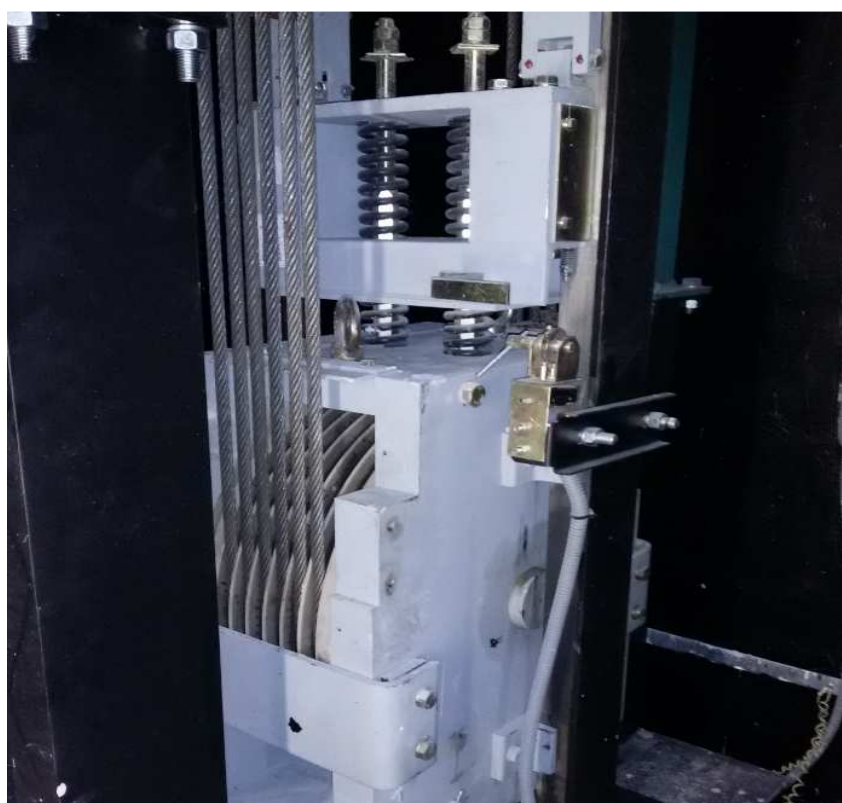
Рисунок 60 – Заправленный канатами компенсирующее устройство
