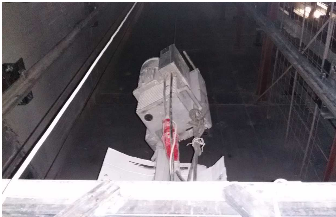
Рисунок 30 – Основная проходная монтажная лебедка
