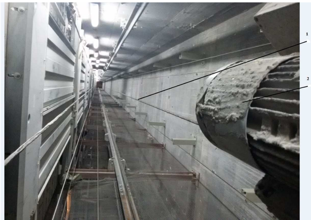
Рисунок 10 – Проходная монтажная лебедка в шахте
