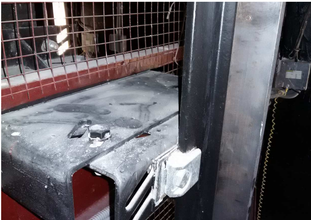
41-сурет – Кабинаның бөлу арқалығындағы кронштейні және бағыттағышы
