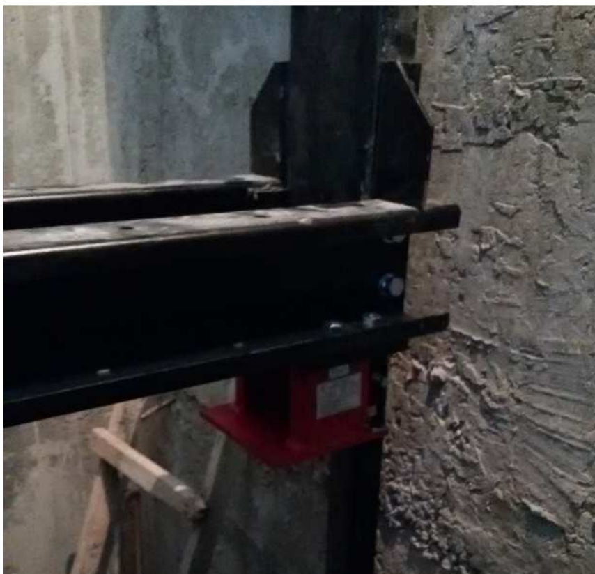
24-сурет – Кабина қаңқасының төменгі арқалығы мен тіреулерін монтаждау
