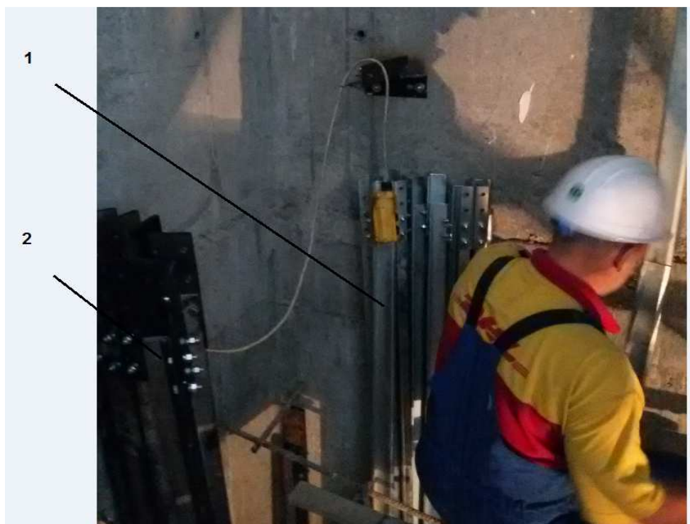
20-сурет – Кабина мен қарсы салмақ бағыттағыштарын шұңқырға түсіру
