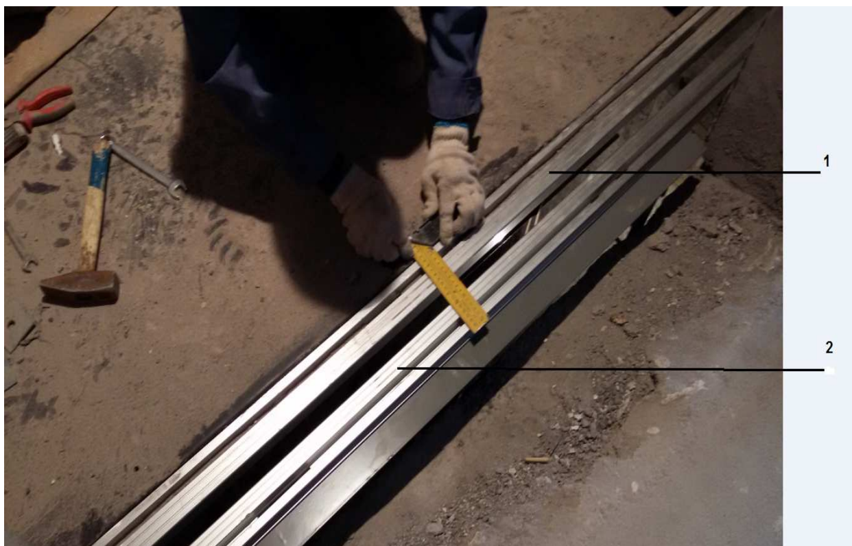
64-сурет – Кабинаның және қабат есіктерінің монтаждалған табалдырықтары 1 – кабина табалдырығы, 2 – қабат есігінің табалдырығы
