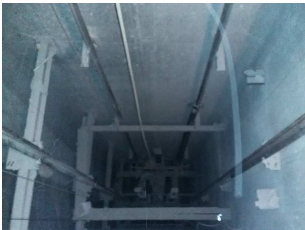
Рисунок 19 – Кронштейны и направляющие прямка шахты
