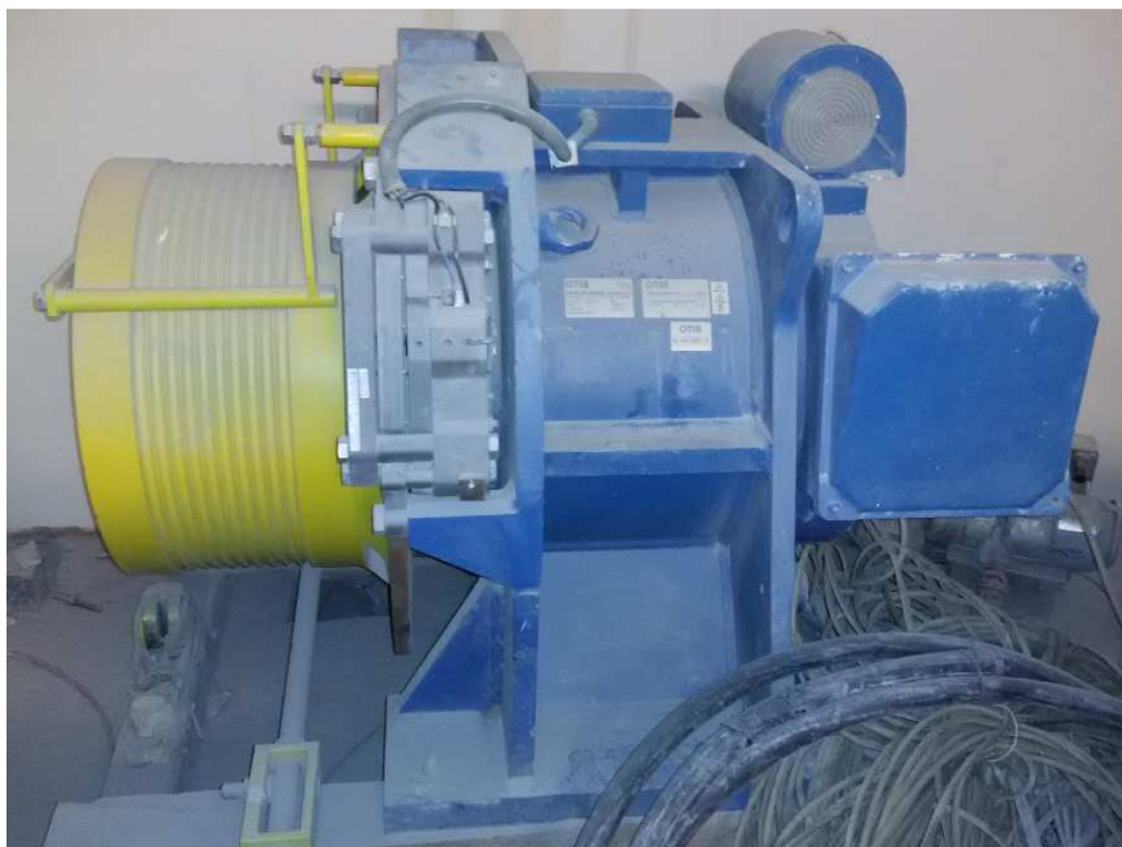
Рисунок 48 – Общий вид лифтовой лебедки
