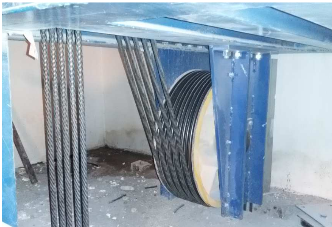
50-сурет – Лифт шығырының рамасындағы бұру блогы
