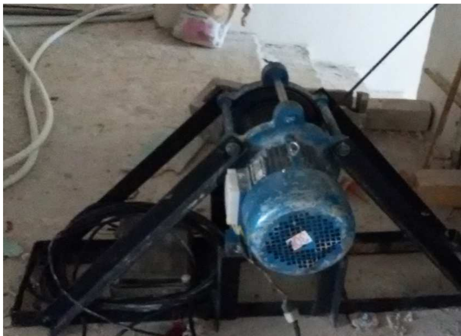
45-сурет – Лифт шығырын монтаждауға арналған монтажда шығыры
