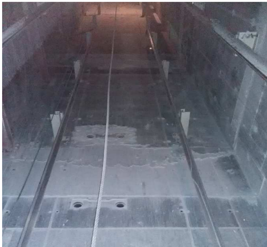
43-сурет – Кабина мен қарсы салмақтың лифт шахтасындағы бағыттағыштары
