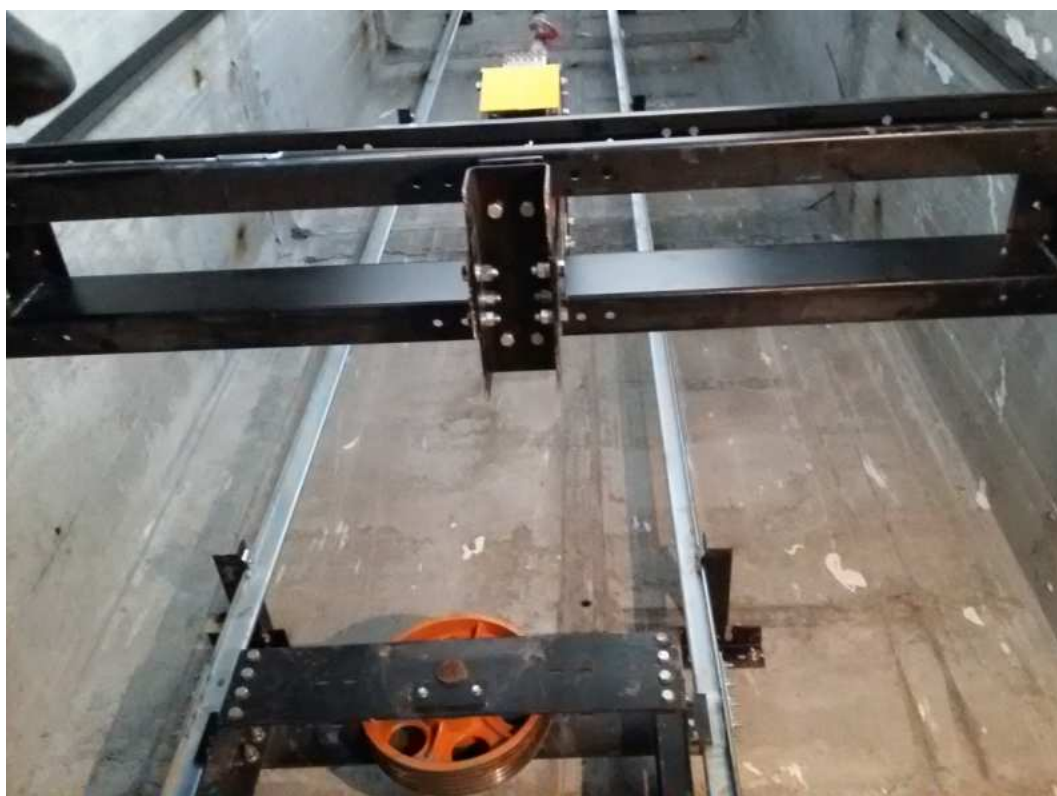
27-сурет – Кабина қаңқасының еденін монтаждау
