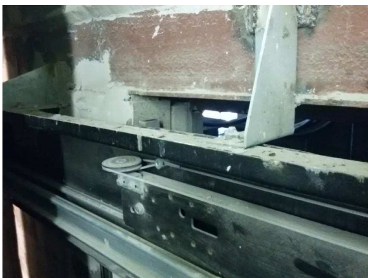
70-сурет – Шахта есіктерінің аспалы тетігін (бастиегін) монтаждау
