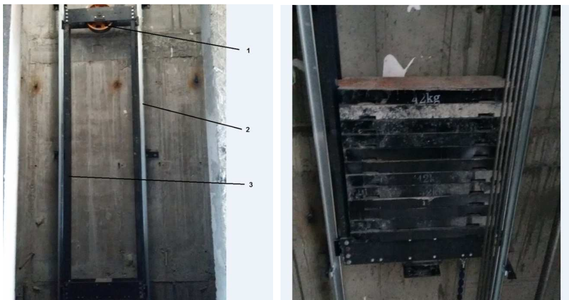
22-сурет – Қарсы салмақты бағыттағышқа монтаждау
