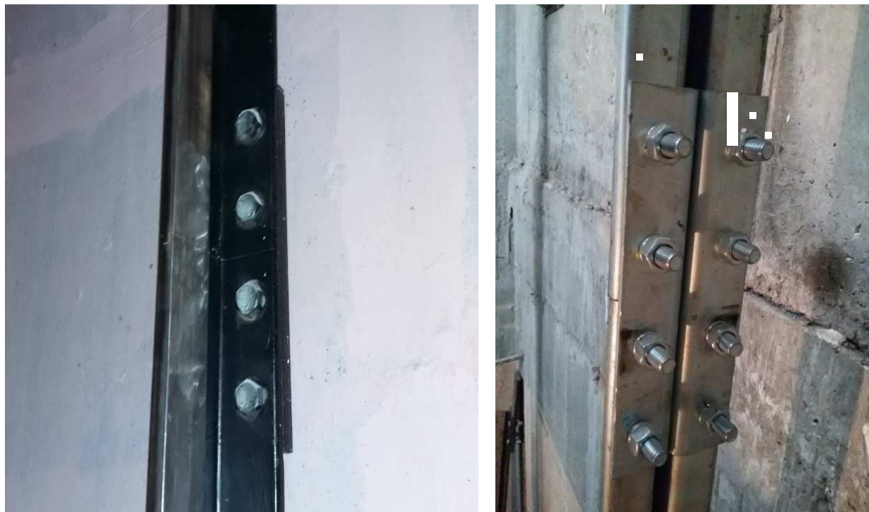
Рисунок 41 – Стык направляющих кабины и противовеса
