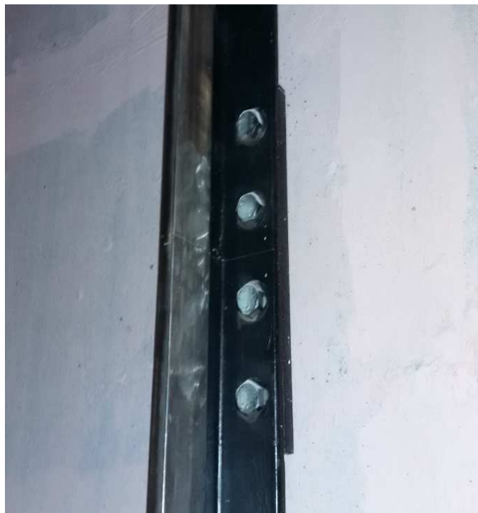
41-сурет – Кабина мен қарсы салмақ бағыттағыштарының түйісуі
