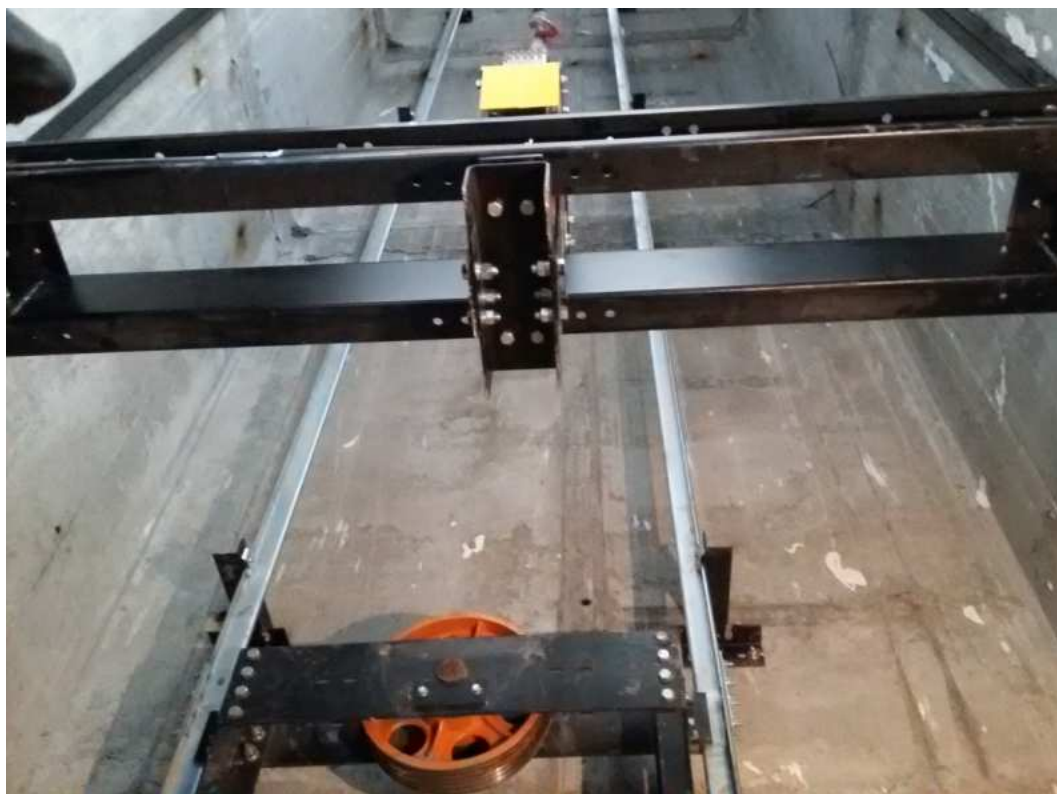
Рисунок 28 – Смонтированные верхняя балка с отводным блоком и противовес
