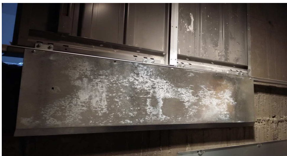
Рисунок 73 – Фартук шахтных дверей
