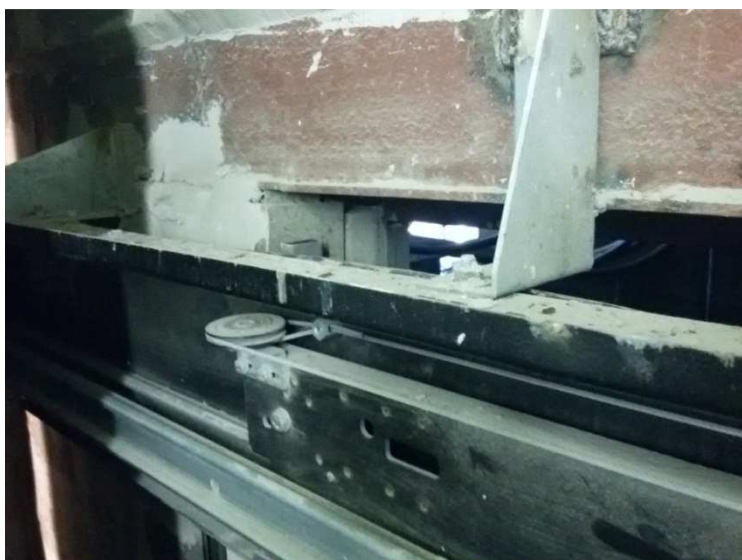
Рисунок 70 – Монтаж подвесного механизма (головки) шахтных дверей
