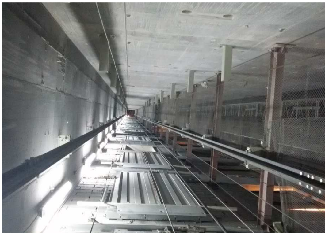
37-сурет – Бағыттағыштар және кронштейндер бар лифт шахтасы
