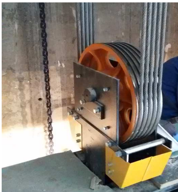
56-сурет – Арқандарды монтаждау (байлау)
