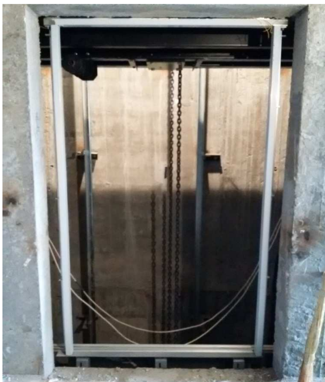
Рисунок 66 – Установленное обрамление этажных дверей
