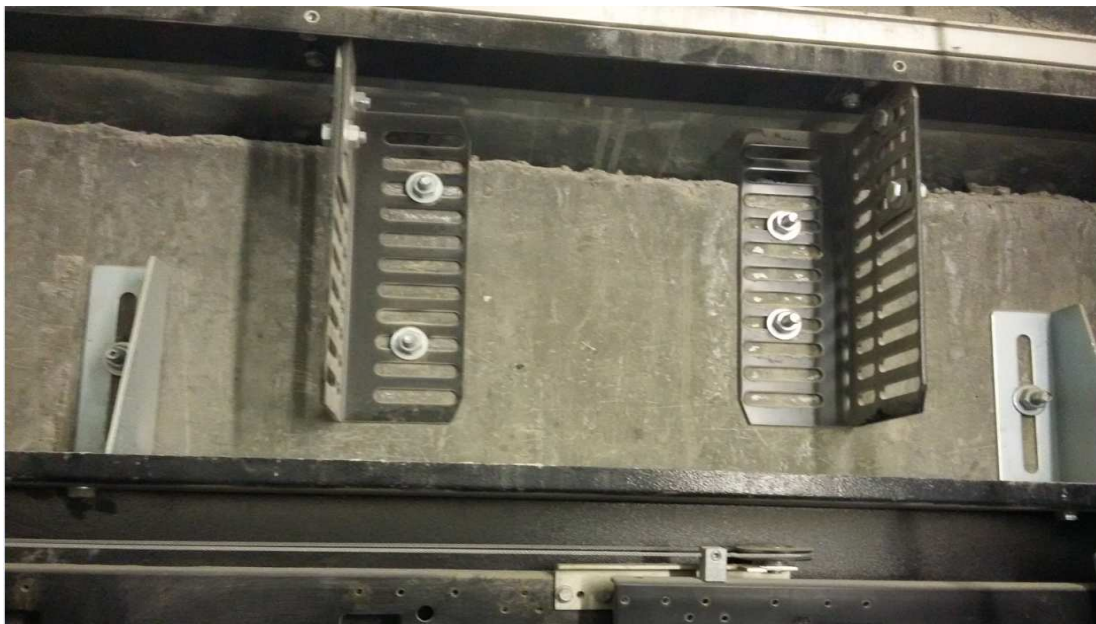
Рисунок 68 – Крепление порога на анкерных болтах
