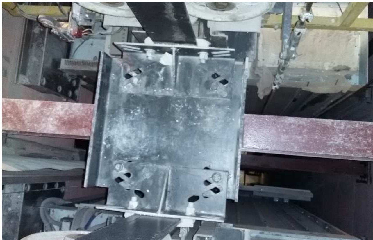
Рисунок 39 – Кронштейн кабины на разделительной балке
