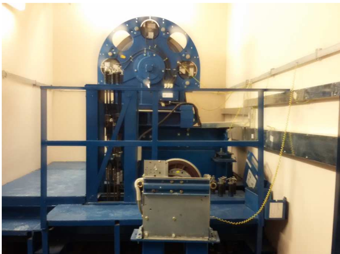
Рисунок 51 – Лифтовая лебедка после монтажа
