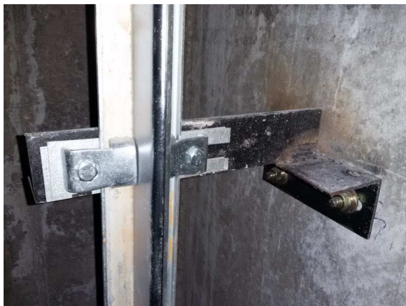
Рисунок 63 – Кронштейн противовеса
