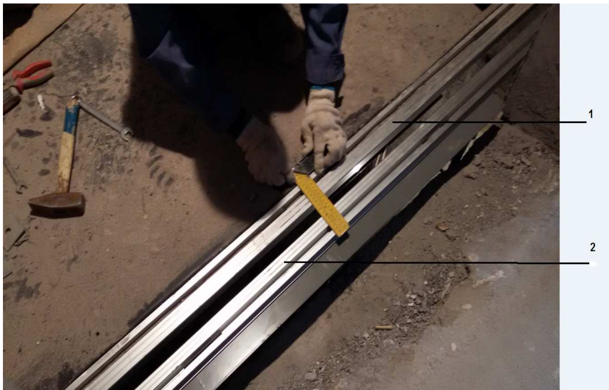
Рисунок 64 – Смонтированные пороги кабины и этажных дверей 1 – порог кабины, 2 – порог этажной двери
