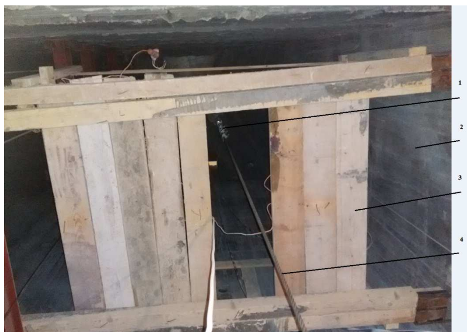
9-сурет – Өтпелі монтаждау шығырын лифт шахтасына бекіту торабы 1 - өтпелі монтаждау шығырын бекіту торабы, 2 – лифт шахтасы, 3 – төсемдер, 4 өтпелі монтаждау шығырының тросы
