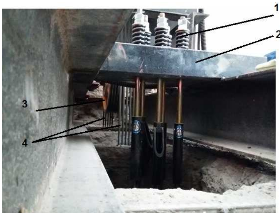
Рисунок 55 – Монтаж (запасовка) канатов
