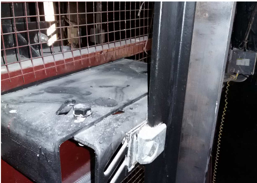
Рисунок 41 – Кронштейн и направляющая кабины на разделительной балке
