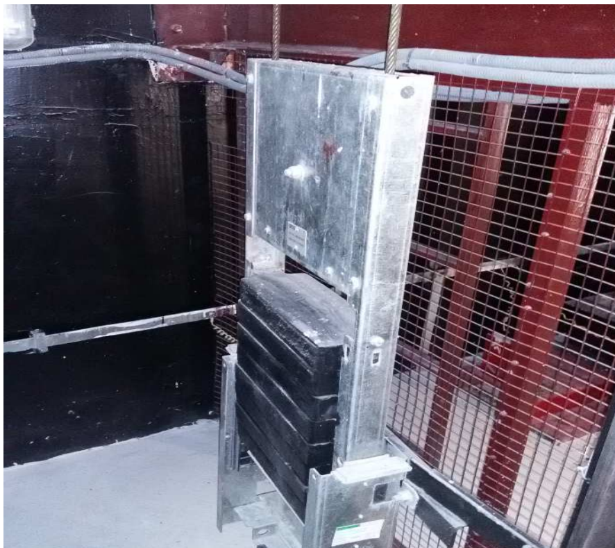
Рисунок 18 – Натяжное устройство ограничителя скорости с противовесом в приемке шахты
