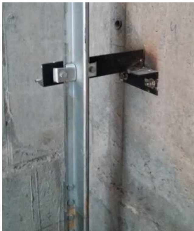
42-сурет – Кабина мен қарсы салмақтың кронштейндерге бекітілген бағыттағыштары
