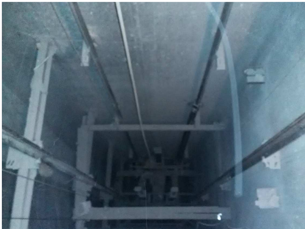
19-сурет – Шахта шұңқырының кронштейндері мен бағыттағыштары
