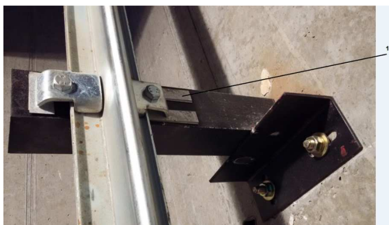
62-сурет – Бекітілген бағыттағыш (1 – реттеуге арналған пластина)
