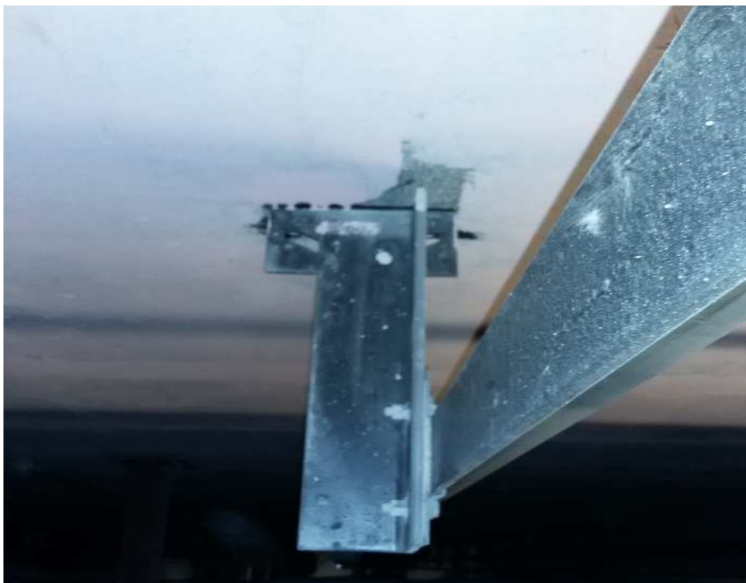
Рисунок 38 – Кронштейн противовеса
