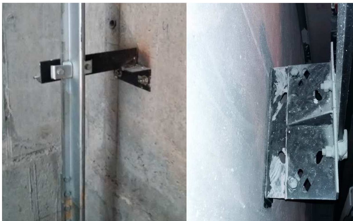
Рисунок 42 – Закрепленные к кронштейнам направляющие кабины и противовеса
