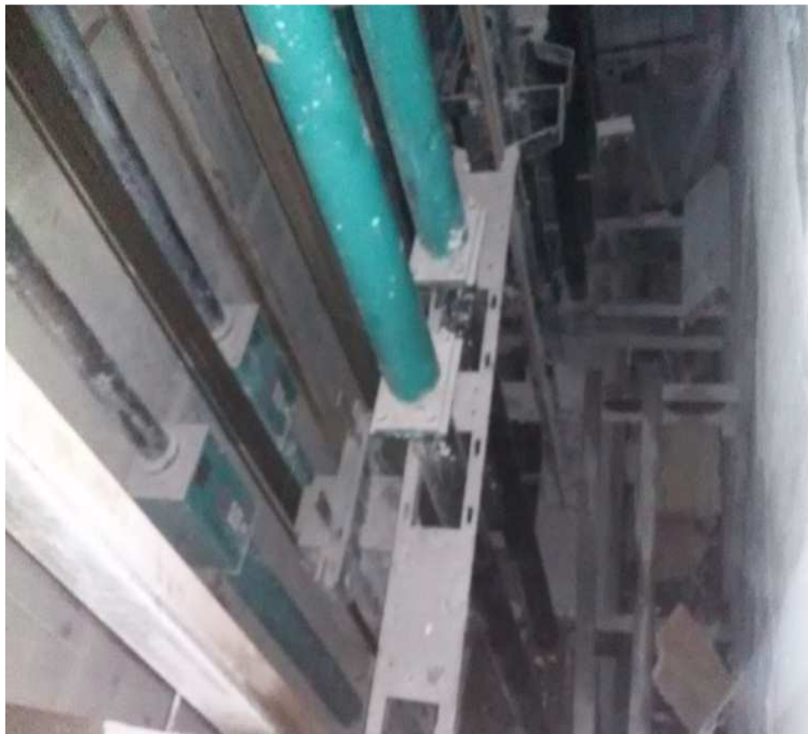
13-сурет – Кабина мен қарсы салмақтың шахта шұңқырында монтаждalған гидравликалық буферлері
