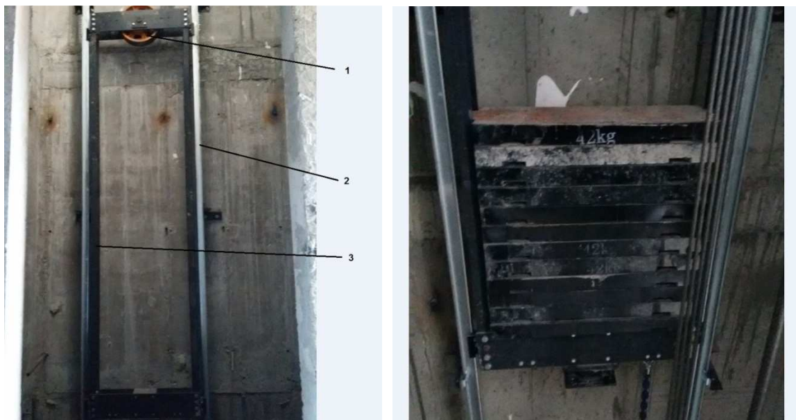
Рисунок 22 – Монтаж противовеса на направляющие
