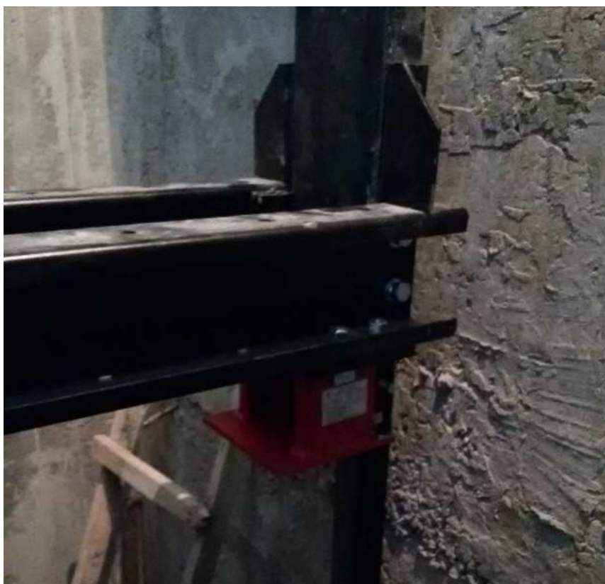
Рисунок 24 – Монтаж нижней балки и стоек каркаса кабины
