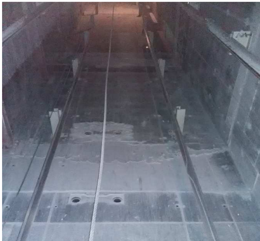
Рисунок 43 – Направляющие кабины и противовеса в шахте лифта
