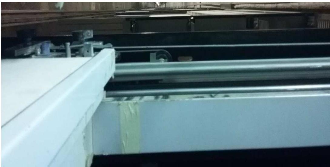
Рисунок 72 – Монтаж шахтных дверей (створок)
