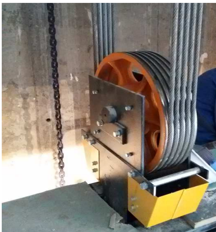
Рисунок 56 – Монтаж (запасовка) канатов
