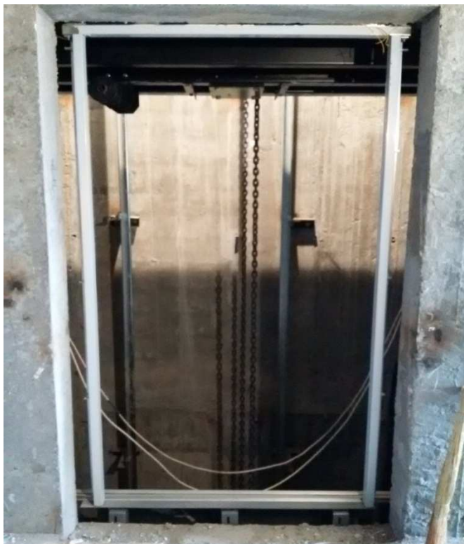
66-сурет – Қабат есіктеріне орнатылған көмкерме
