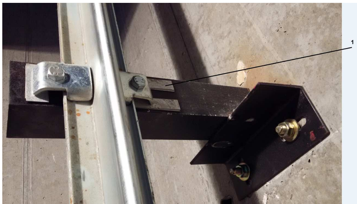
55-сурет – Бекітілген бағыттағыш 1 – реттеуге арналған пластина
