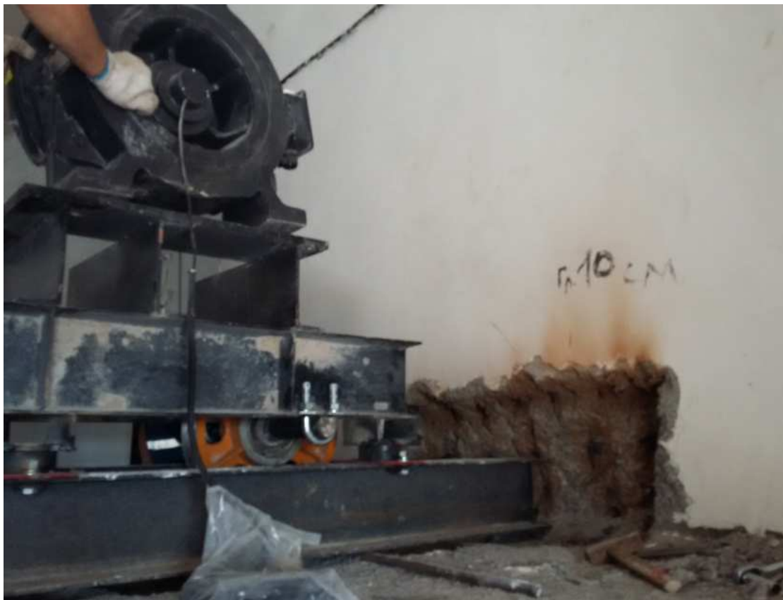
37-сурет – Лифт шығырын монтаждау
