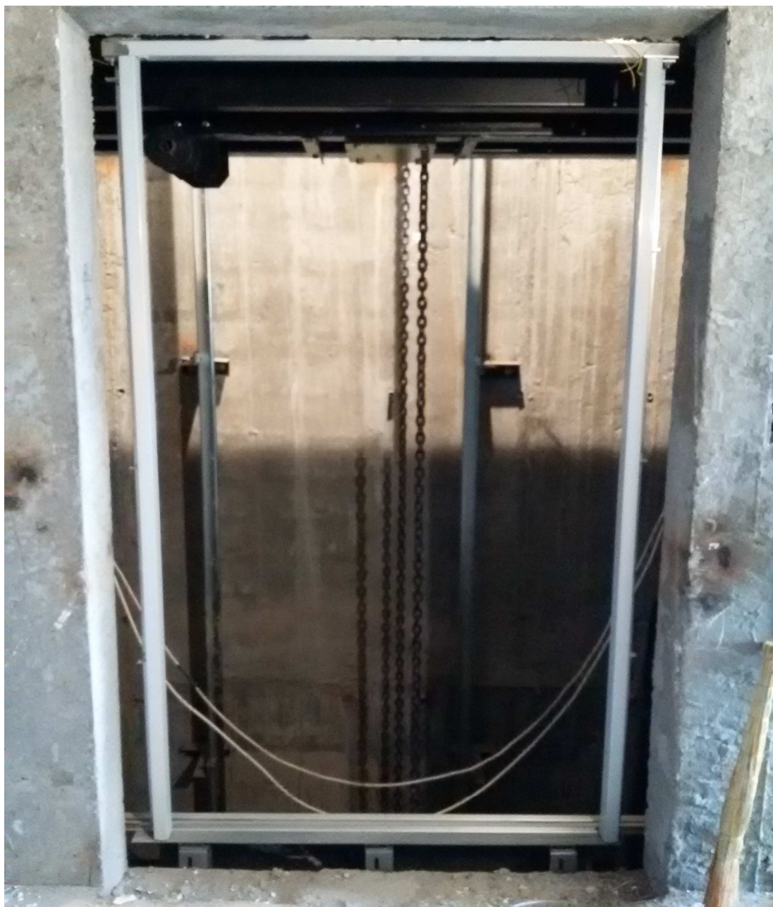
62-сурет – Қабат есіктеріне орнатылған көмкерме
