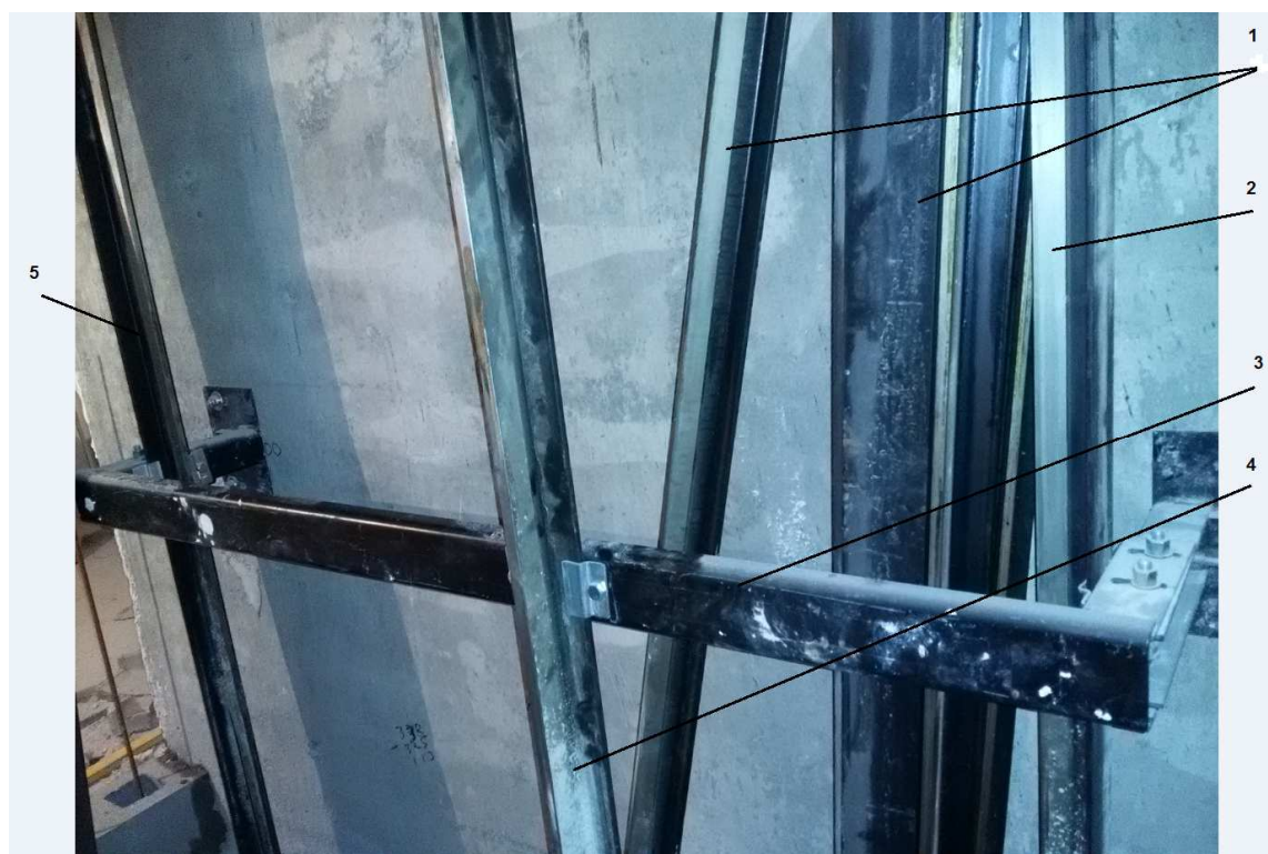
1 – направляющие подготовленные в прямке для монтажа (вытяжки), 2 и 5 – направляющие противовеса, 3 – П-образный цельный кронштейн для направляющих противовеса и кабины, 4 – направляющая кабины.
