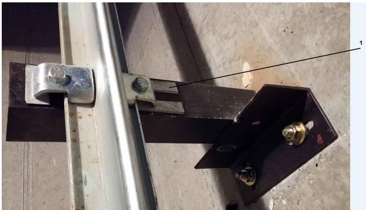
Рисунок 55 – Закрепленная направляющая
