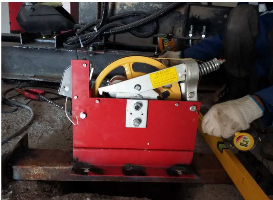
59-сурет – Жылдамдық өлшегішті монтаждау
