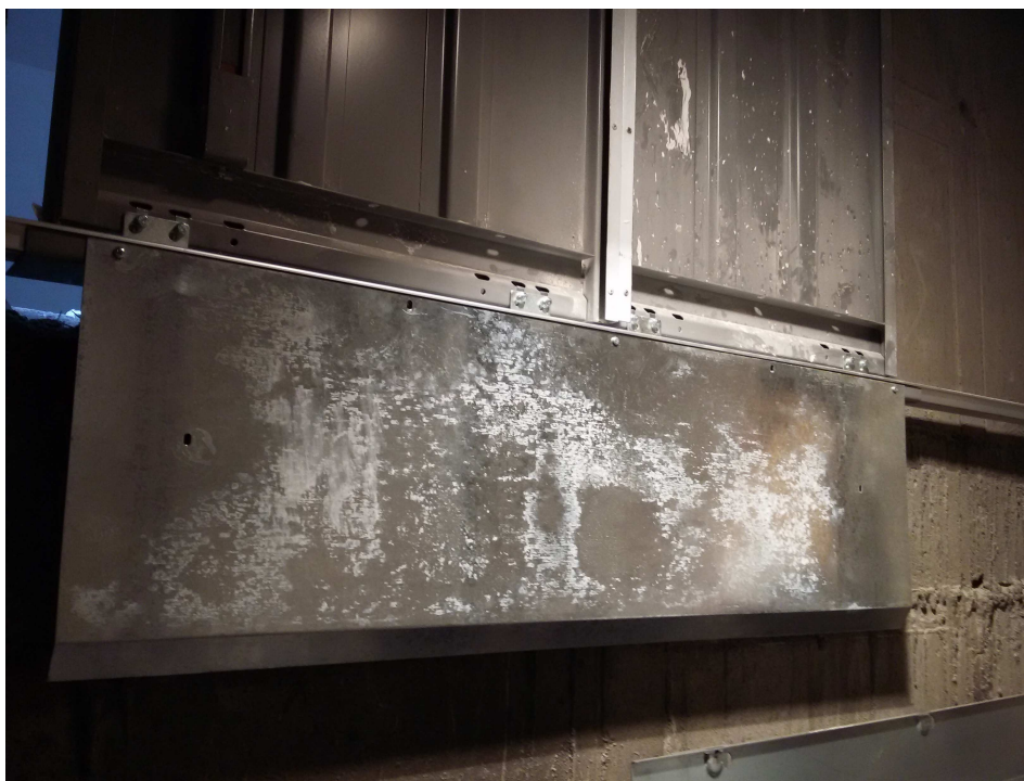
Рисунок 67 – Фартук шахтных дверей
