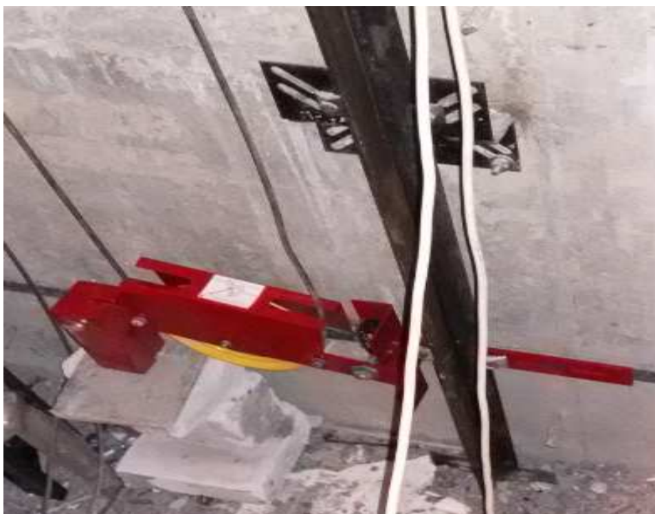
60-сурет – Шахта шұңқырындағы бұру блогы бар жылдамдық өлшегіш кронштейні
