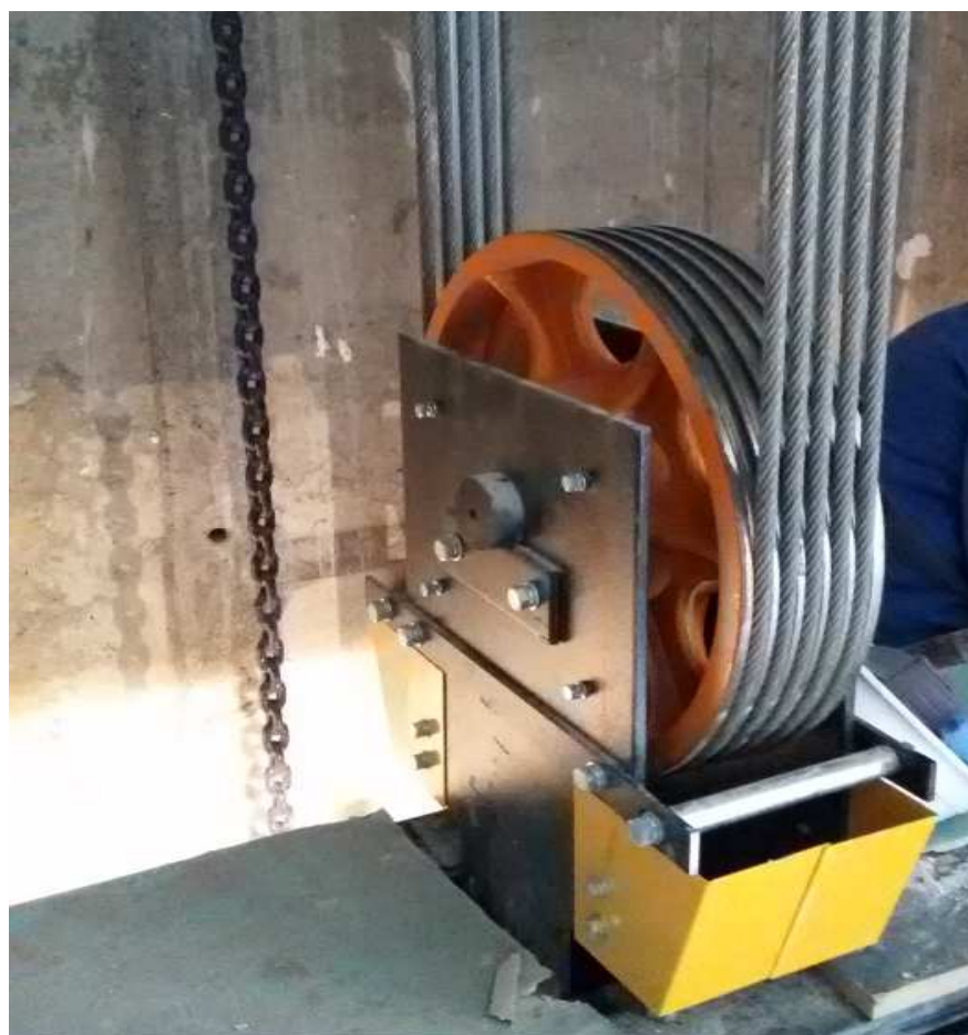
Рисунок 46 – Монтаж (запасовка) канатов
