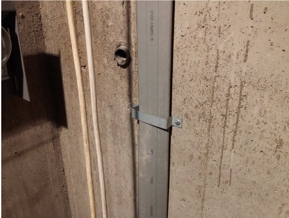
70-сурет – Шахтадағы аспалы кабелді бекіту
