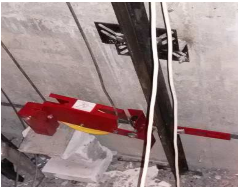
Рисунок 60 – Кронштейн ограничителя скорости с отводным блоком в прямке шахты
