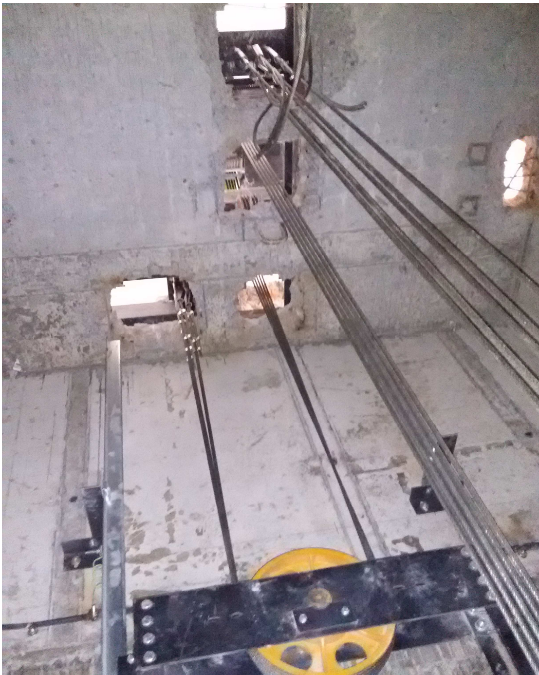
Рисунок 48 – Монтаж (запасовка) канатов
