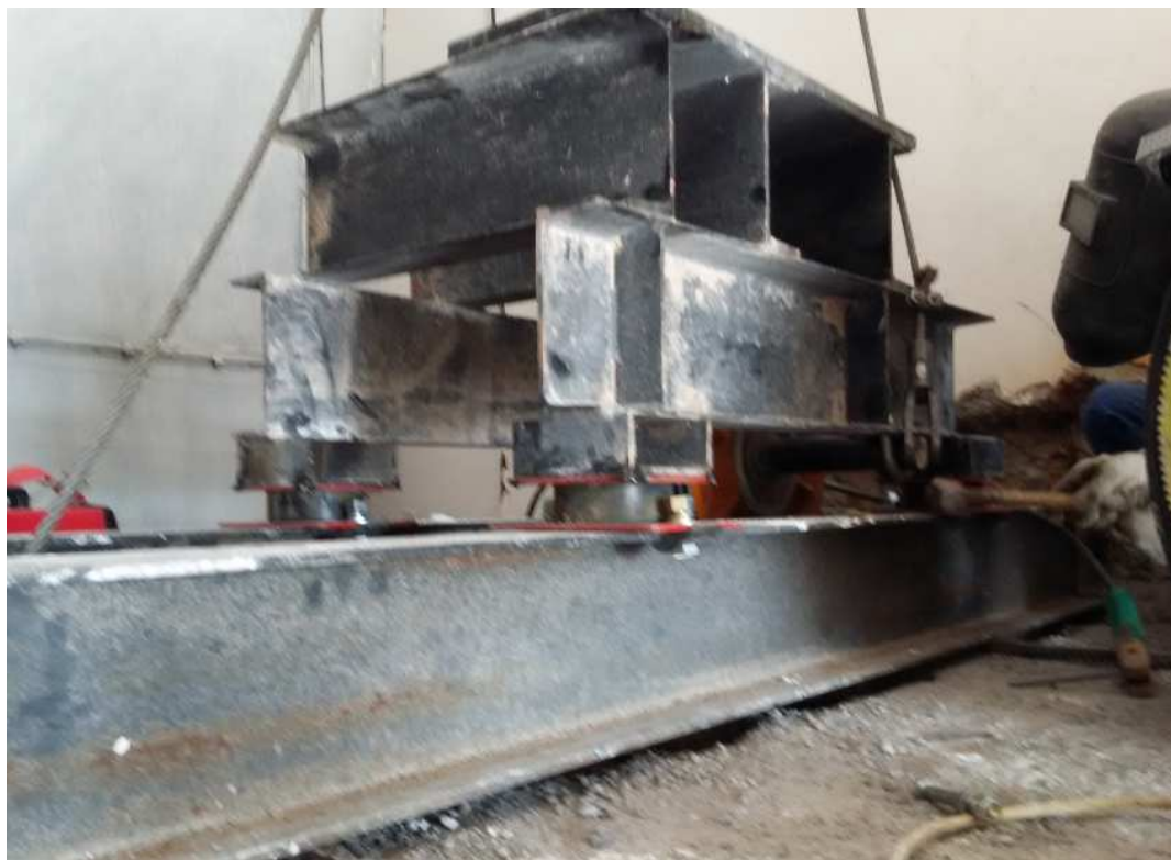
36-сурет – Лифт шығырының тұғырын монтаждау
