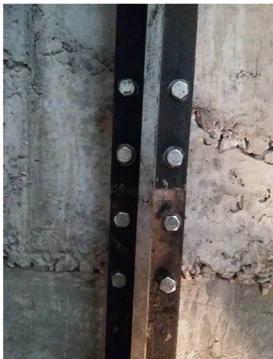
Рисунок 20 – Стык направляющих кабины и противовеса
