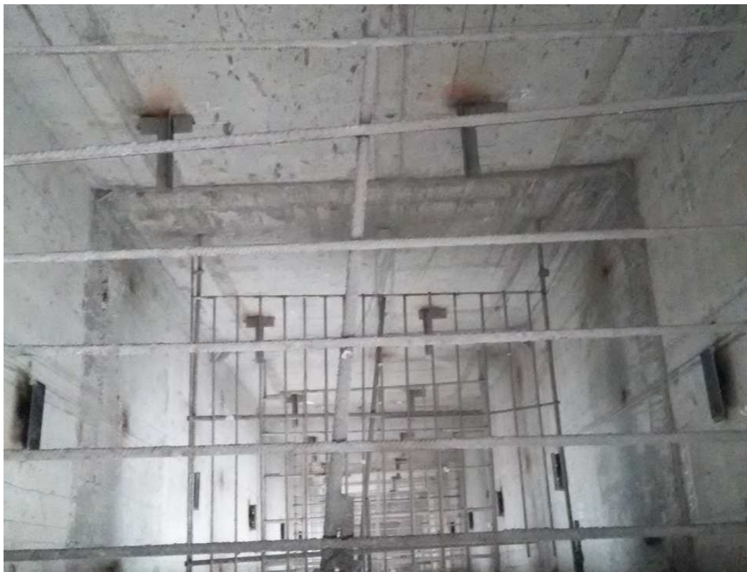
Рисунок 18 – Кронштейны кабины и противовеса шахты при заднем расположении противовеса
