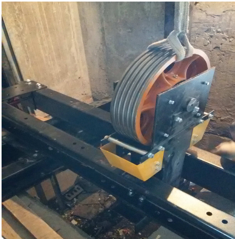
25-сурет – Қаңқаның жоғарғы арқалығын және кабина шкивін монтаждау
