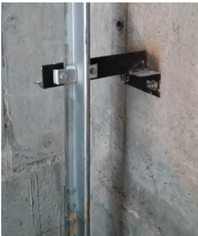
21-сурет – Кабина мен қарсы салмақтың бағыттағыштарын кронштейндерге бекіту
