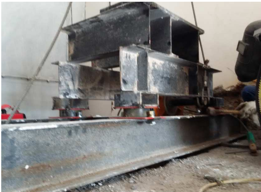
Рисунок 36 – Монтаж станины лифтовой лебедки
