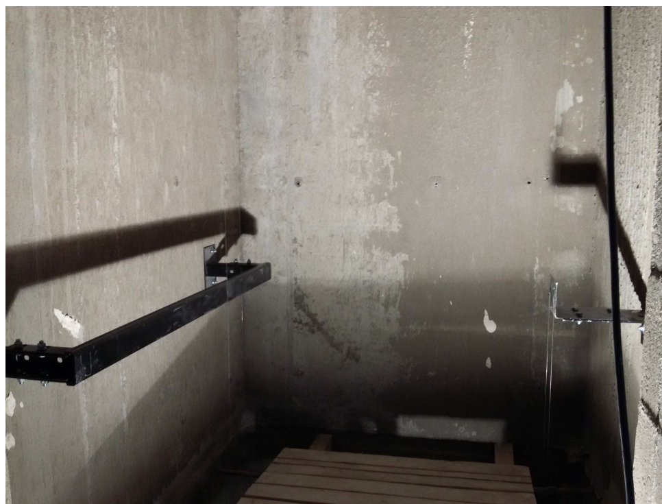
Рисунок 15 – Кронштейн кабины и противовеса при боковом расположении противовеса
