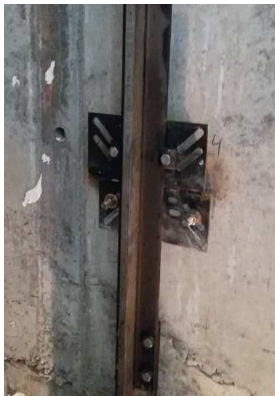
21-сурет – Кабина мен қарсы салмақтың бағыттағыштарын кронштейндерге бекіту
