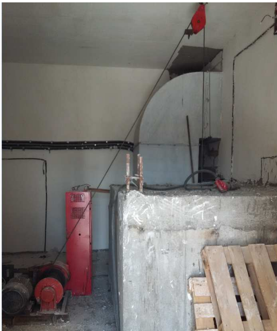
Рисунок 10 – Монтажная лебедка при наличии машинного помещения
