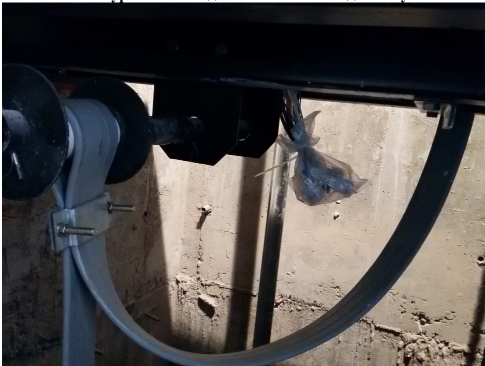
70-сурет – Шахтадағы аспалы кабелді бекіту
