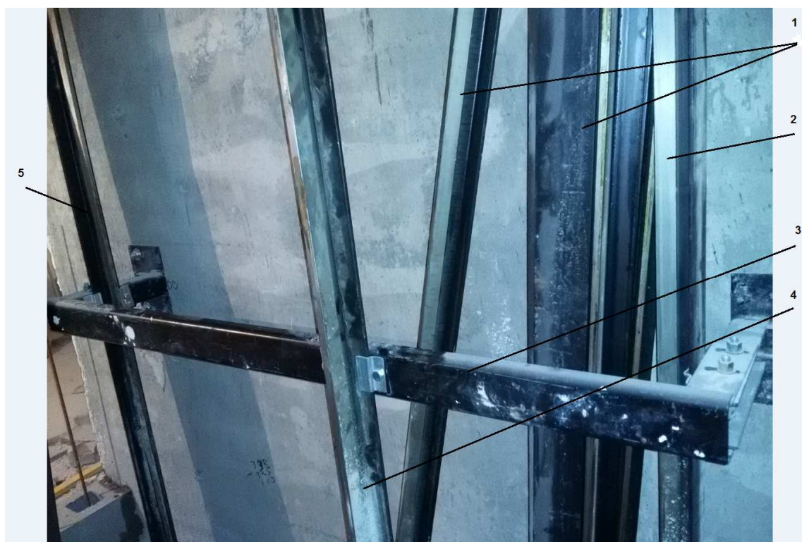
1 – шұңқырда монтаждау (тарту) үшін дайындалған бағыттағыштар, 2 және 5 – қарсы салмақ бағыттағыштары, 3 – кабина мен қарсы салмақ бағыттағыштары үшін II тәріздес тұтас кронштейн, 4 – кабина бағыттағышы.
