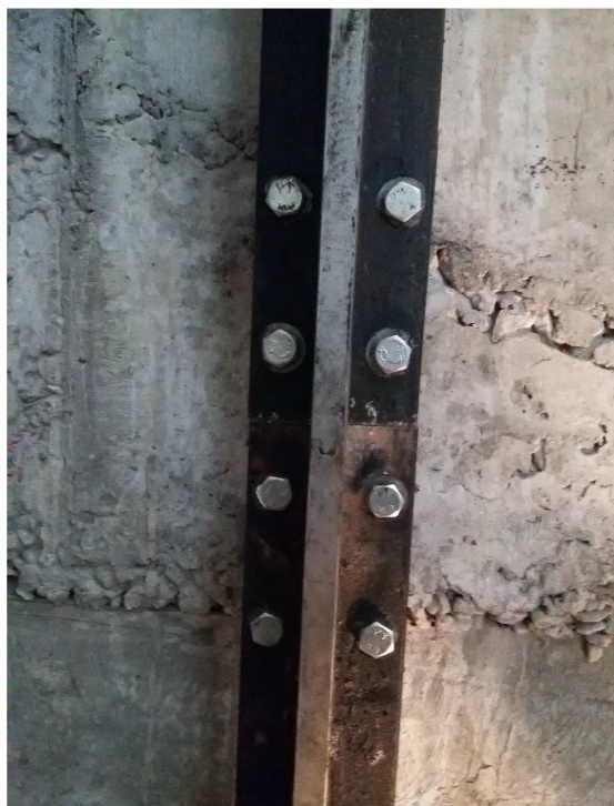
20-сурет – Кабина мен қарсы салмақтың бағыттағыштарын түйістіру
