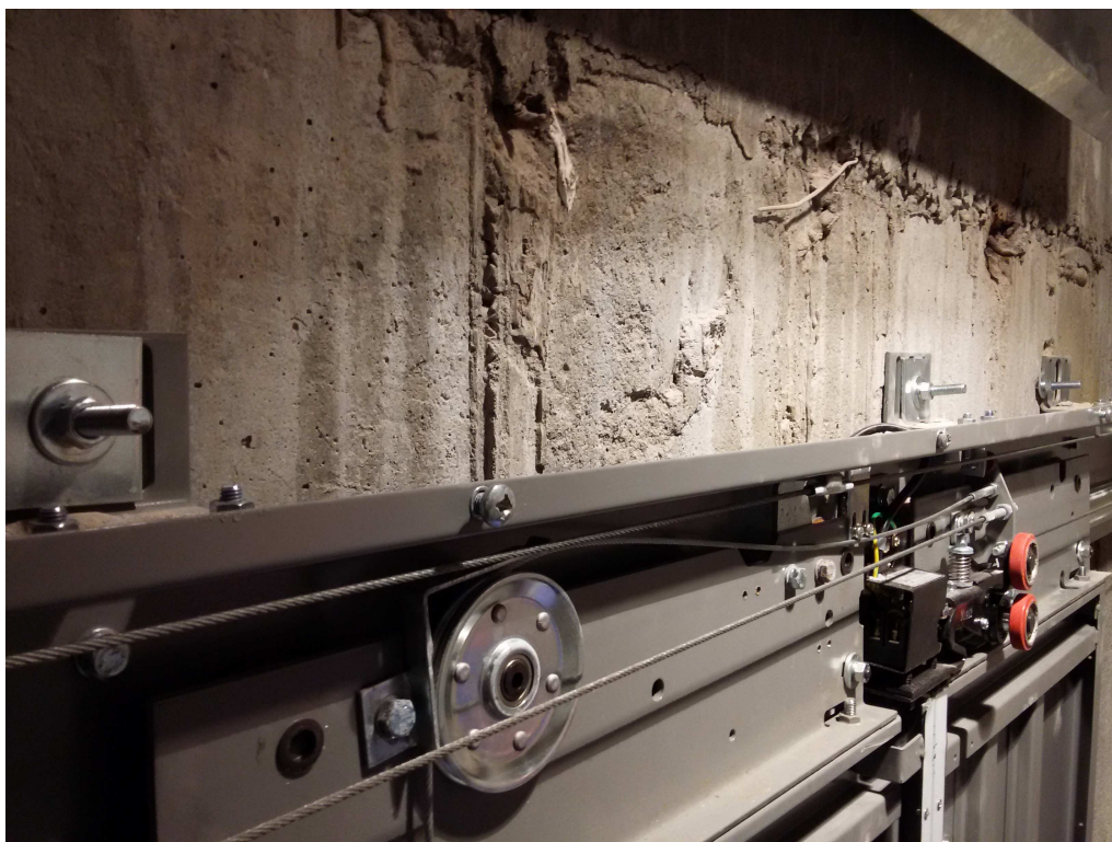
66-сурет – Шахта есіктерінің монтаждалған аспалы тетігі (бастиегі)
