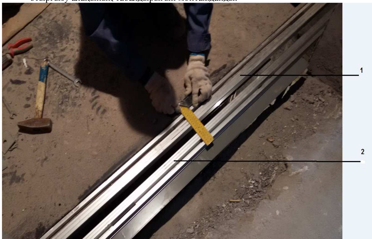
61-сурет – Кабинаның және қабат есіктерінің монтаждalған табалдырықтары
