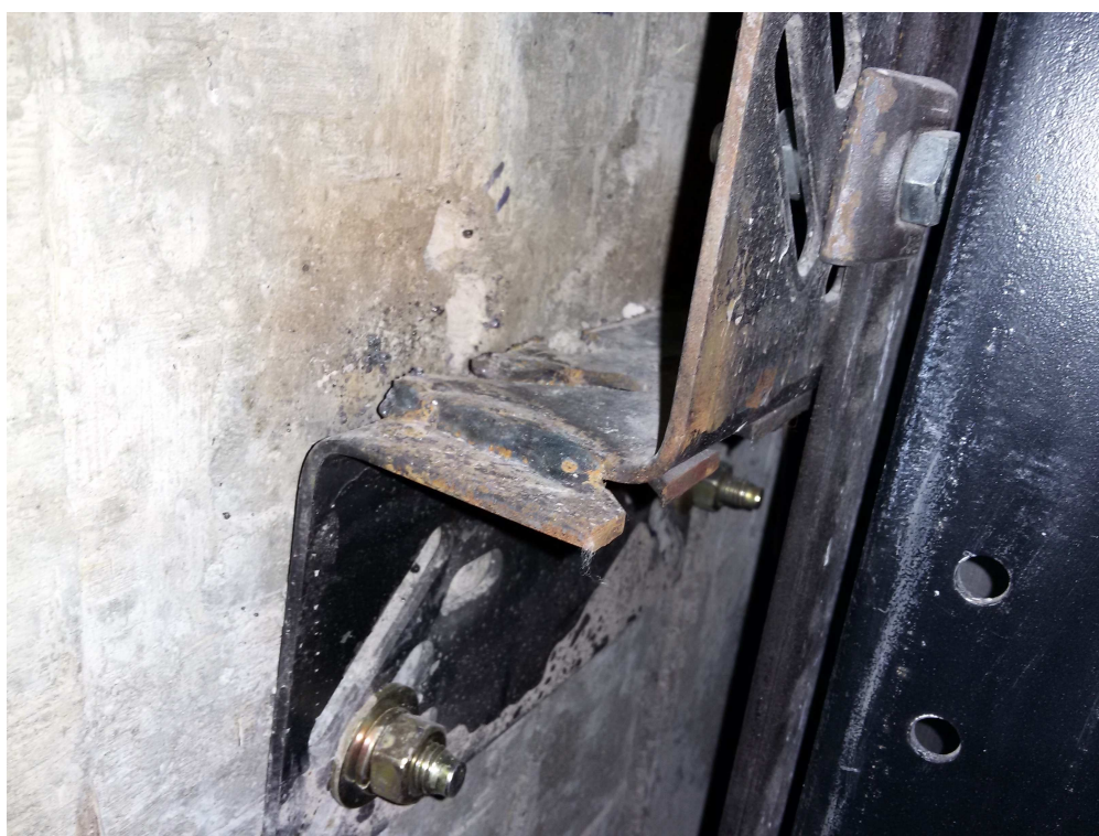
Рисунок 57 – Промежуточный кронштейн кабины
