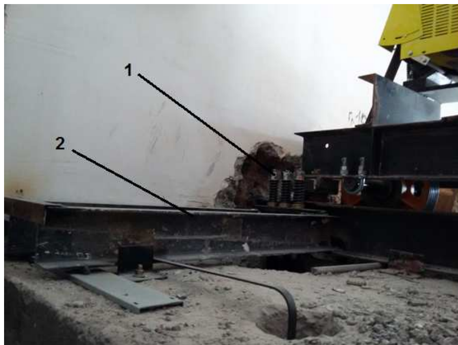
Рисунок 46 – Монтаж (запасовка) канатов
