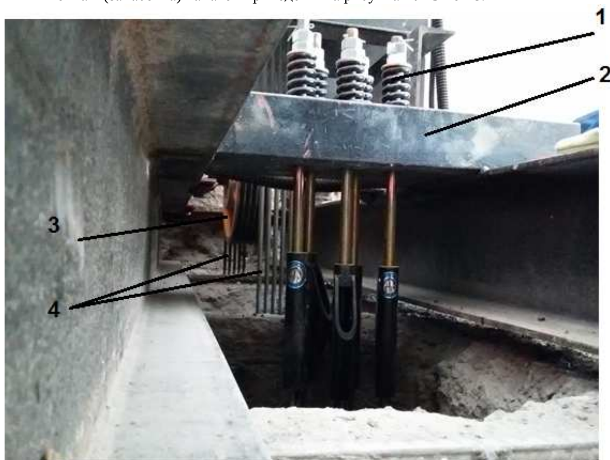
Рисунок 45 – Монтаж (запасовка) канатов
