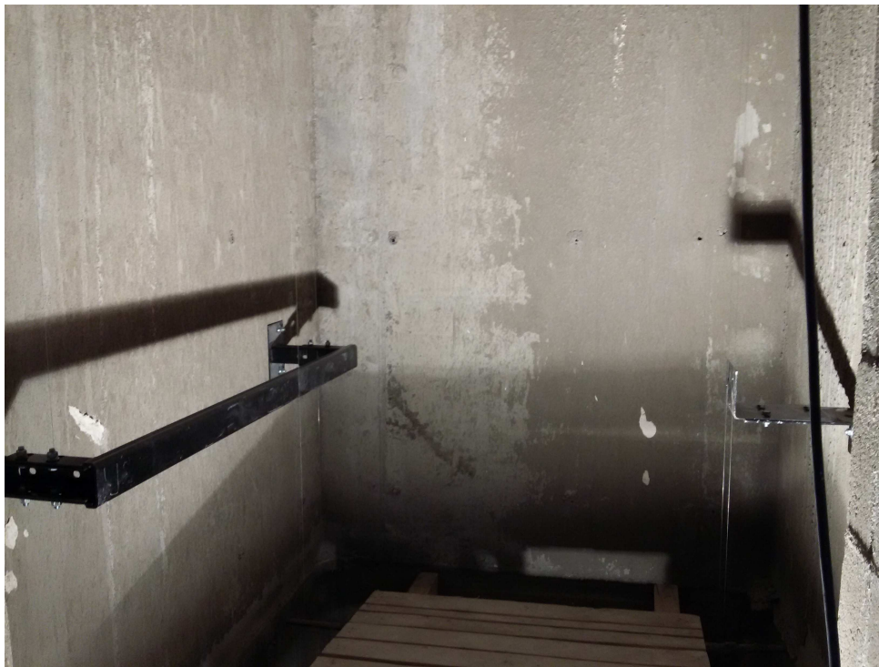
15-сурет – Қарсы салмақ бүйірде орналасқандағы кабина мен қарсы салмақ кронштейні
