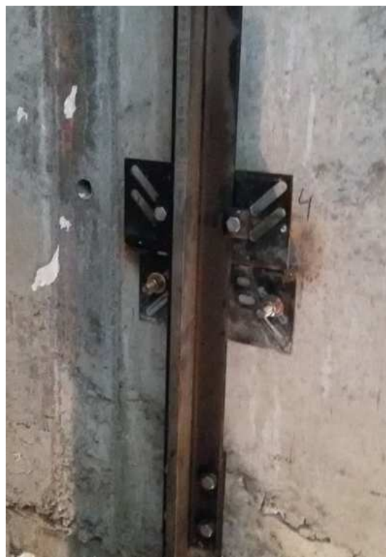
Рисунок 21 – Закрепленные к кронштейнам направляющие кабины и противовеса
