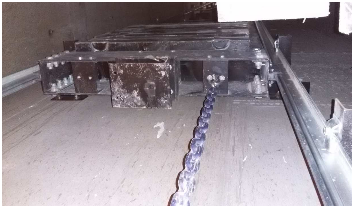
Рисунок 52 – Компенсирующая цепь на противовесе
