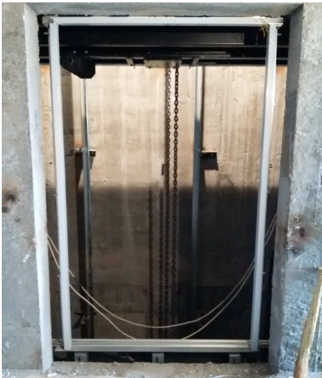
Рисунок 62 – Установленное обрамление этажных дверей
