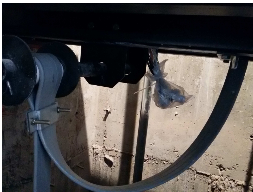
Рисунок 71 – Закрепление подвесного кабеля на каркас кабины снизу
