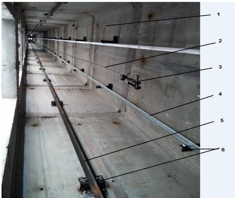
1 – лифт шахтасы, 2 – монтаждау шығырының тросы, 3 – ілгек, 4 – қарсы салмақ бағыттағышы, 5 – кабина бағыттағышы, 6 – бағыттағыш кронштейндері
