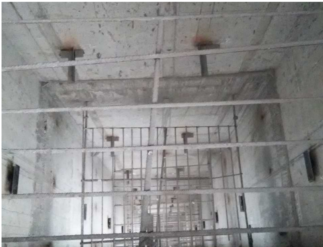
18-сурет – Қарсы салмақ артта орналасқандағы кабина мен қарсы салмақ кронштейндері
