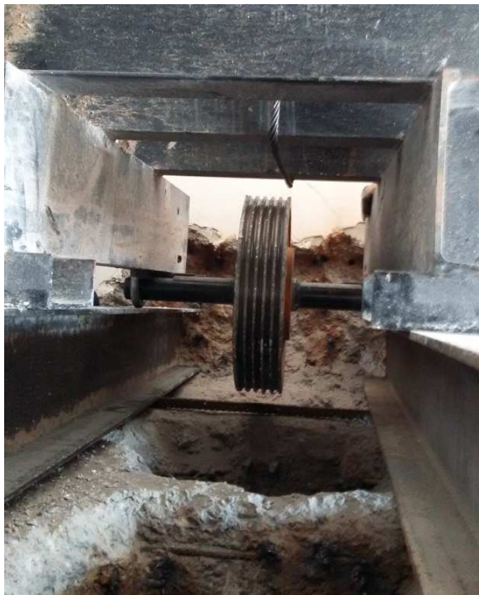
Рисунок 35 – Монтаж опорных балок, станины и отводного блока
