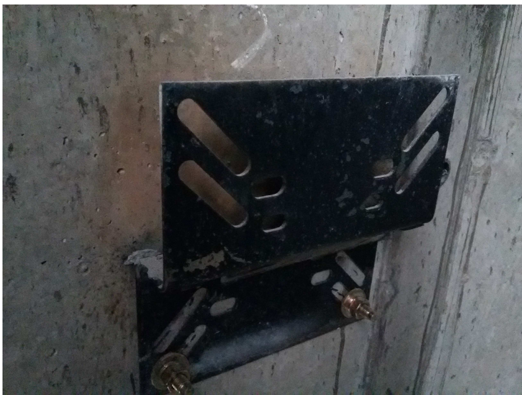
17-сурет – Қарсы салмақ артта орналасқандағы кабина кронштейні
