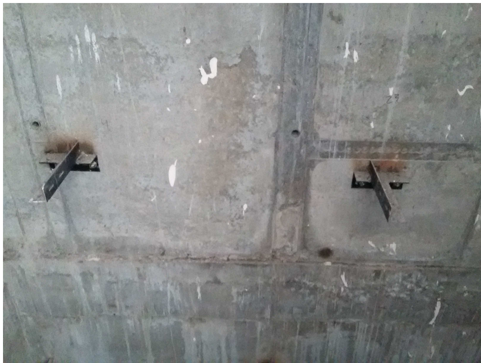
16-сурет – Қарсы салмақ артта орналасқандағы қарсы салмақ кронштейні
