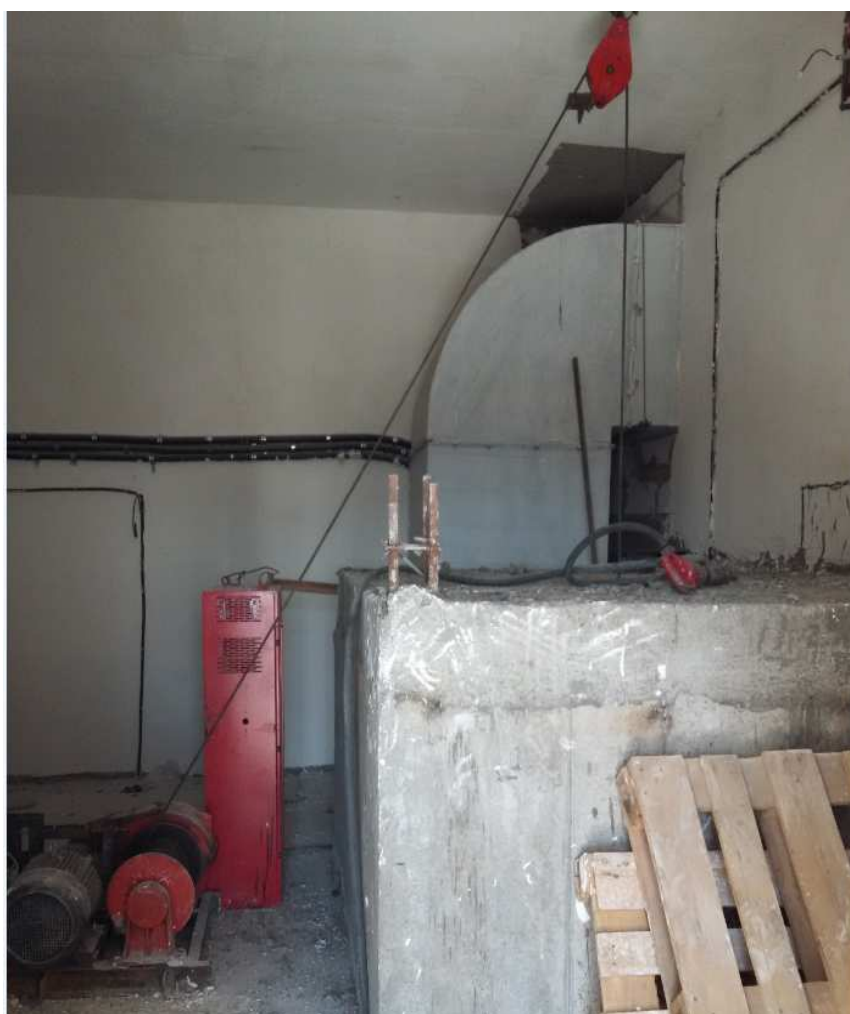
10-сурет – Машина үй-жайы болғандағы монтаждау шығыры
