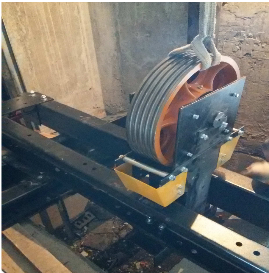
Рисунок 25 – Монтаж верхней балки каркаса и шкива кабины
