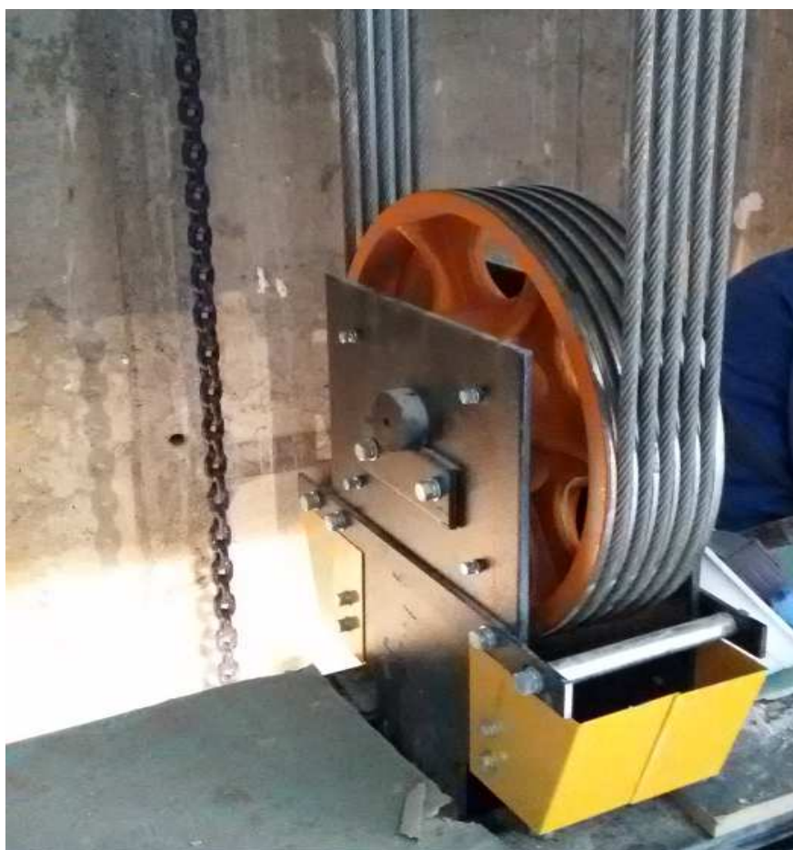
46-сурет – Арқандарды монтаждау (байлау)
