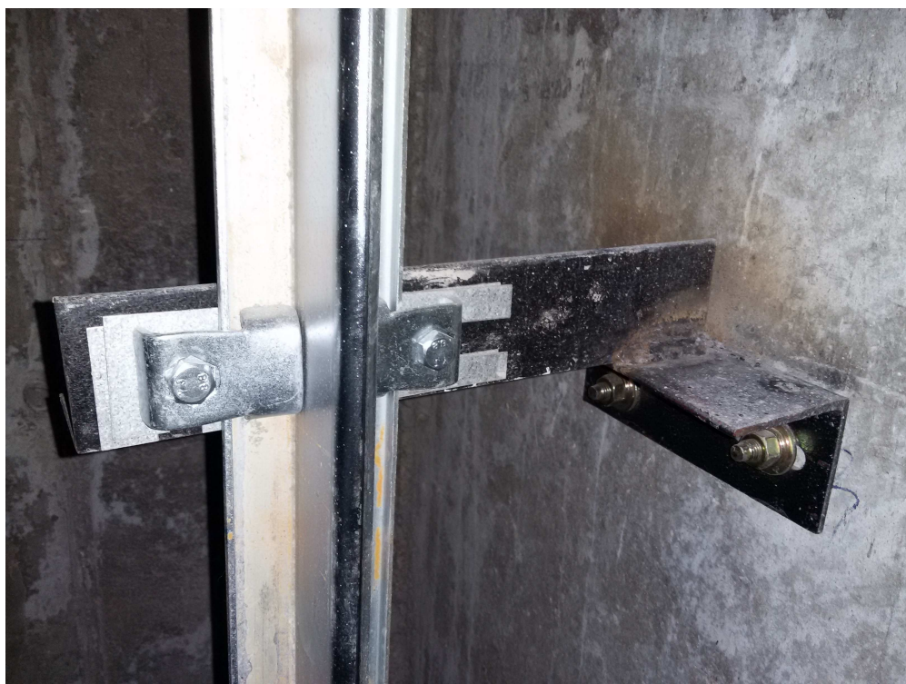
Рисунок 56 – Промежуточный кронштейн противовеса
