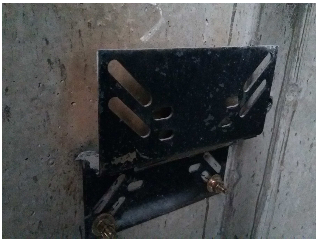
Рисунок 17 – Кронштейн кабины при заднем расположении противовеса
