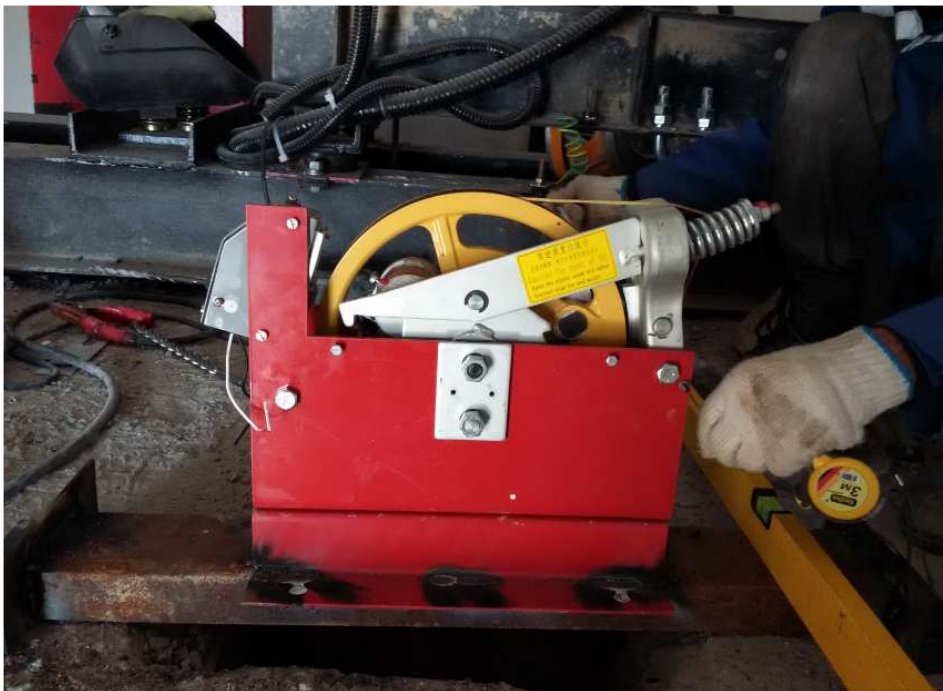
Рисунок 59 – Монтаж ограничителя скорости
