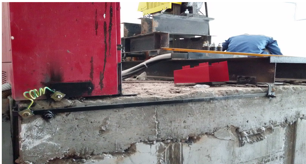
Рисунок 40 – Заземление оборудования лифта
