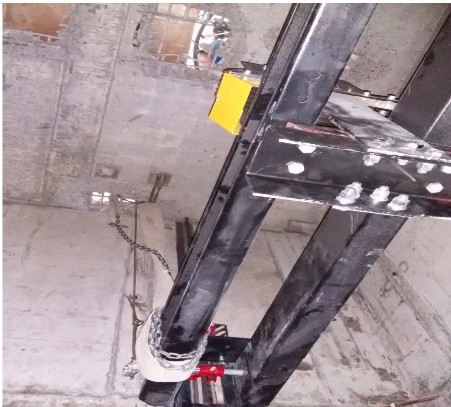
30-сурет – Кабина қаңқасын машина бөлімшесі төбесінің астына бекіту
