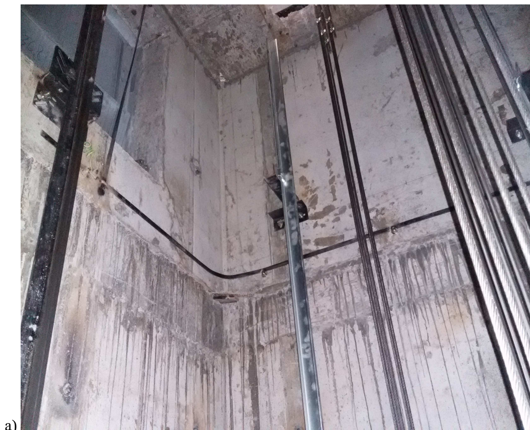
Рисунок 39 – Лифтовая лебедка после монтажа
