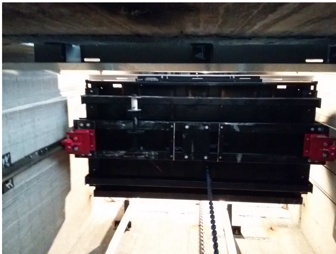
Рисунок 53 – Компенсирующая цепь на кабине
