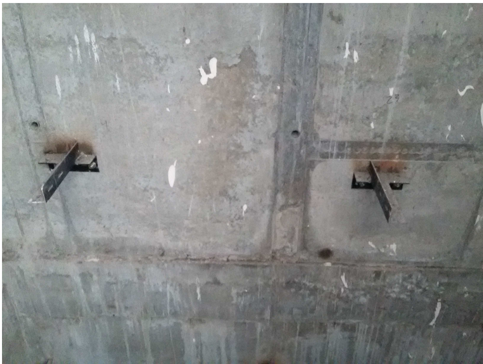
Рисунок 16 – Кронштейны противовеса при заднем расположении противовеса
