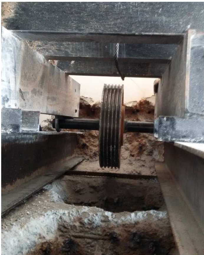
35-сурет – Тірек арқалықтарын, тұғырды және бұру блогын монтаждау
