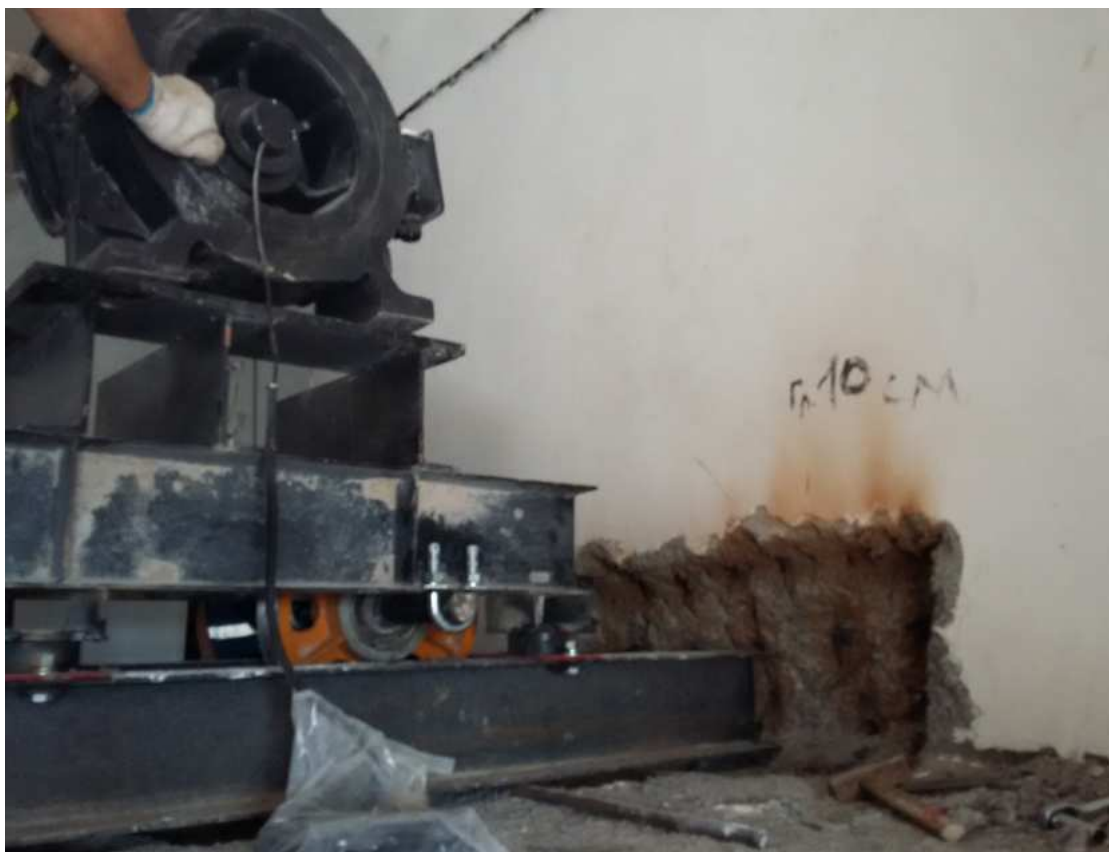
Рисунок 37 – Монтаж лифтовой лебедки
