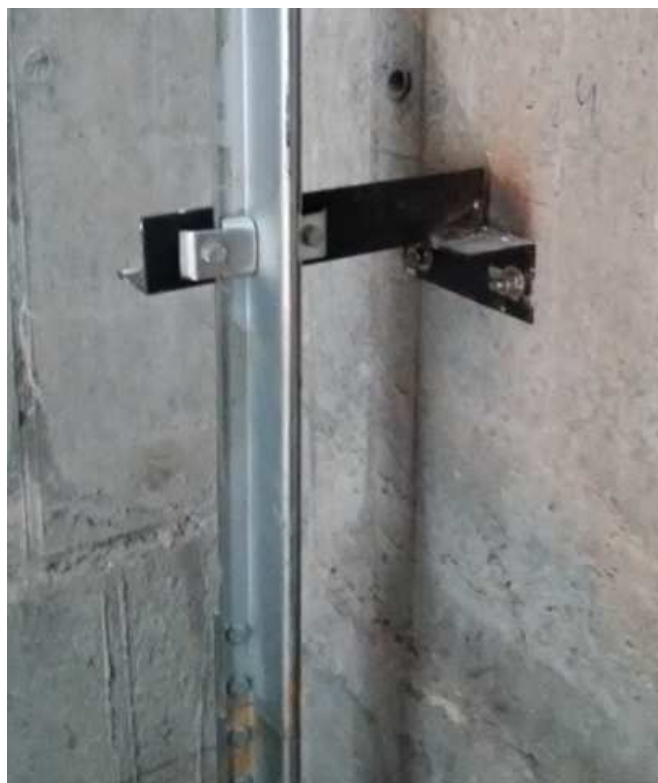
Рисунок 21 – Закрепленные к кронштейнам направляющие кабины и противовеса
