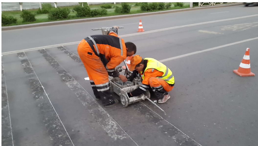
Рисунок 15 - Снятие лотка приемного контейнера с устройства дорожного разметочного «Профиль»
