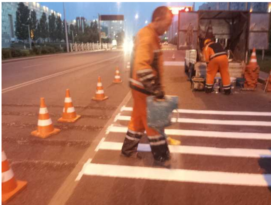
Рисунок 13 - Нанесение стекломикрошариков на шумовую дорожную разметку
