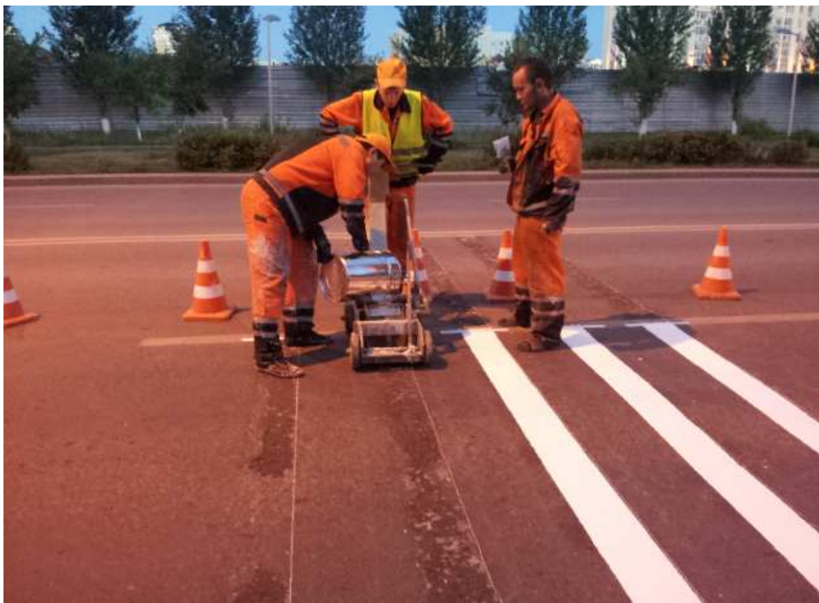
Рисунок 12 - Нанесение пластика холодного формирования для шумовой дорожной разметки
