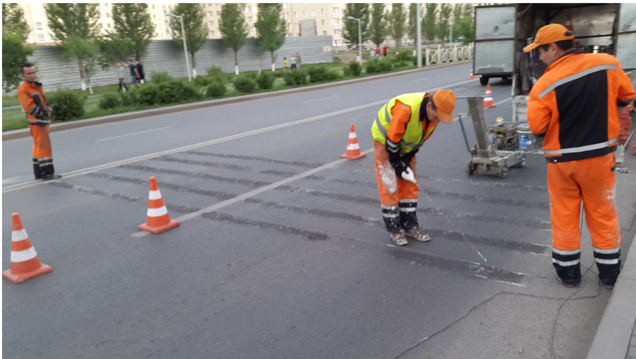
Рисунок 11 - Нанесение оси предварительной разметки
