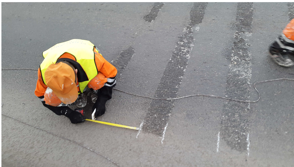
Рисунок 8 – Нанесение контрольных засечек мелом
