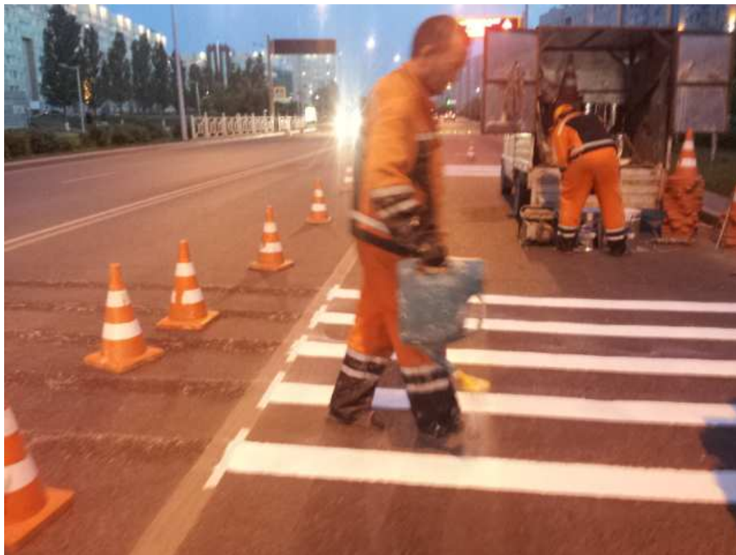
13-сурет - Шулы жол таңбасына шыны микрошариктер себу
