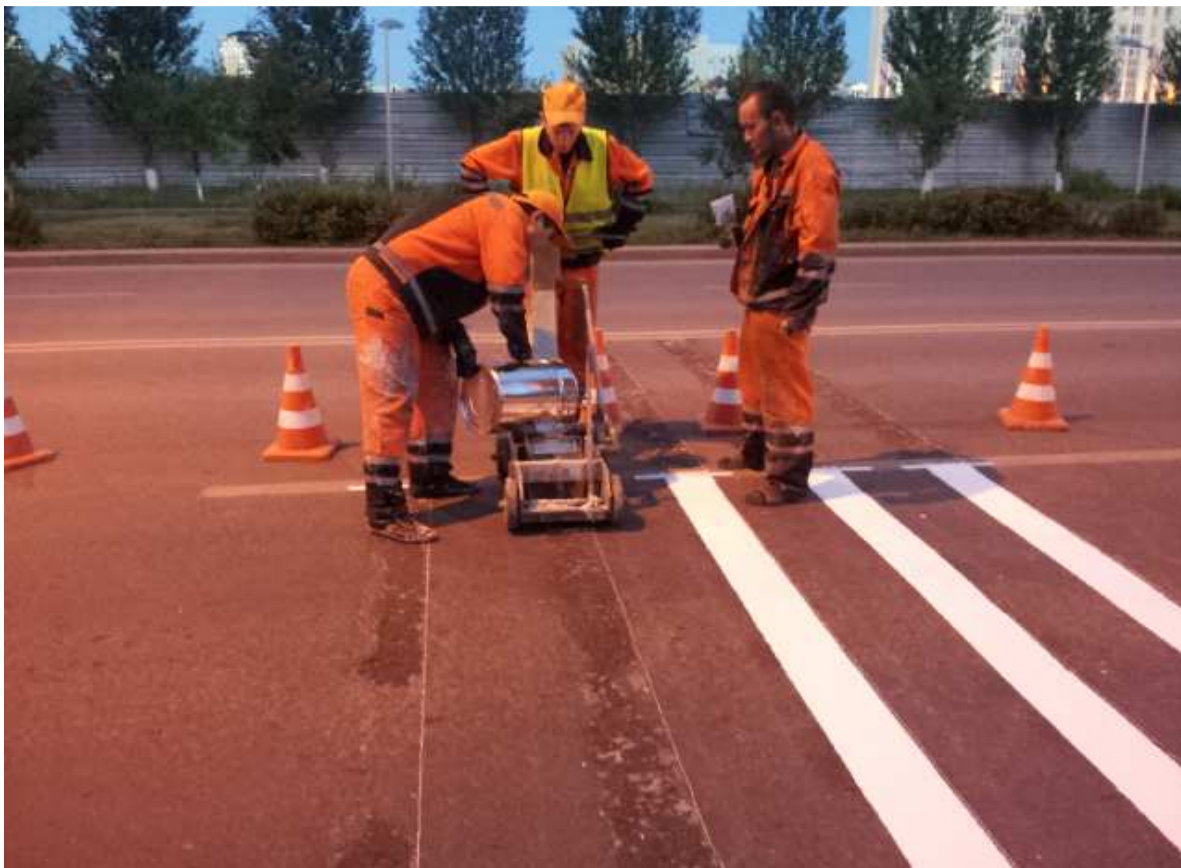
12-сурет – Шулы жол таңбасын салу үшін суықтай қалыптастырылған пластик жағу
