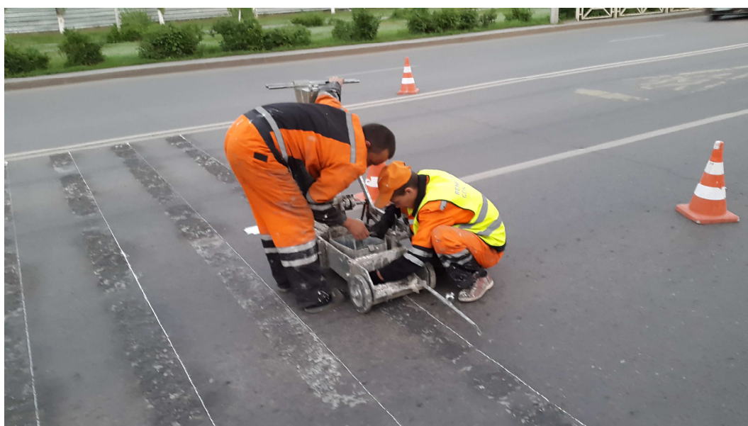
15-сурет - «Профиль» жол таңбалау құрылғысынан қабылдау контейнерінің наусын алу
