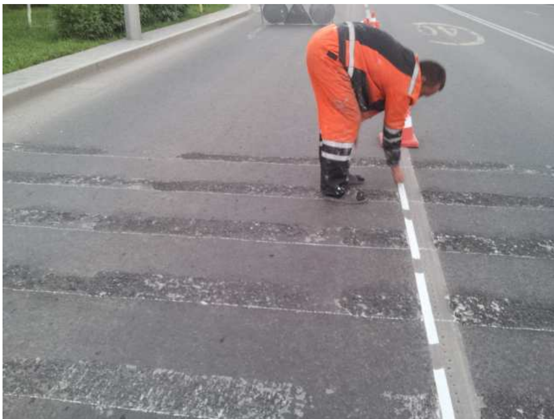
10-сурет – Шулы жол таңбасын салу шекараларын желімдеу
