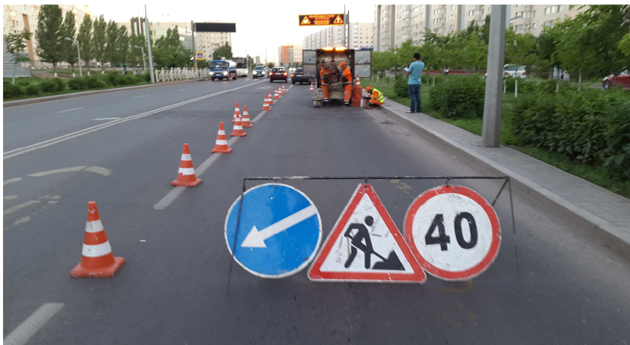
Рисунок 6 - Ограждение участка работ
