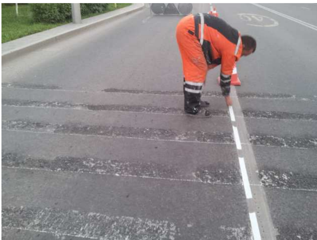
Рисунок 10 – Оклейка границ нанесения шумовой дорожной разметки
