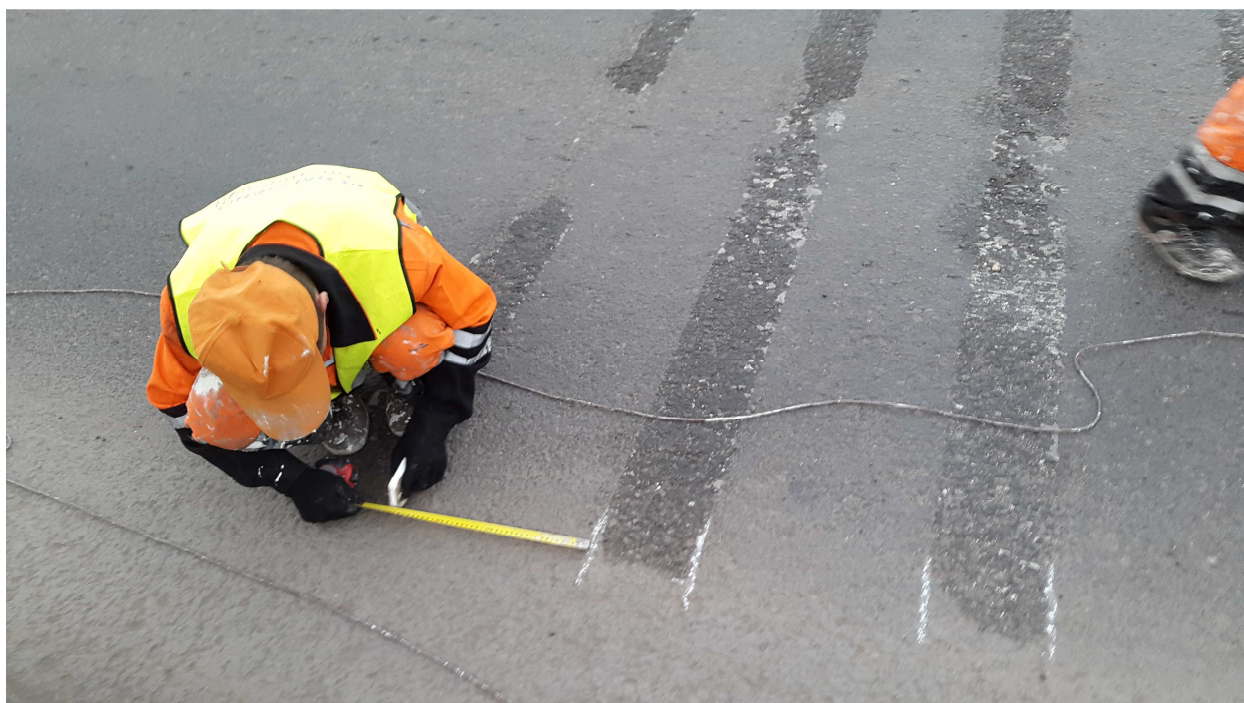
8-сурет – Бормен бақылау белгілерін салу
