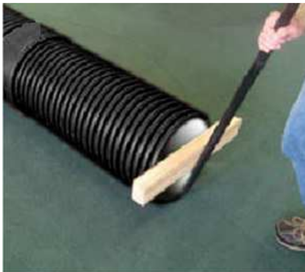
Рисунок 9 - Монтаж муфтового соединения с помощью специальных приспособлений
