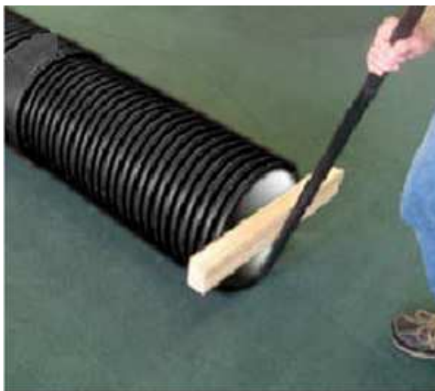
9-сурет – Арнайы бейімдегіштің көмегімен муфталық жалғастырғышты монтаждау
