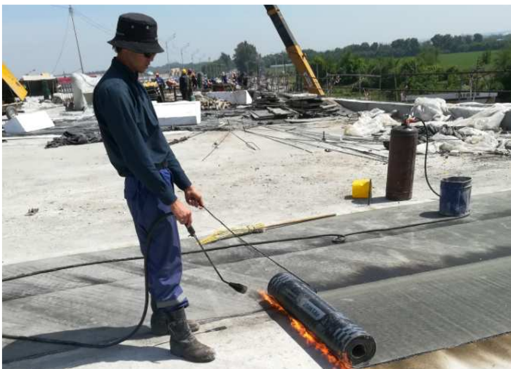
10 сурет-Битум-полимерлік материалдан жасалған балқытылатын гидрооқшаулағыш қабатты төсеу процесі
