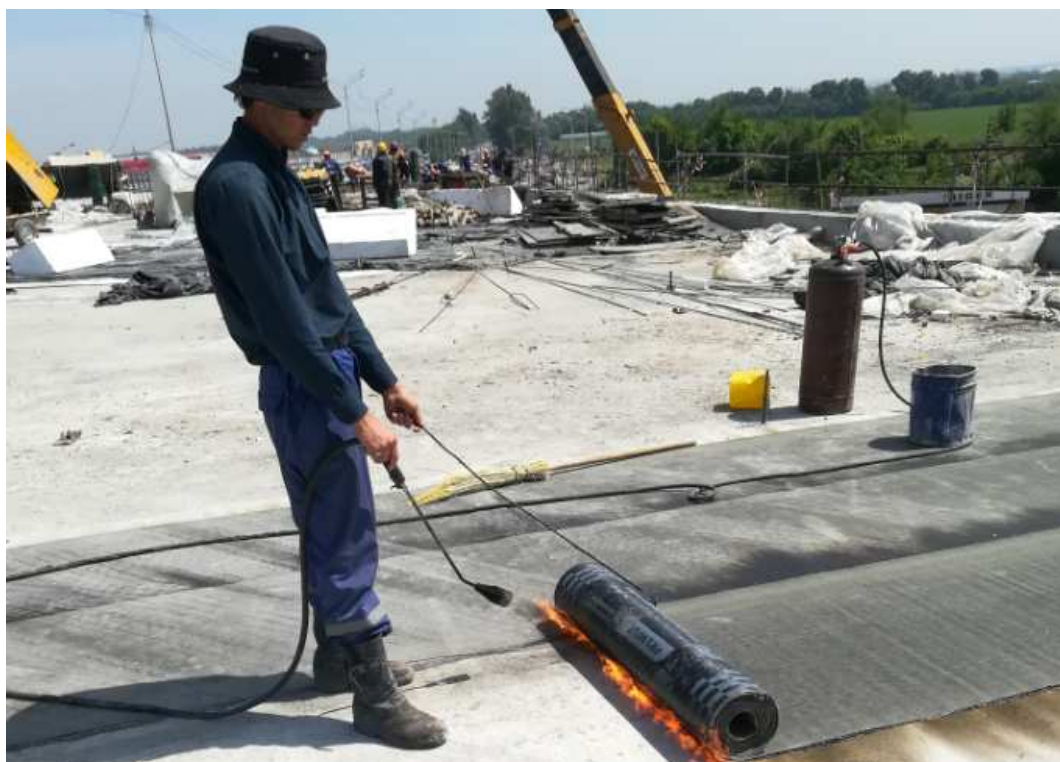
Рисунок 10 - Процесс укладки наплавляемого гидроизоляционного слоя из битумно-полимерного материала
