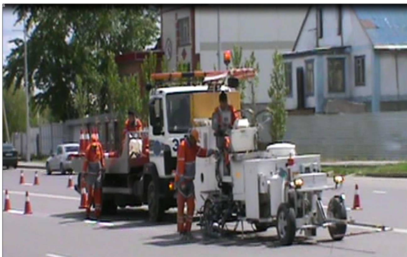
2-сурет – Автожолдың жабынына суық пластик пен микрошариктер жағу
