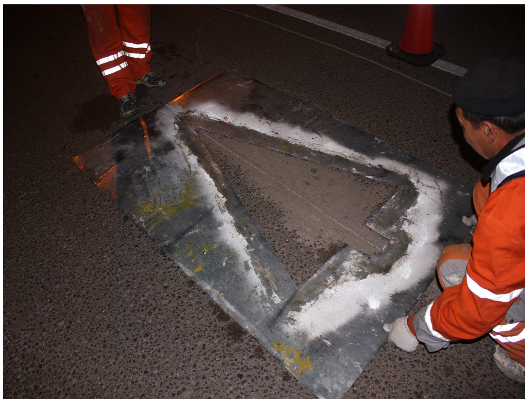
4а сурет - Трафарет қою немесе салынған таңбаның сызықтары мен символдарын желімді таспамен кескіндеу
