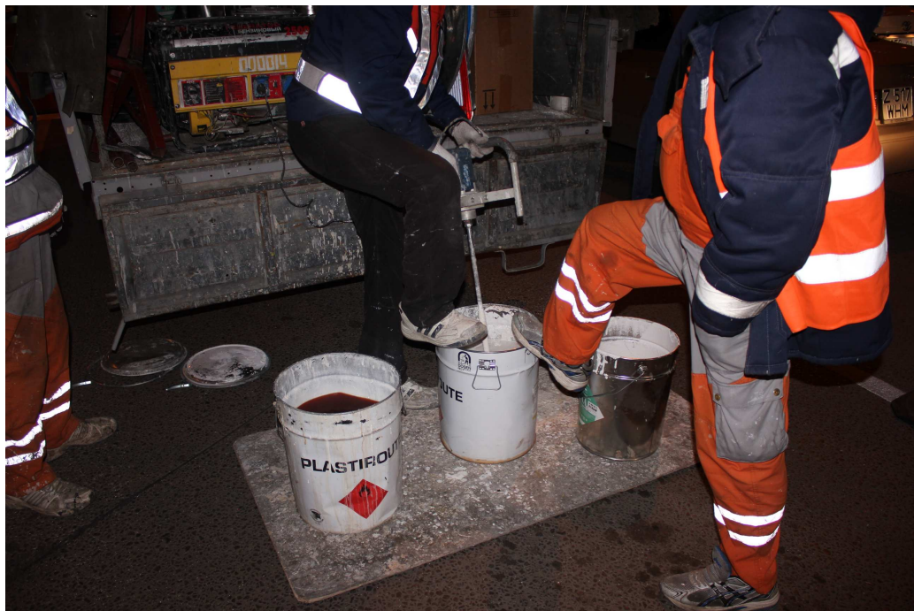
Рисунок 5 - смешивание компонентов материала
