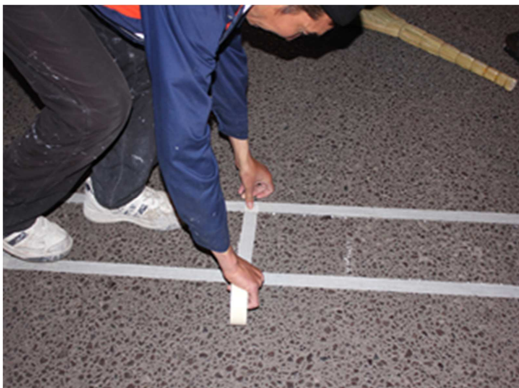
Рисунок 4в - Наложение трафарета или оконтуривание наносимых линий и символов разметки клейкой лентой
