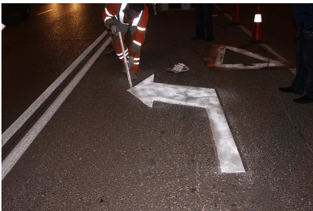
Рисунок 7 - Снятие трафарета, клейкой ленты
