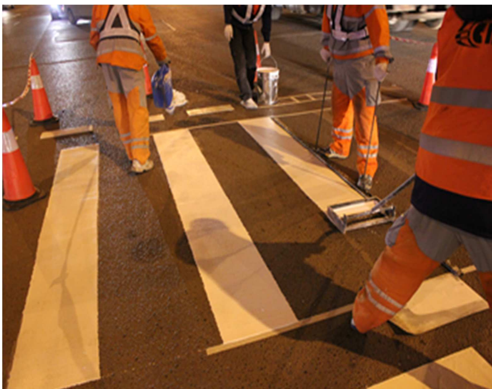
6-сурет - Трафареттің, желімді таспаның шегінде жол жабынының бетіне таңбалау материалын жағу
