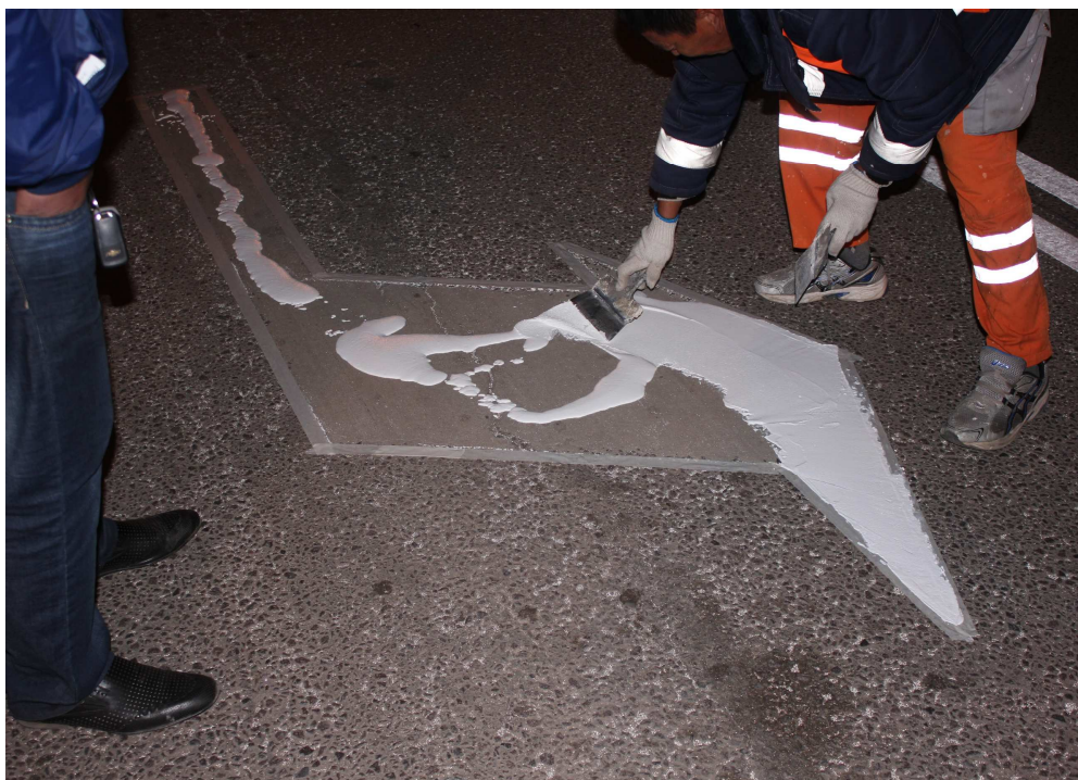
66 сурет - Трафареттің, желімді таспаның шегінде жол жабынының бетіне таңбалау материалын жағу
