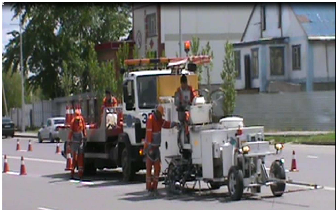
Рисунок 2 - Нанесение холодного пластика и микрошариков на покрытие автодороги
