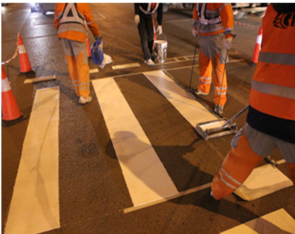
Рисунок 6а - Нанесение разметочного материала на поверхность дорожного покрытия в пределах трафарета, клейкой ленты
