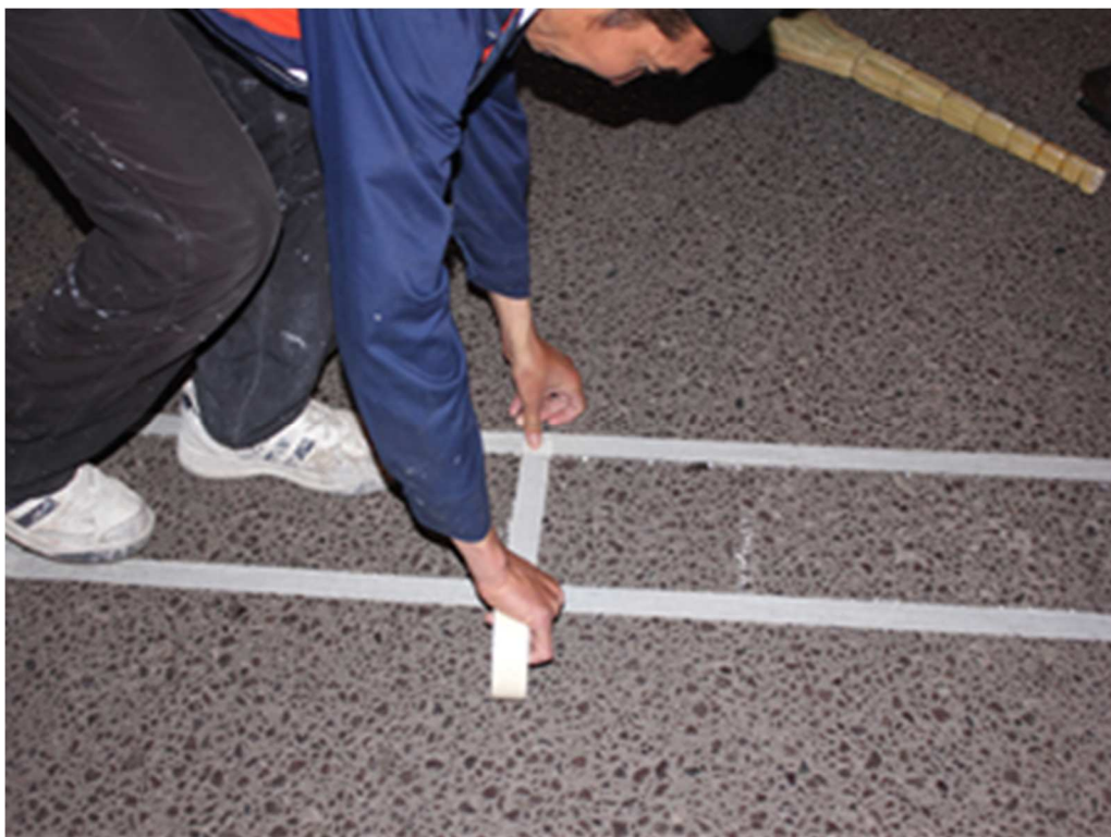
4в сурет - Трафарет қою немесе салынған таңбаның сызықтары мен символдарын желімді таспамен кескіндеу
