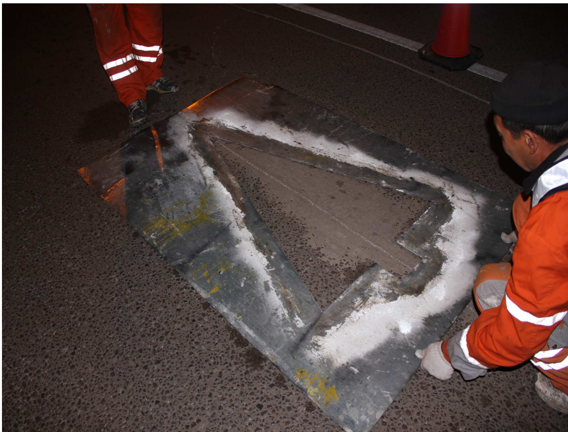
Рисунок 4а - Наложение трафарета или оконтуривание наносимых линий и символов разметки клейкой лентой
