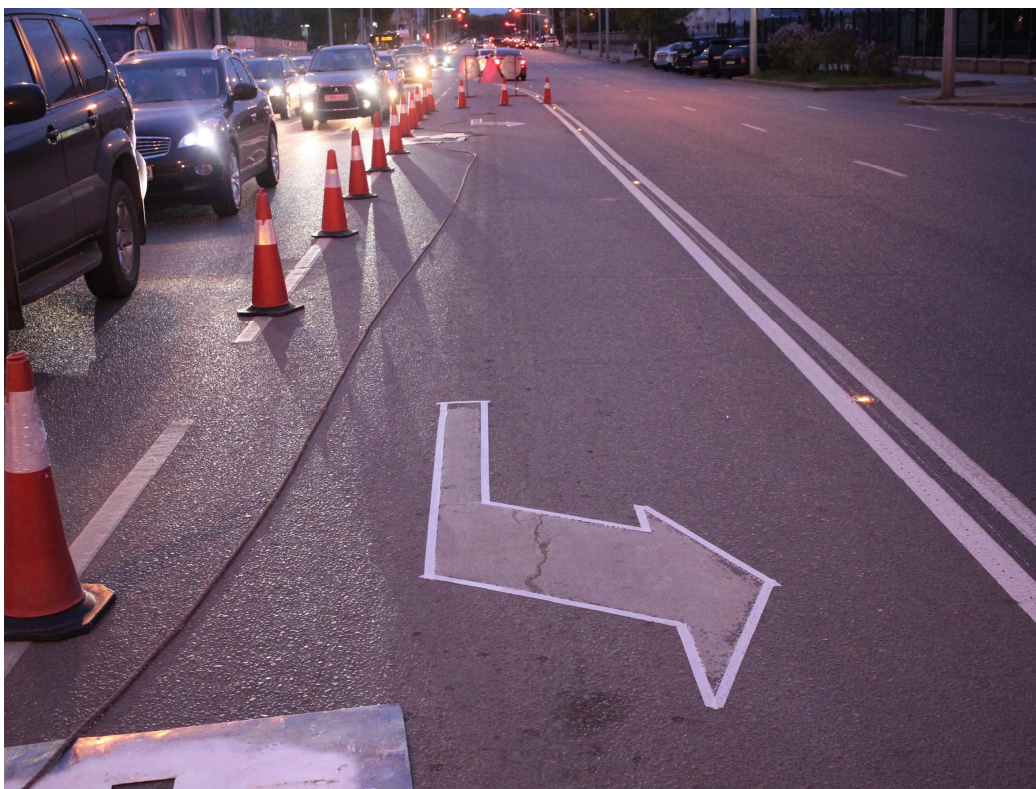
4б сурет - Трафарет қою немесе салынған таңбаның сызықтары мен символдарын желімді таспамен кескіндеу
