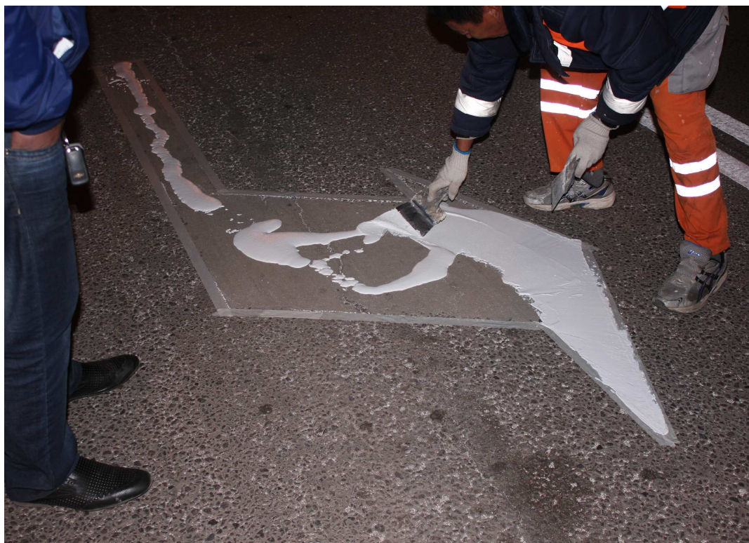
Рисунок 66 - Нанесение разметочного материала на поверхность дорожного покрытия в пределах трафарета, клейкой ленты
