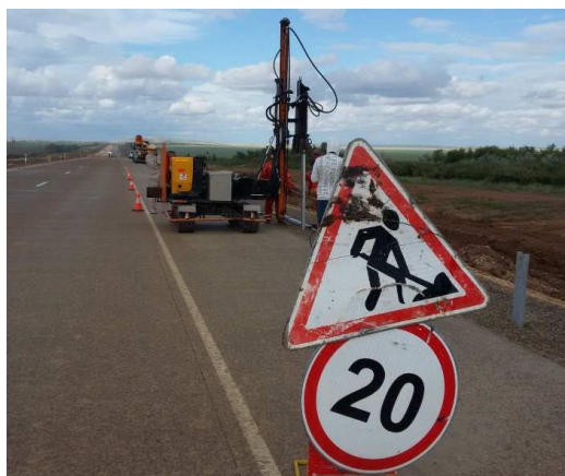
Рисунок 17 - Установка стоек ограждения на обочине дороги
