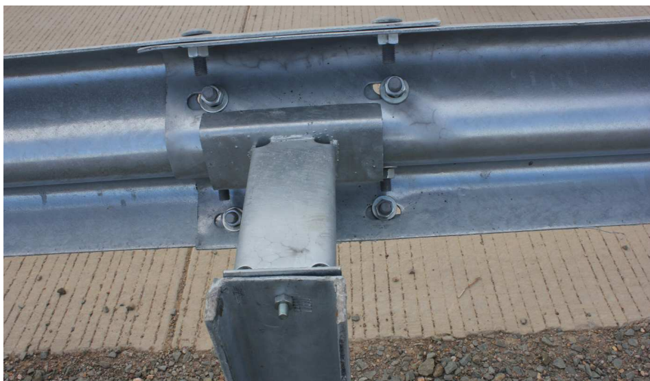
21-сурет – Қатты консолі бар жол тобының бір жақты қоршауының торабы.
