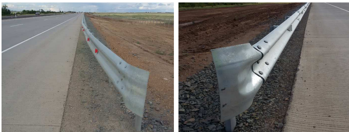
Рисунок 2 – Начальный и конечный участки одностороннего дорожного ограждения
