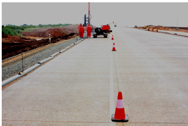
17-сурет - Жолдың жиегінде қоршау тіреулерін орнату
