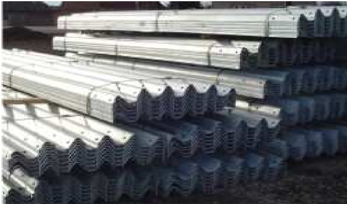
Рисунок 14 – Складирование балок барьерного ограждения
