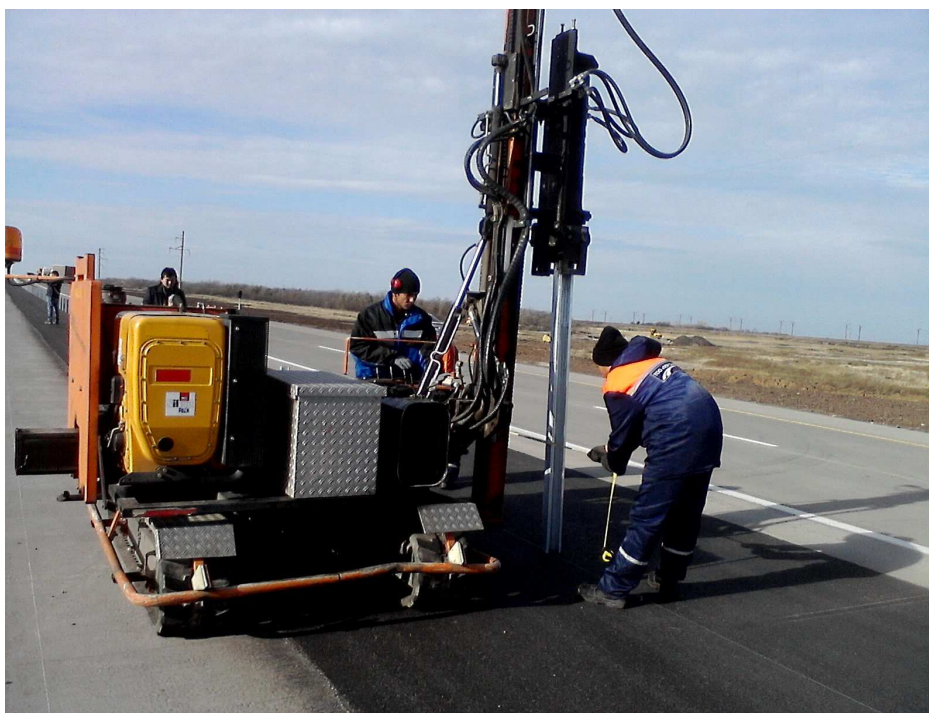
Рисунок 19 - Установка стоек под ограждения на разделительной полосе
