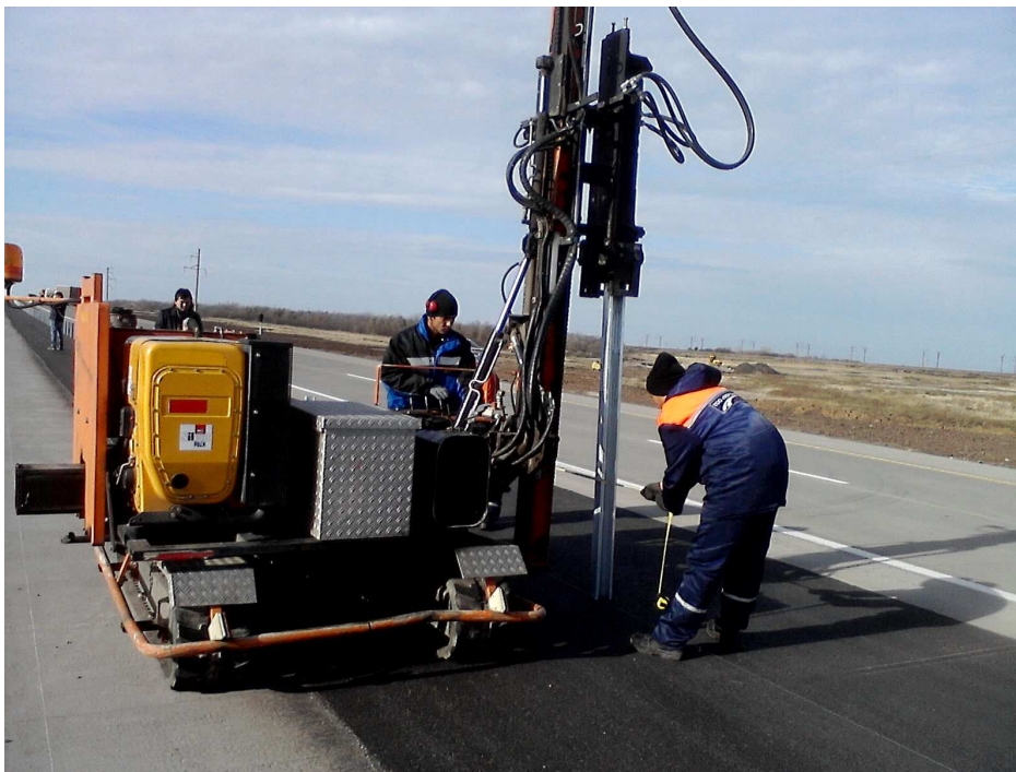
19-сурет - Бөлу жолағында қоршаулардың астындағы тіреулерді орнату
