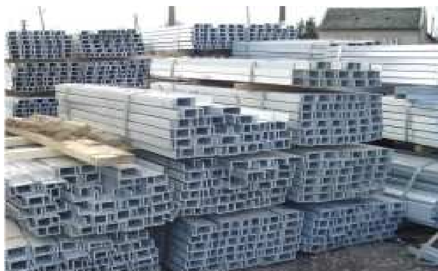
Рисунок 12 – Складирование стоек барьерного ограждения
