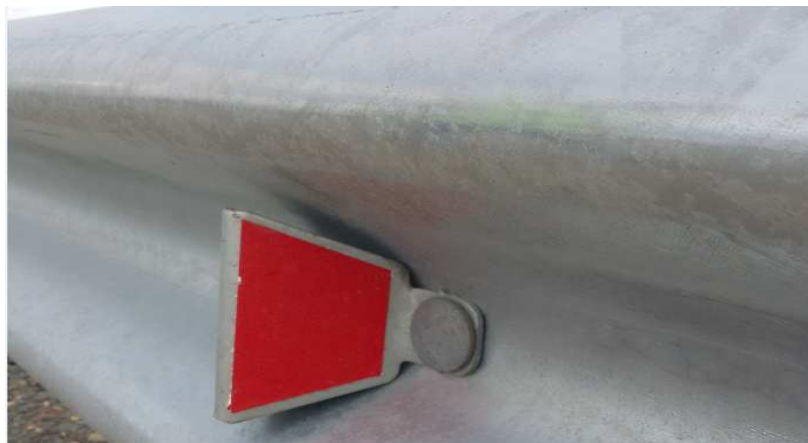
Рисунок 26 – Световозвращатель барьерного ограждения
