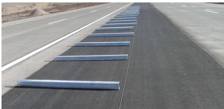
16-сурет - Бөлу жолағында қоршау тіреулерін тарқатып жаю
