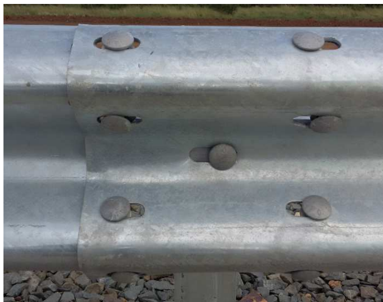
Рисунок 25 – Стык балок барьерного ограждения одностороннего исполнения
