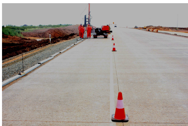
Рисунок 17 - Установка стоек ограждения на обочине дороги
