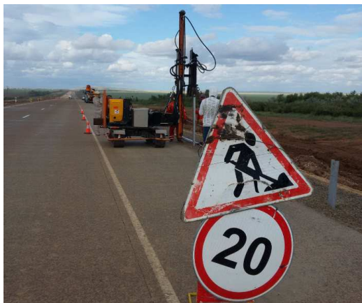
17-сурет - Жолдың жиегінде қоршау тіреулерін орнату
