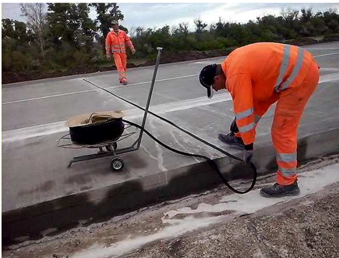
Рисунок 20 – Производство работ по закладке уплотнительного профиля в шов
