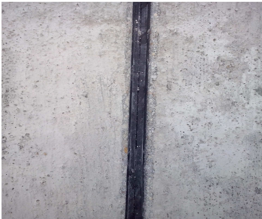
Рисунок 23 – Заложенный в продольный шов уплотнительный профиль
