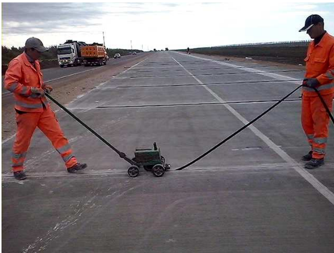
Рисунок 21 – Производство работ по закладке уплотнительного профиля в шов
