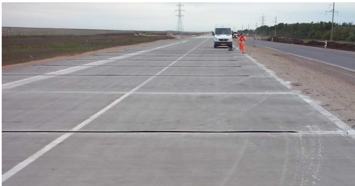
Рисунок 19 – Производство работ по закладке уплотнительного профиля в поперечный шов
