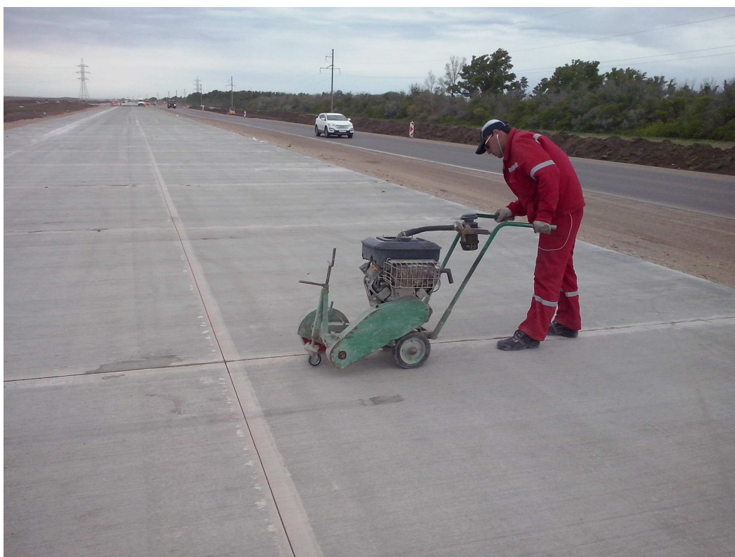
Рисунок 12 – Производство работ по снятию фасок кромок шва
