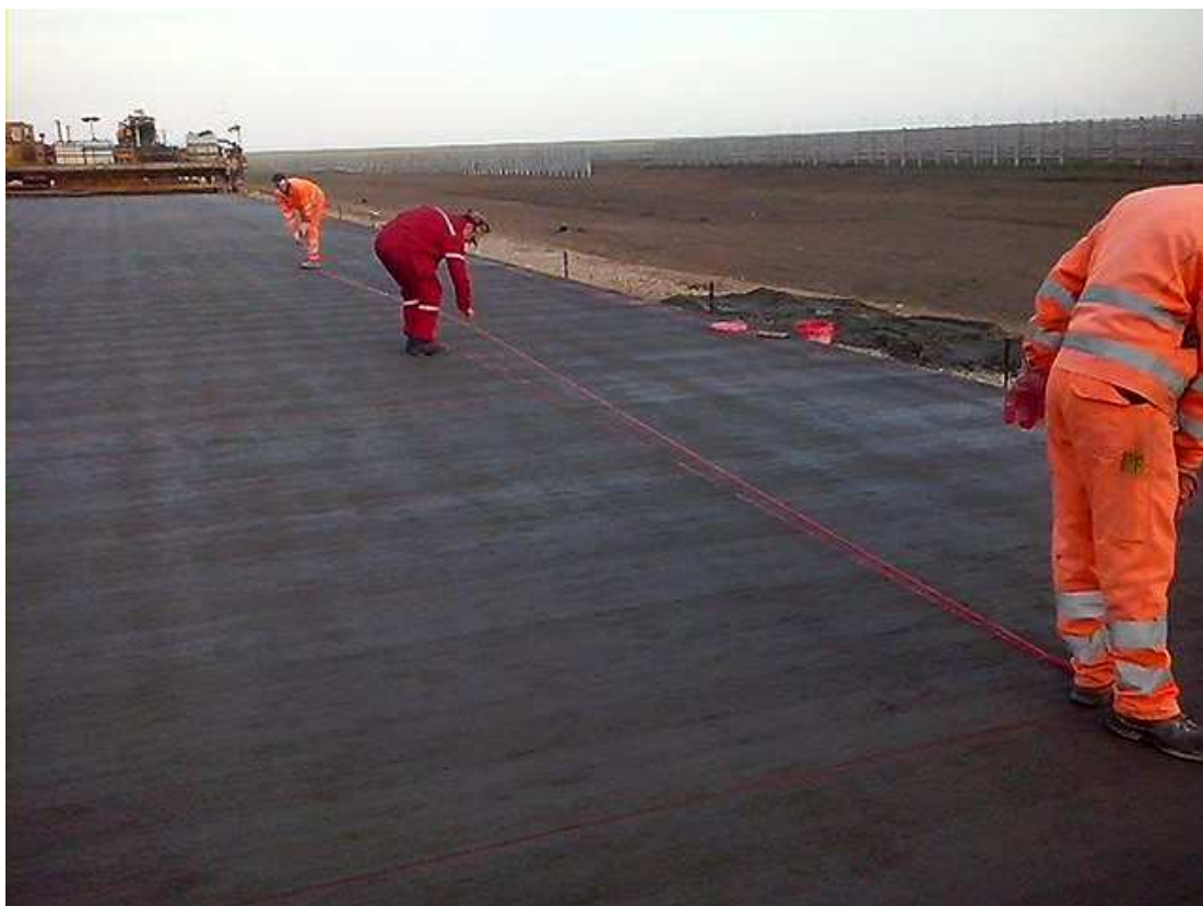
Рисунок 3 – Нанесение разметки на продольный шов
