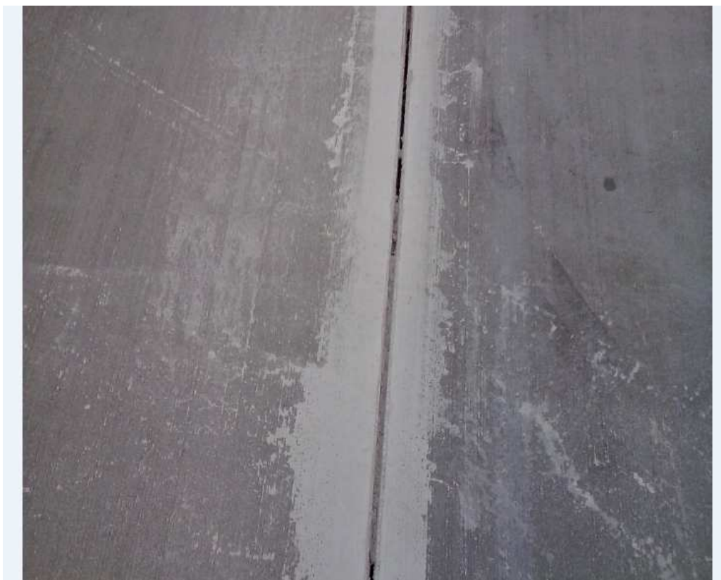
Рисунок 14 – Продольный расширенный шов до прочистки
