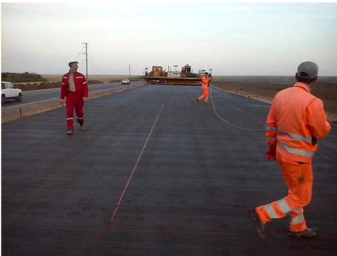
Рисунок 4 – Нанесенная разметка на продольный шов
