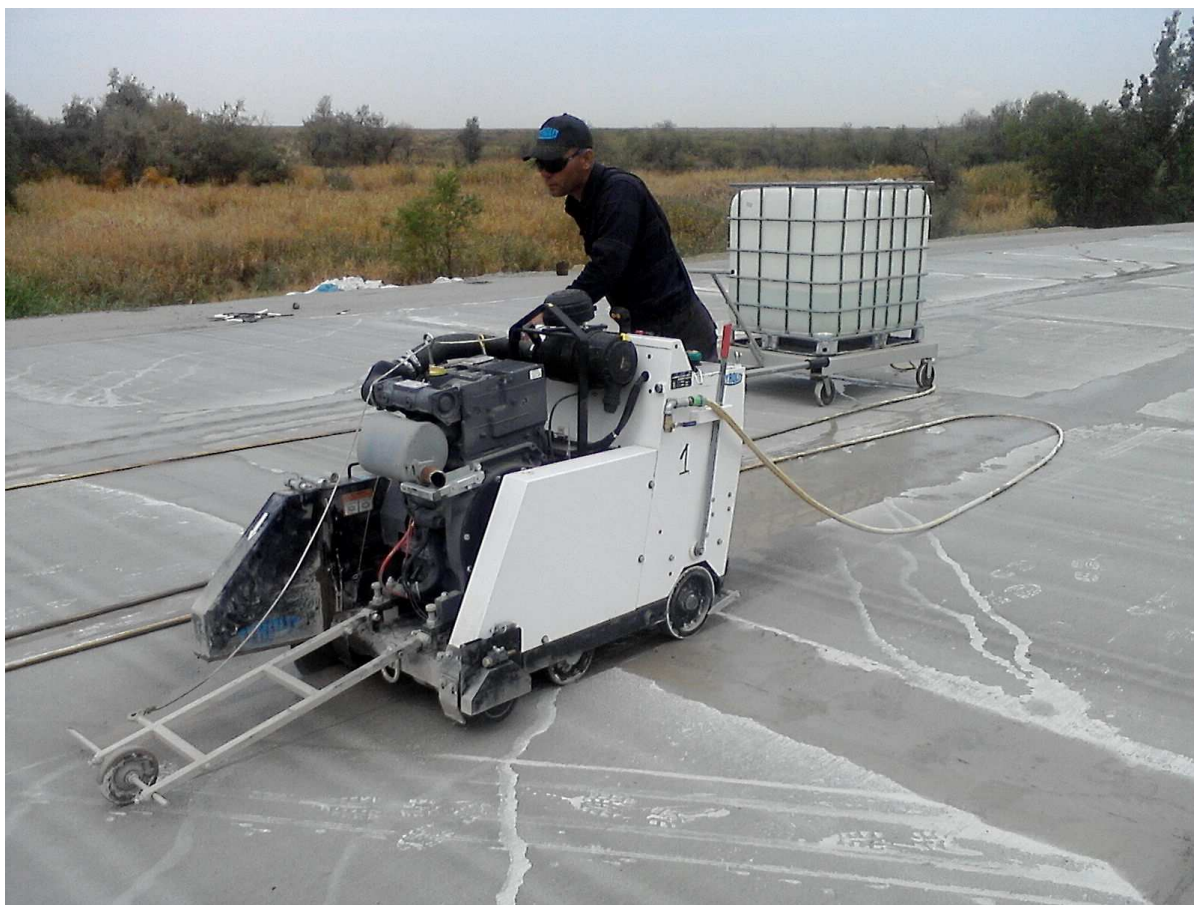
Рисунок 7 – Устройство продольного пионерного шва нарезчиком шва
