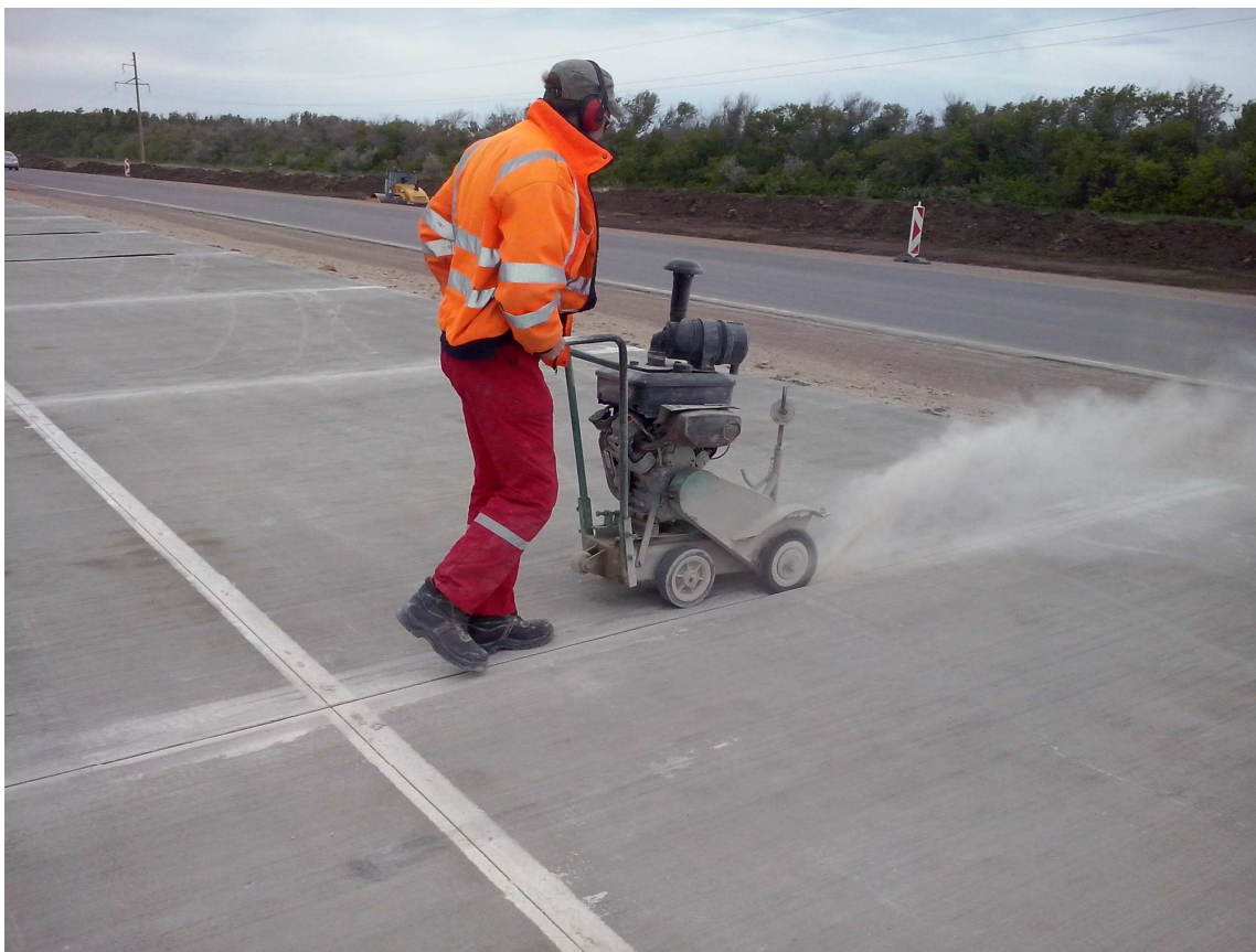
Рисунок 13 – Производство работ по прочистке швов щеточной машиной
