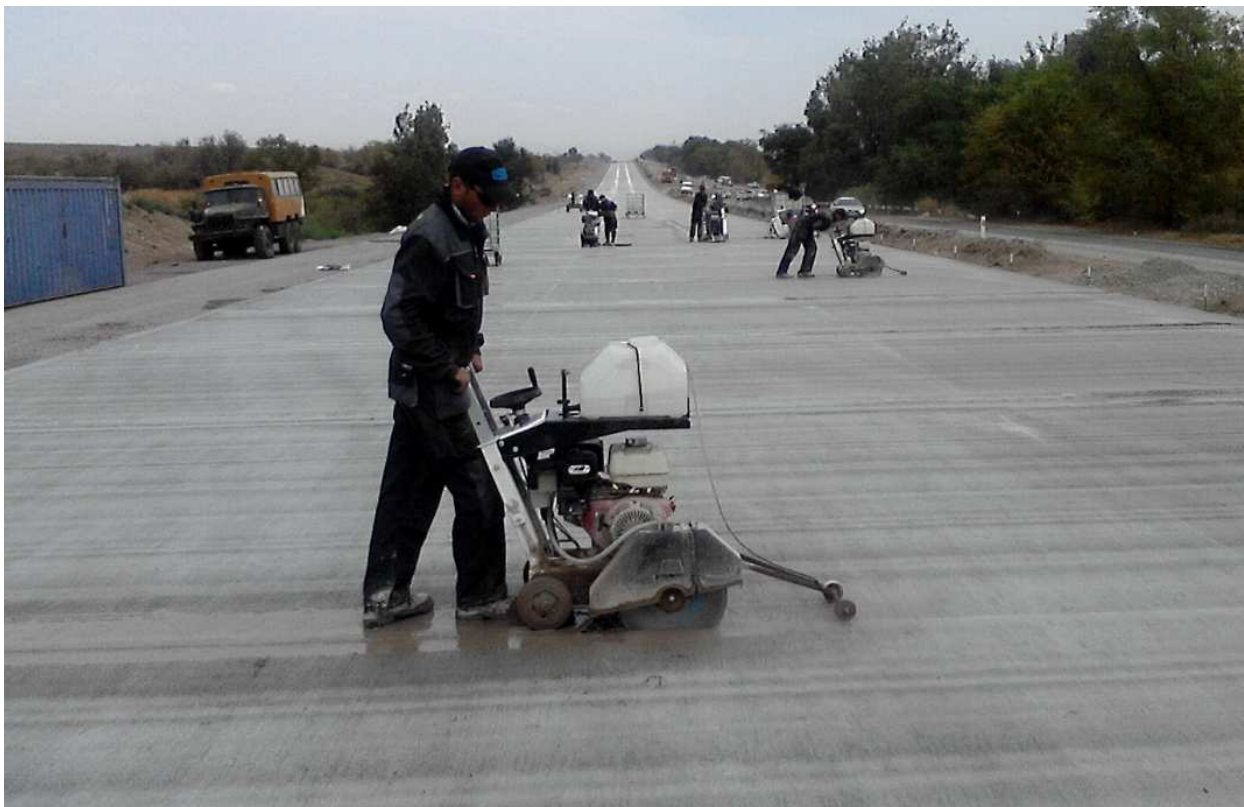
Рисунок 16 – Общий вид производства работ по нарезке продольных и поперечных швов
