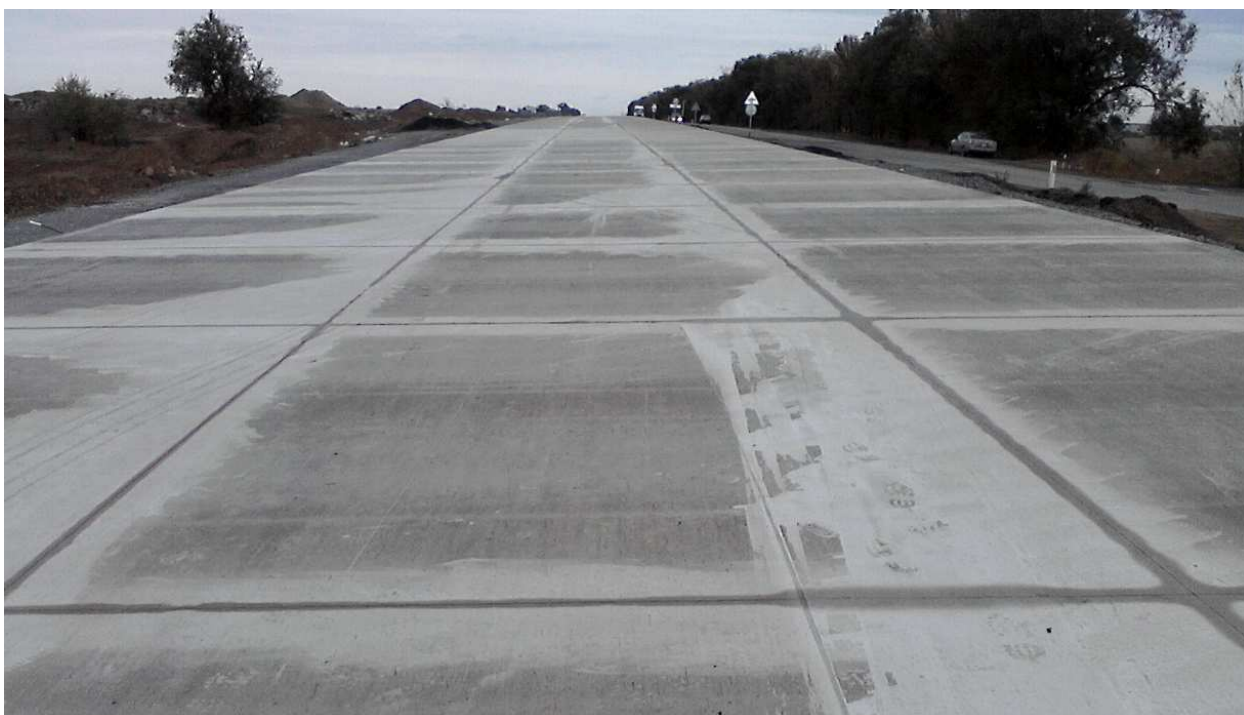
Рисунок 17 – Общий вид продольных и поперечных швов
