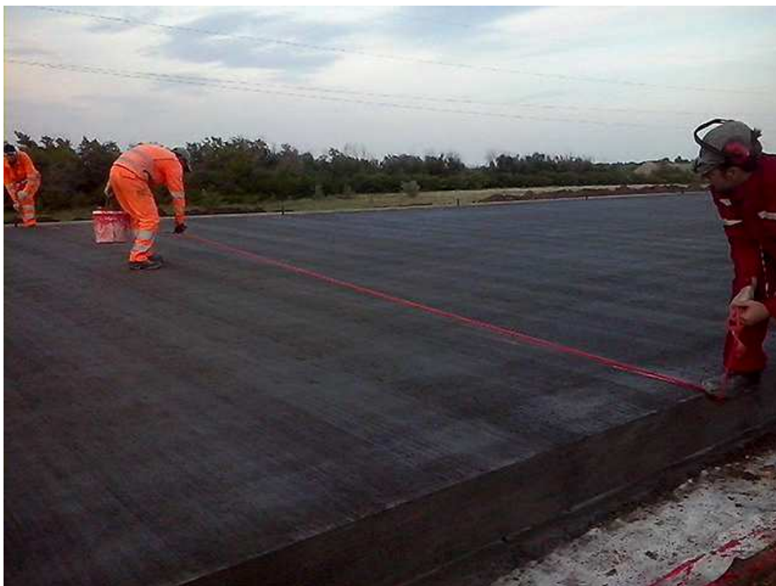
Рисунок 2 – Нанесение разметки на поперечный шов
