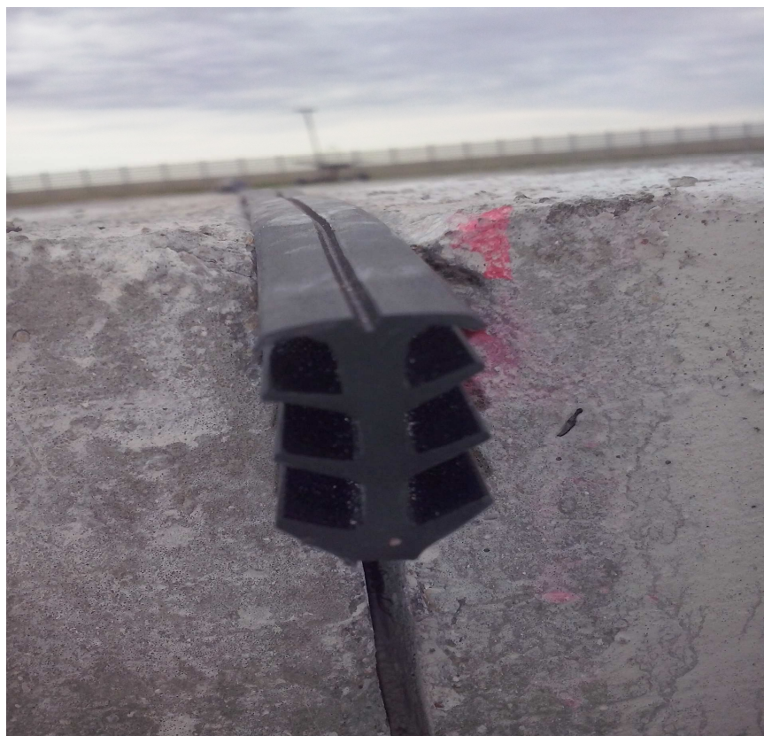
Рисунок 22 – Заложенный в поперечный шов уплотнительный профиль
