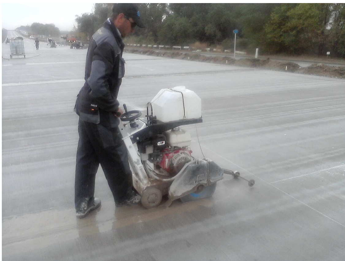
Рисунок 6 – Устройство нарезчиком поперечного пионерного шва
