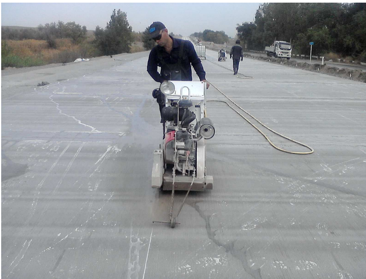
Рисунок 8 – Устройство продольного пионерного шва нарезчиком шва
