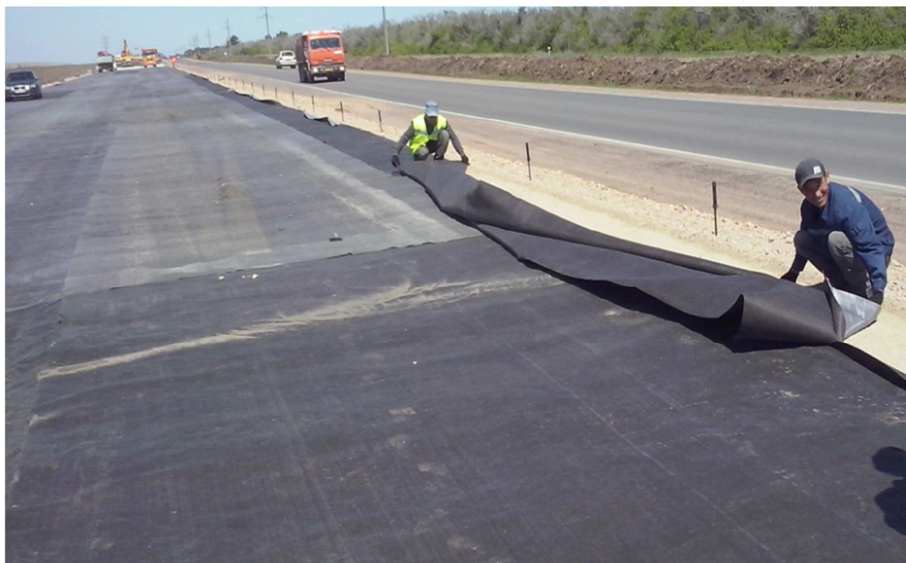
Рисунок 10 - Раскатка рулонов геокомпозита на дорожное полотно
