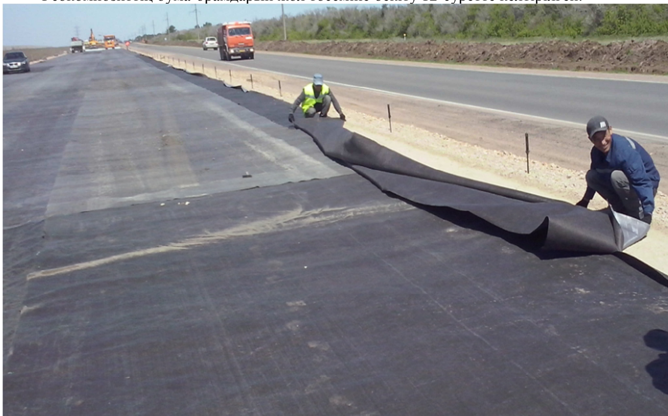
10-сурет - Геокомпозиттің бума-орамдарын жол төсеміне жаю
