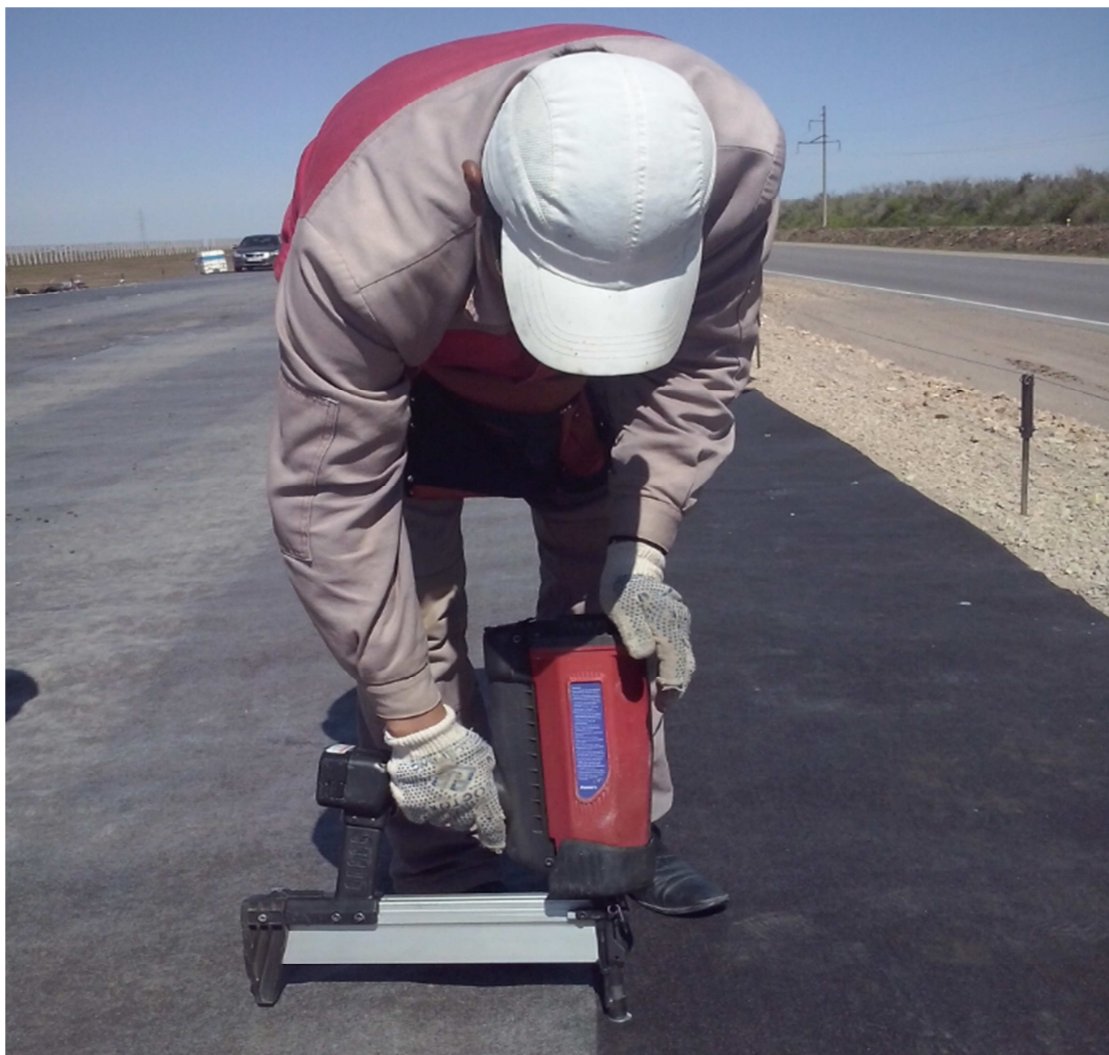
Рисунок 6 – Крепление полотен геокompозита к основанию из ЩПС газowym монтажным пистолетом.
