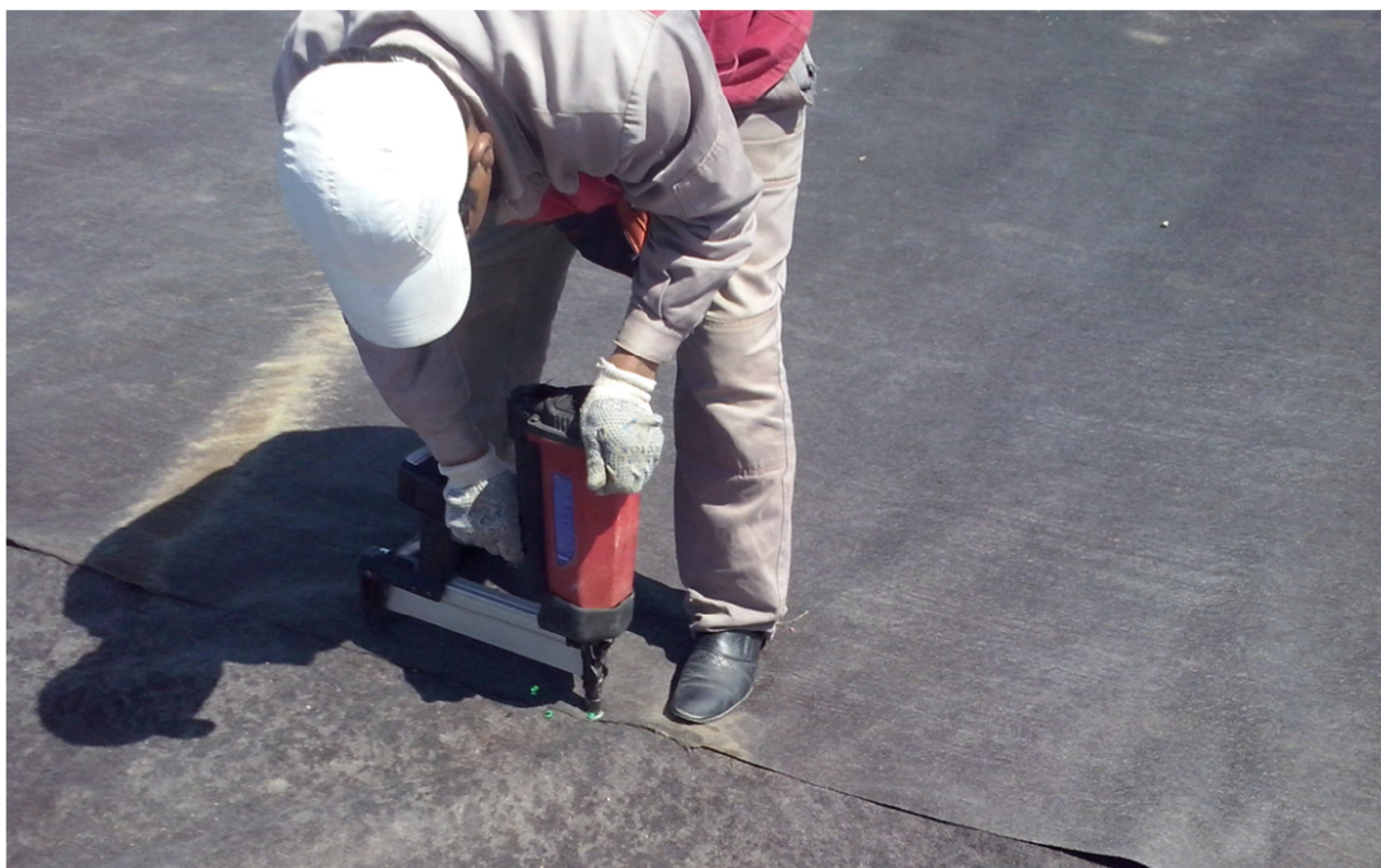
Рисунок 12 - Закрепление рулонов геокompозита на дорожное полотно
