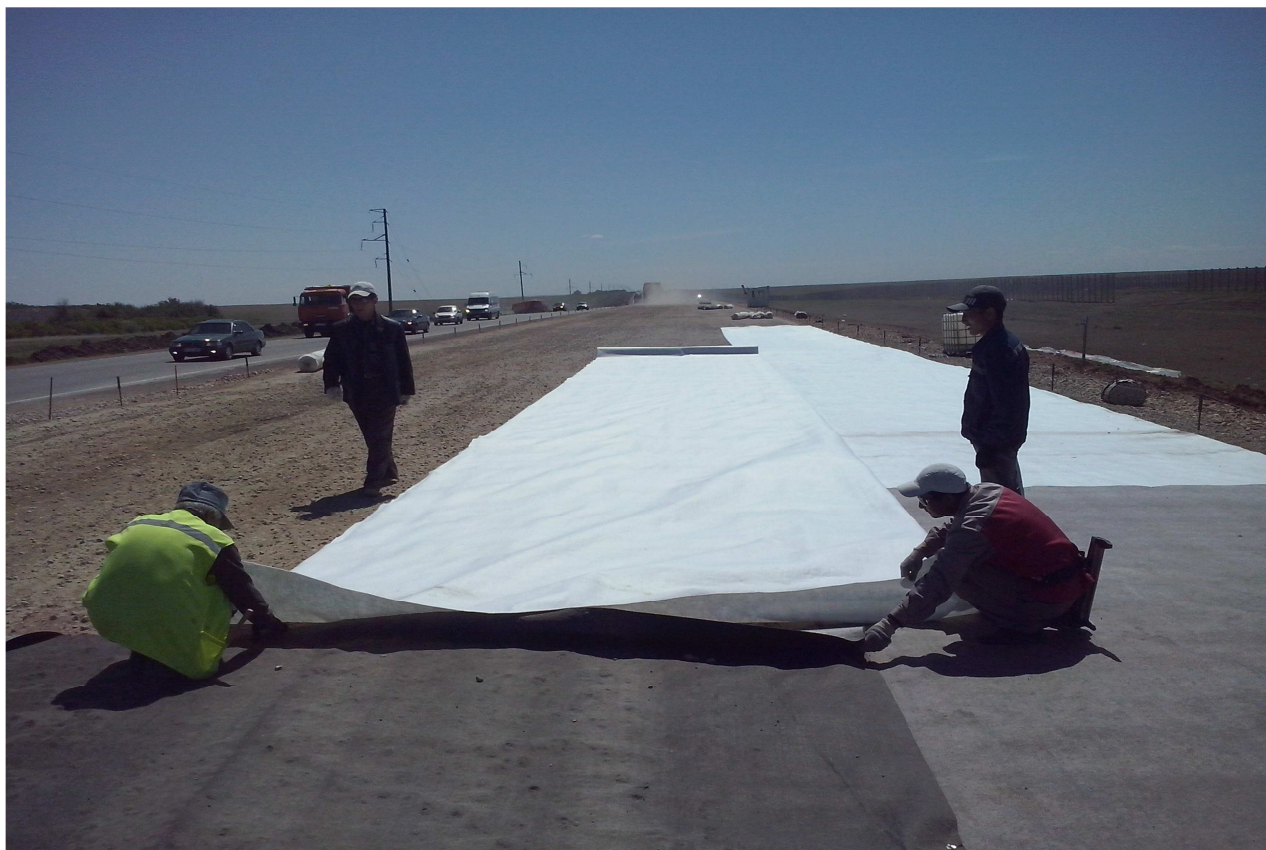
Рисунок 11 - Раскатка рулонов геокompозита на дорожное полотно
