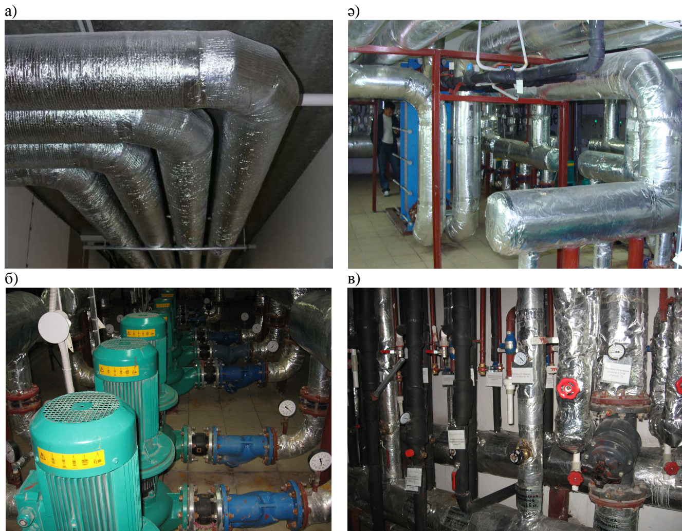
а – ауа өткізгіш жүйесі; ә – құбырлар жүйесі; б – қосымша жабдық; в – жабу және реттеу арматурасы
