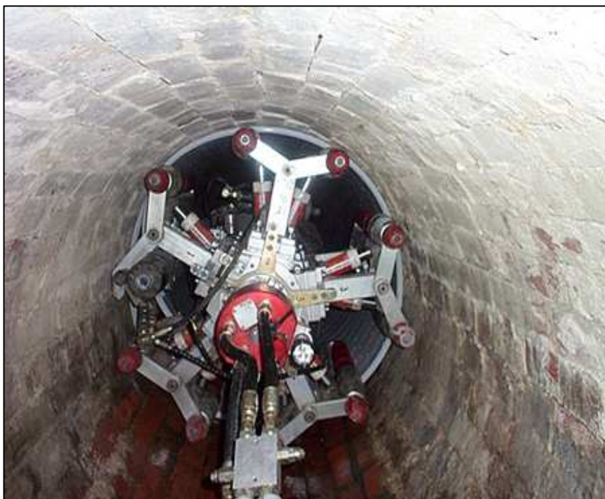
7-сурет - «Rotaloc» иіру машинасының жалпы түрі (қалпына келтірілетін коллектор ішінде)
