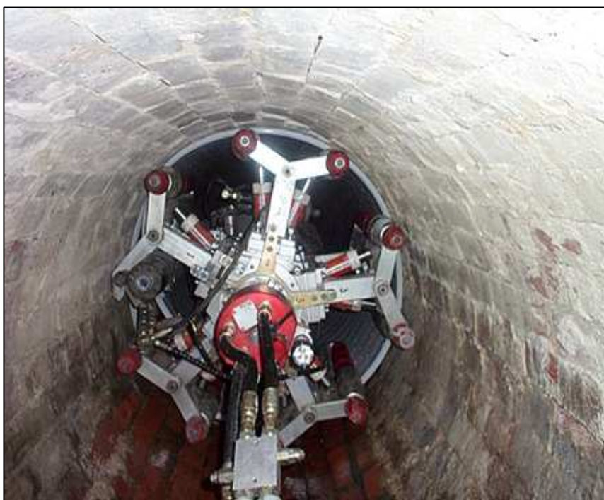
Рисунок 7 - Общий вид навивной машины (в восстанавливаемом коллекторе)
