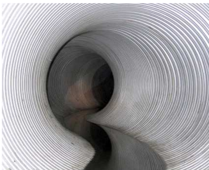
Рисунок 1 - Общий вид восстановленного трубопровода по спирально-навивной технологии
