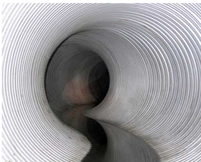
1-сурет - Спиральды-иіру технологиясы бойынша қалпына келтірілген ұбырдың жалпы қалпы
