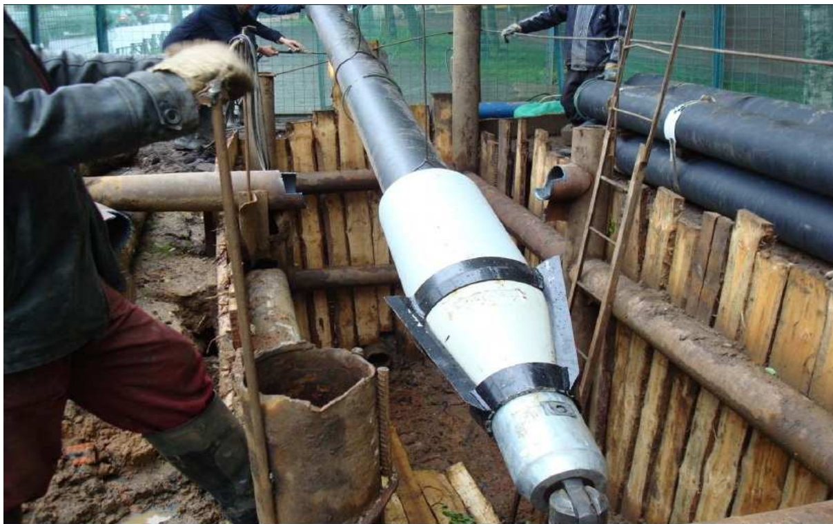
Рисунок 14 - Общий вид процесса опускания новой трубы с оснасткой (в сборе) в приемный котлован
