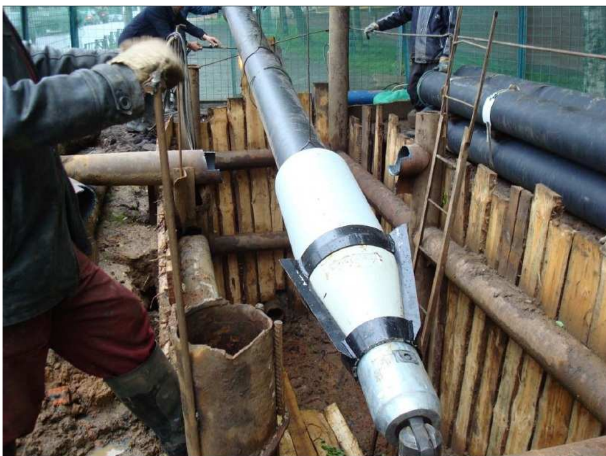
14-сурет - Жабдығы бар (жинақта) жаңа трубаны қабылдаушы котлованға түсіру үдерісінің жалпы көрінісі
