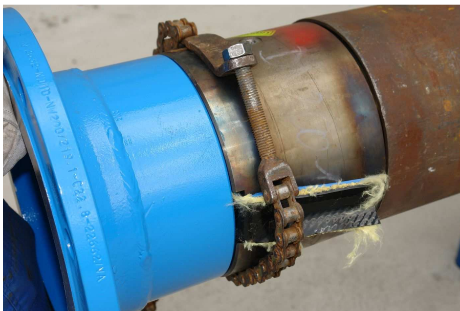
Рисунок 18 – Процесс установки внутренней втулки фитинга (оснащенного фланцем) в рукав
