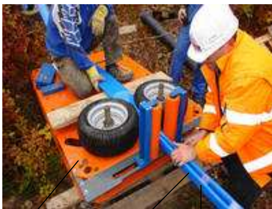
1 – құбыршекті бүктеуге арналған машина; 2 – қосылған құбыршек; 3 – желімді ленталарды орау
