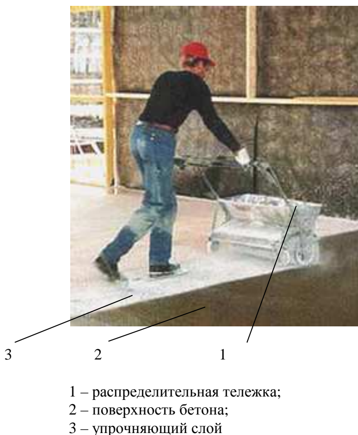
Рисунок 4 – Нанесение упрочняющего слоя
