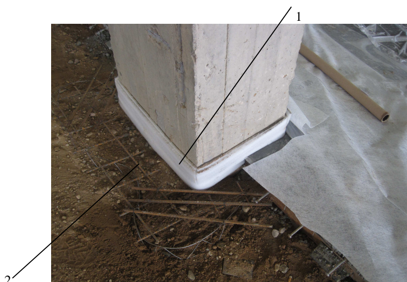
1 – изоляция из полос поролона; 2 – арматурные сетки
