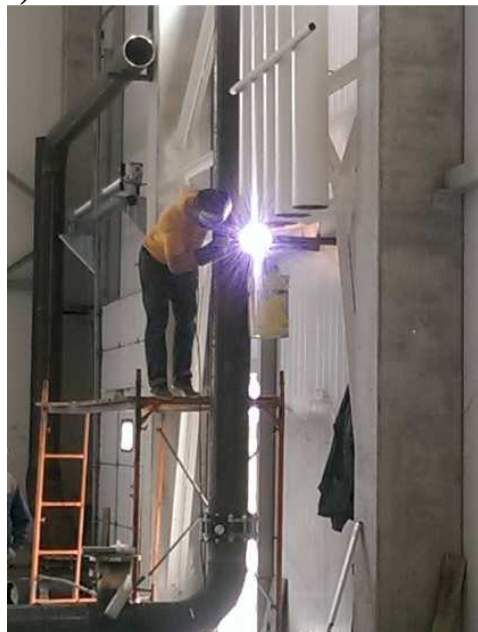
а – құбырлар монтажи; б – құбырлар жапсарларын дәнекерлеу
