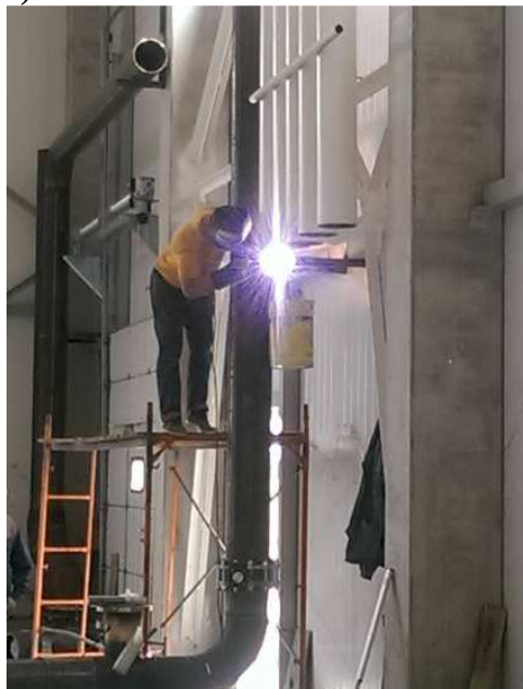
а – монтаж трубопроводов; б – сварка стыков трубопроводов
