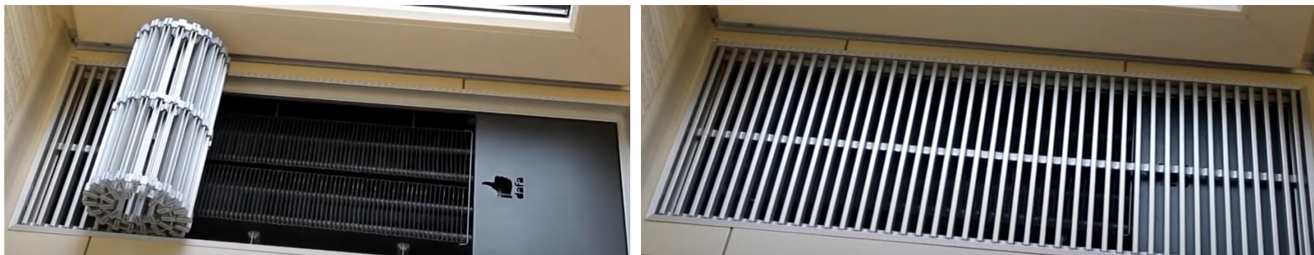
Рисунок 2.8 – Установка декоративного профиля окантовки корпуса
