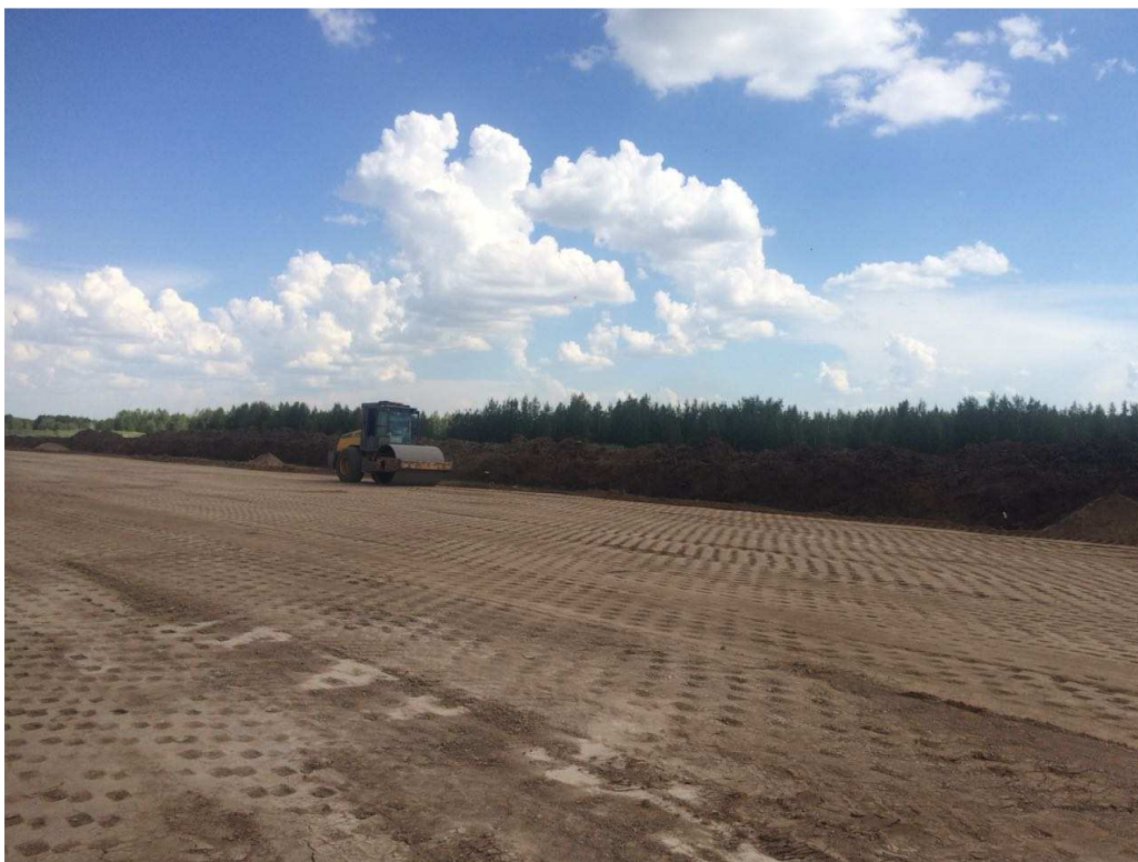
Рисунок 5 - Уплотнение грунтовых оснований вибрационными катками (а,б,в,г)
