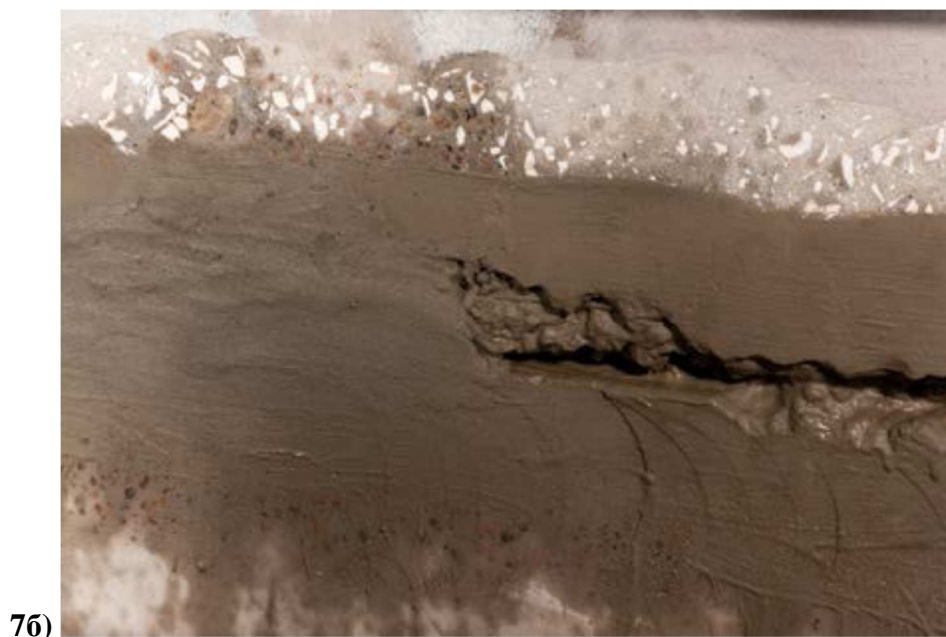
Рисунок 7а, 7б. – Заполнение штрабы гидроизоляционным шовным составом вручную
