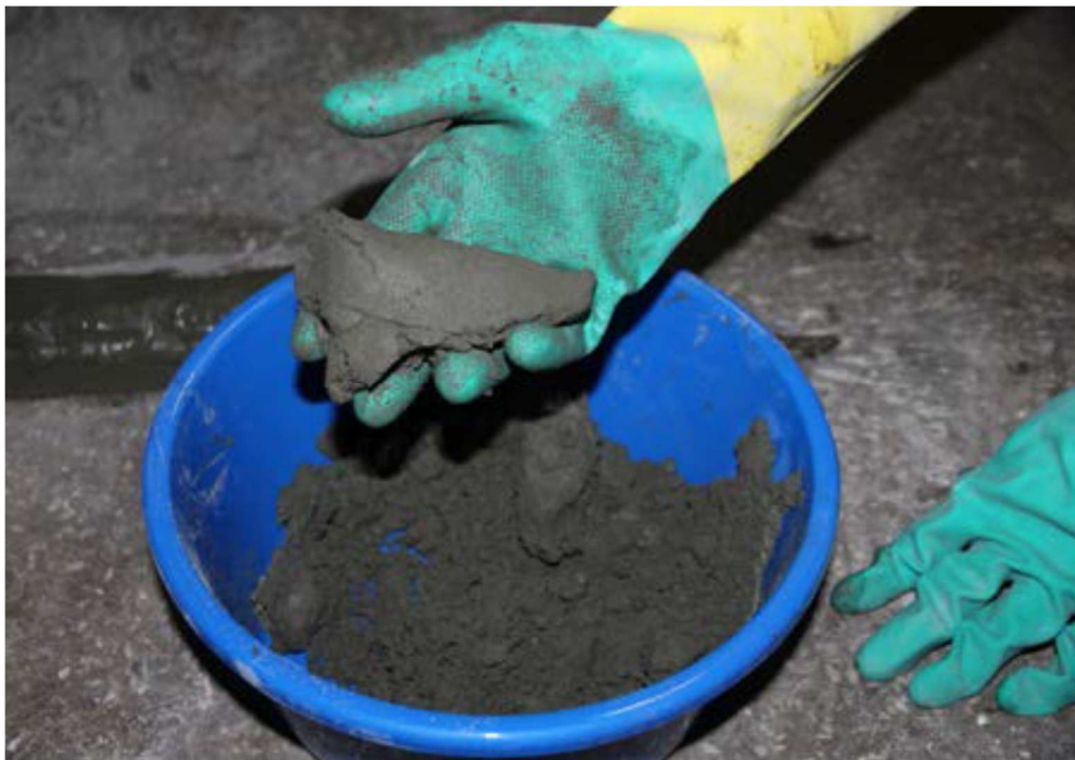
Рисунок 6а, 6б. - Приготовление гидроизоляционного шовного состава
