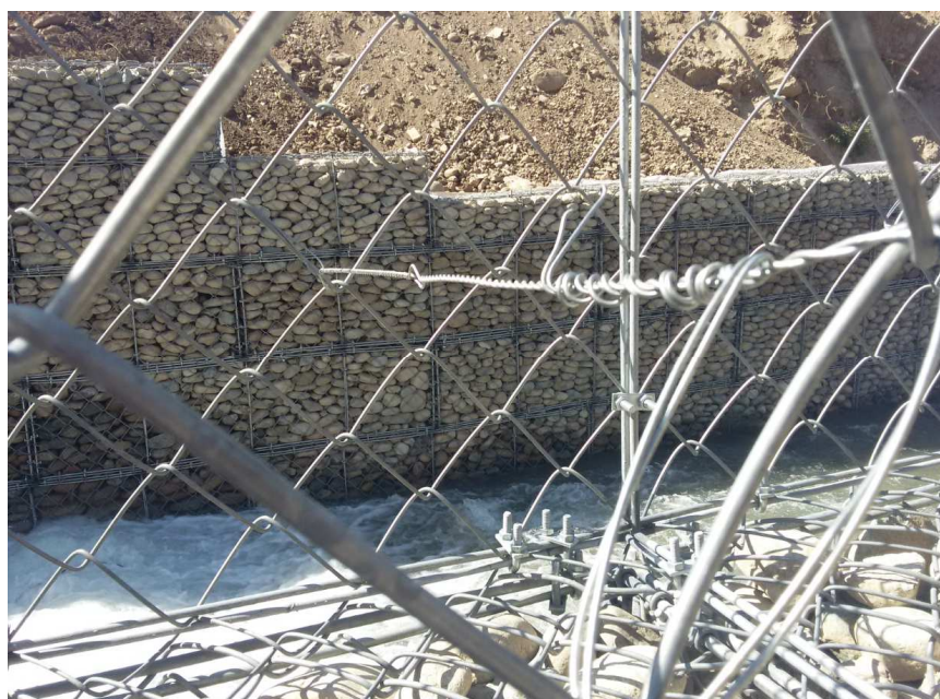
Рисунок 12 - Устройство распорок в коробчатых габионных сетчатых изделиях
