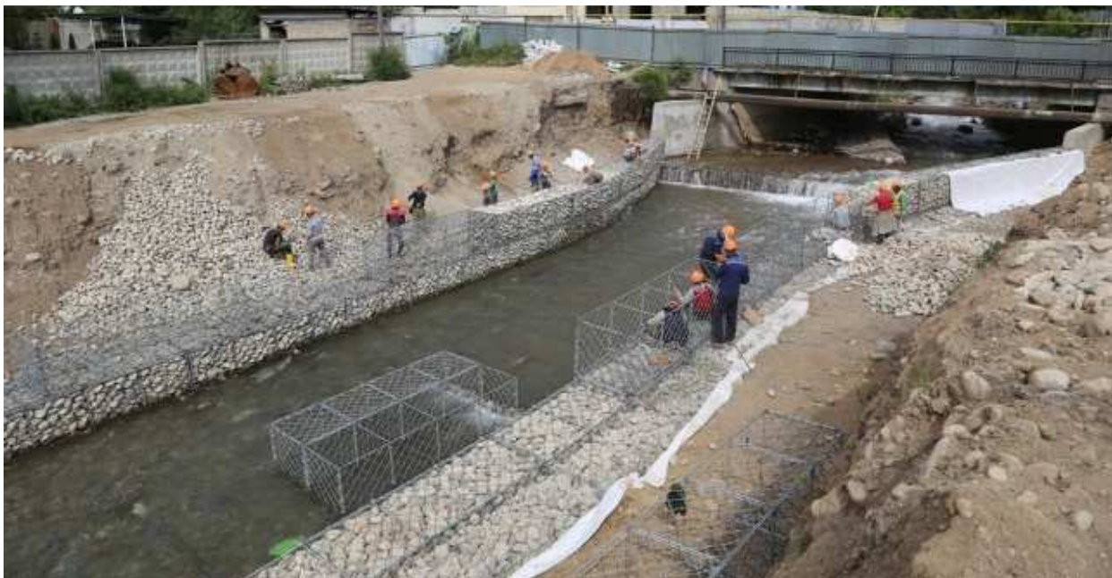
Рисунок 6 - Формирование сооружения из коробчатых габионных конструкции
