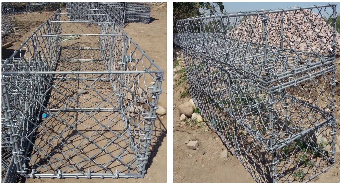
Рисунок 4 - Общий вид коробчатого габиона в собранном состоянии
