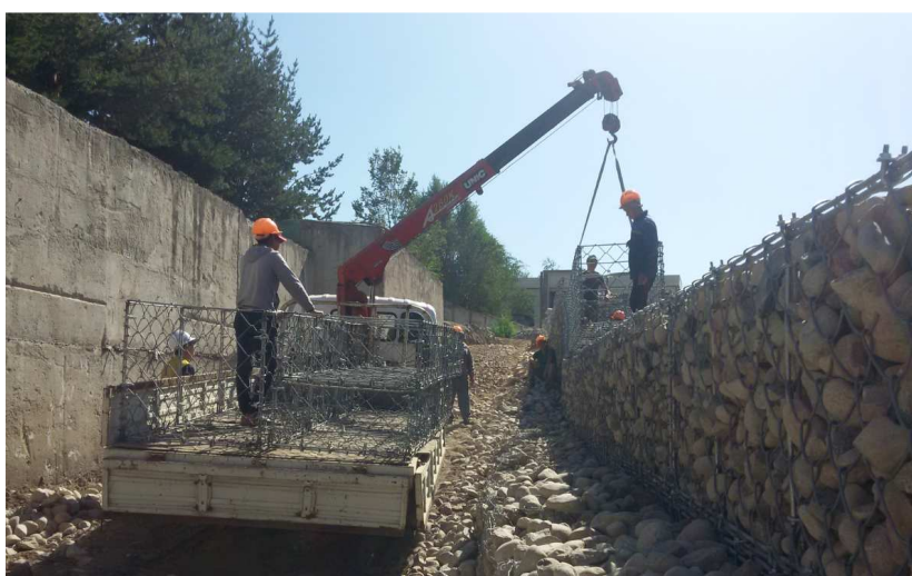
Рисунок 7 - Подъем и установка габионных сетчатых изделий
