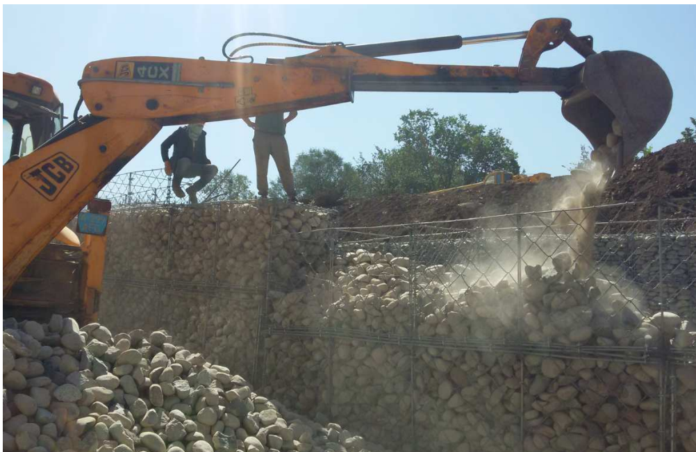
Рисунок 11 - Подача камня в тело коробчатых габионных сетчатых изделий механизированным способом
