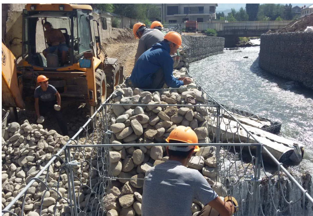
Рисунок 10 - Выкладка камня по стенкам габбионного сетчатого изделия вручную
