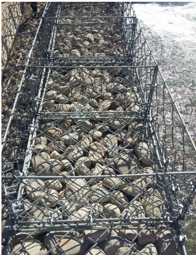
Рисунок 9 – Смонтированное габионное сетчатое изделие
