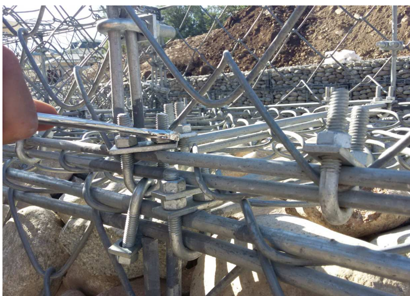
Рисунок 8 - Скрепление на U- образные скобы с нижним каркасом габионов
