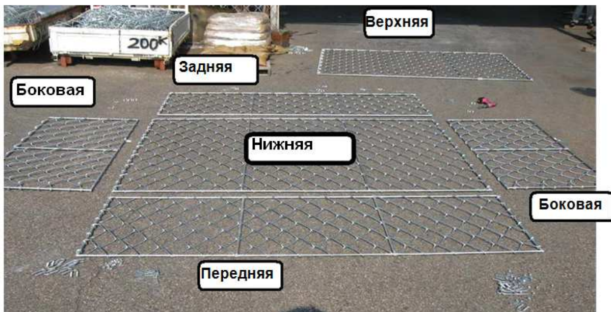
Рисунок 1 – Общий вид коробчатого габиона в развернутом состоянии
