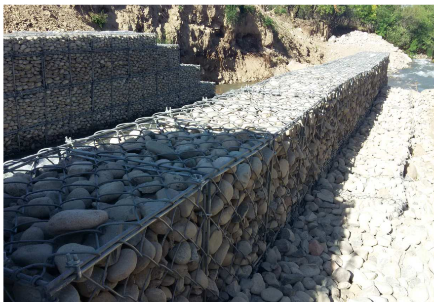
Рисунок 14 - Смонтированная габионная конструкция
