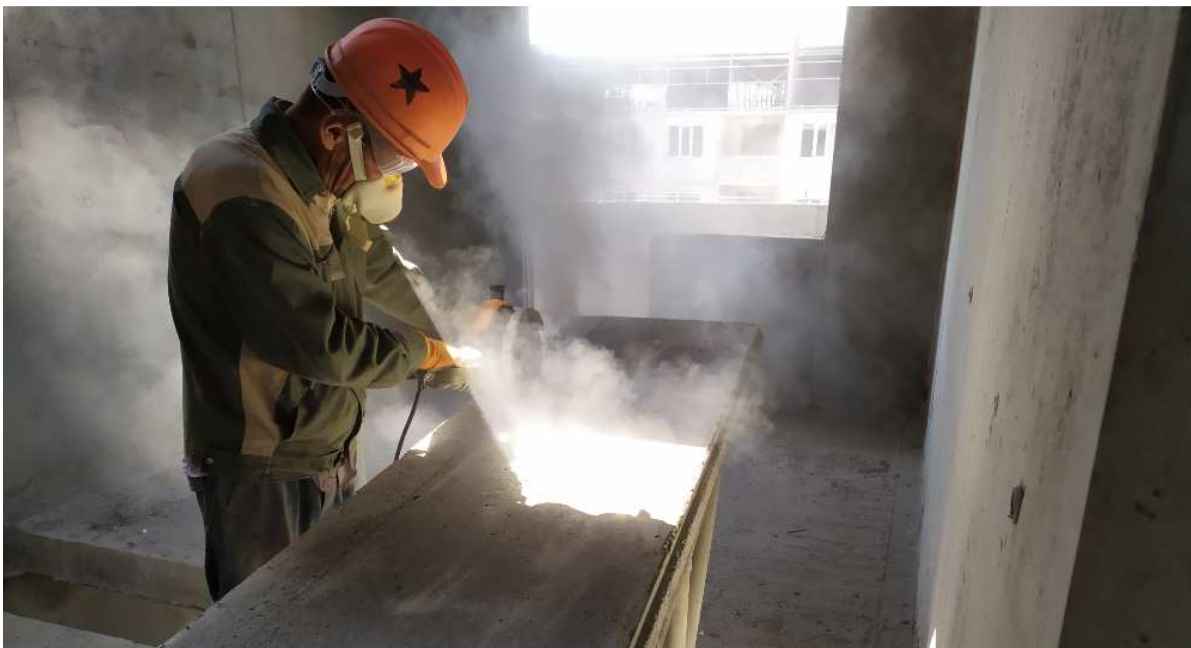
Рисунок 11 – Резка стеновых панелей
