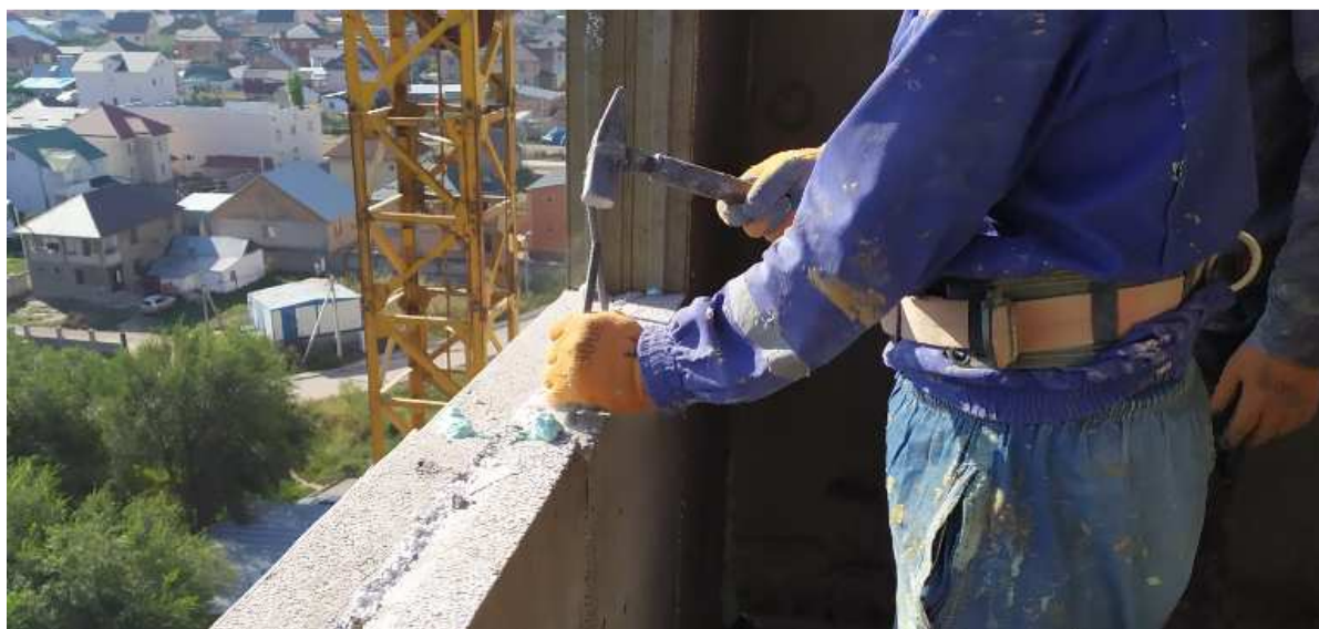
Рисунок 14 – Скрепление стеновых панелей арматурными стержнями
