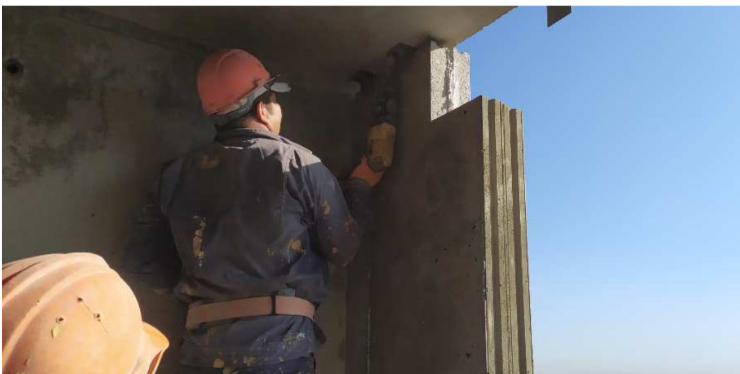
Рисунок 12 – Фиксация стеновой панели уголком с внутренней стороны
