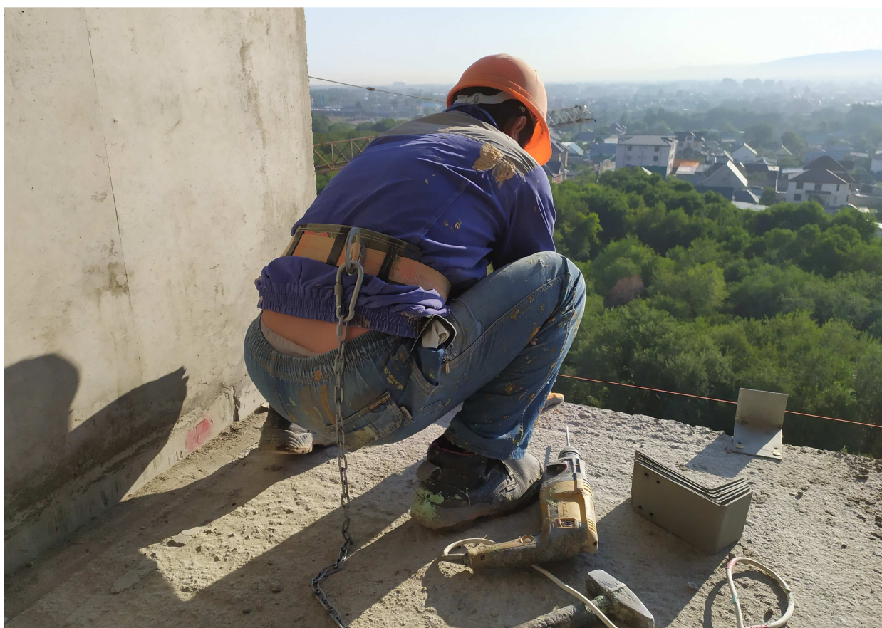
Рисунок 10 - Закрепление фиксирующих уголков
