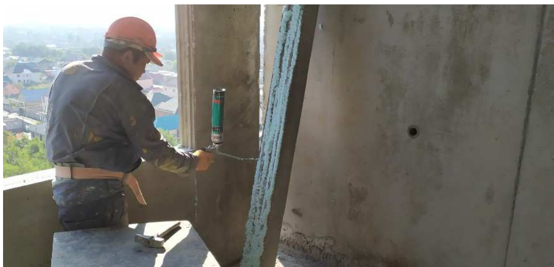
Рисунок 13 – Нанесение клей пены
