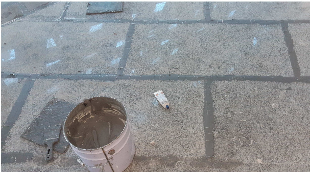
Рисунок 17 – Завершенный процесс затирки швов мраморных и гранитных плит
