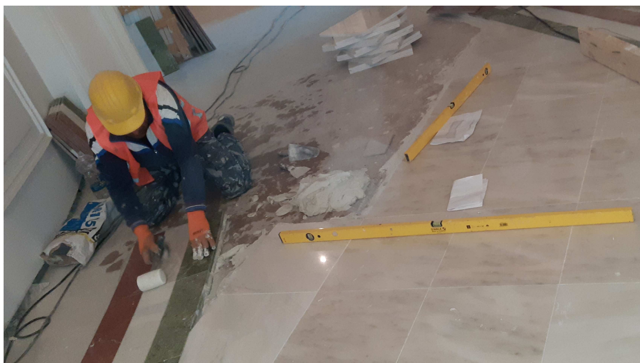
Рисунок 15 – Процесс укладки плит на клеевый раствор
