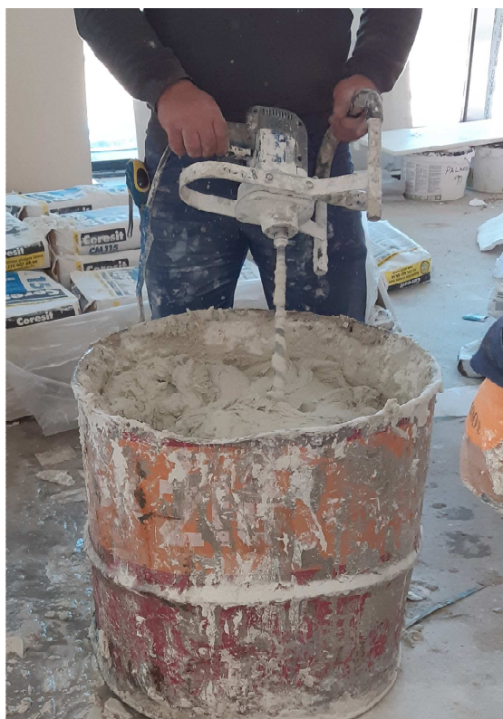
Рисунок 14 - Приготовление клеевого раствора электромиксером
