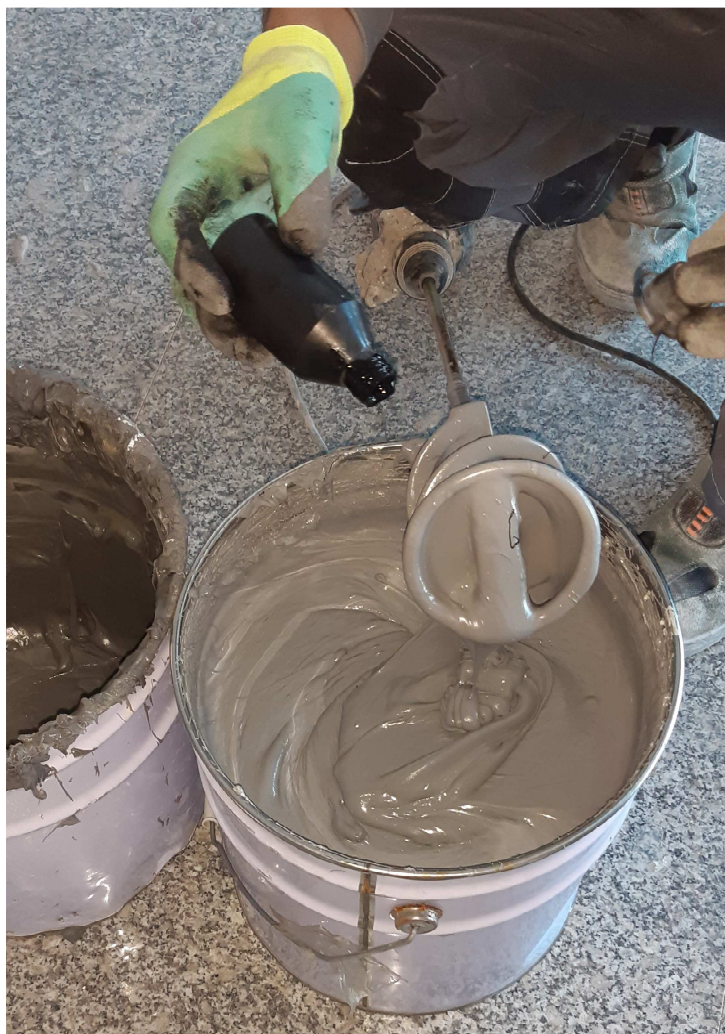
Рисунок 16 – Приготовление смеси для затирки швов
