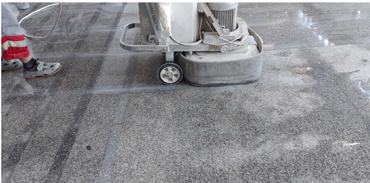
Рисунок 18 – Шлифование напольного покрытия
