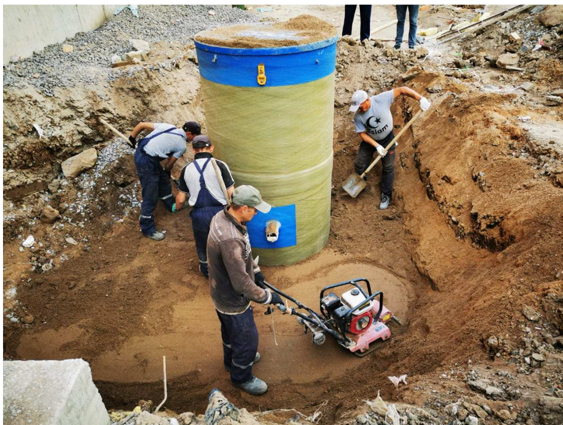
Рисунок 4 – Установка жируловителя
