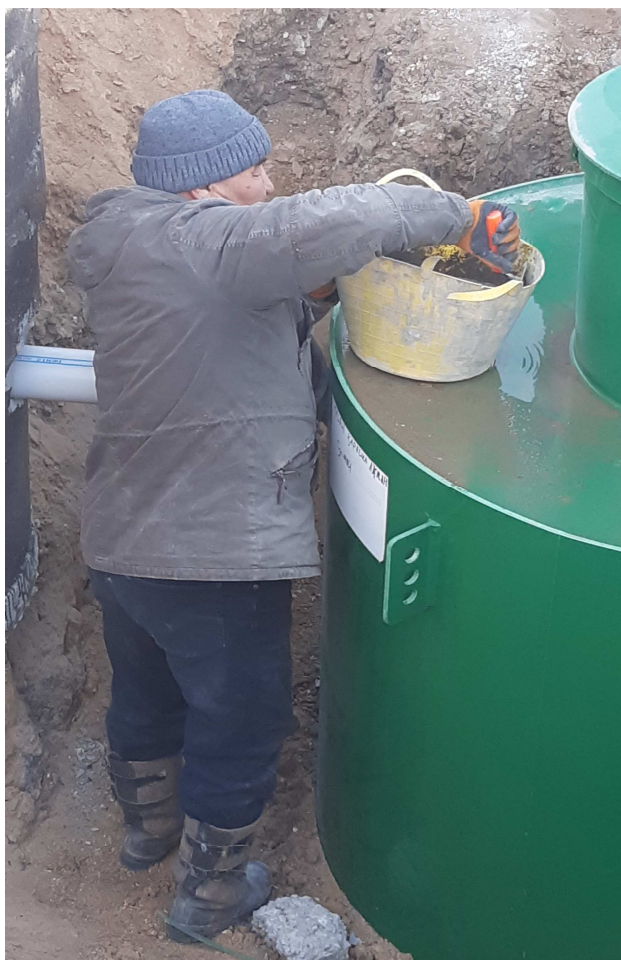
Рисунок 5 – Монтаж трубы между жируловителем и ж/б колодцем с заделкой отверстий
