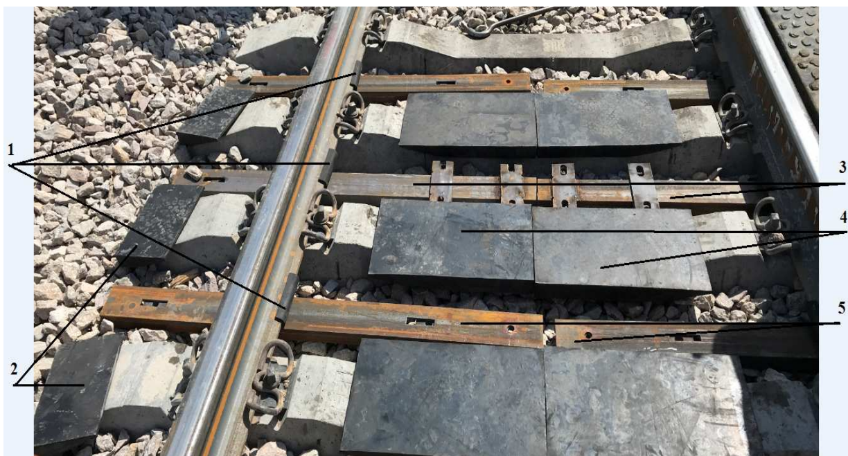
Рисунок 16 – Смонтированные элементы крепления и вкладышей для монтажа резинокордовых плит
