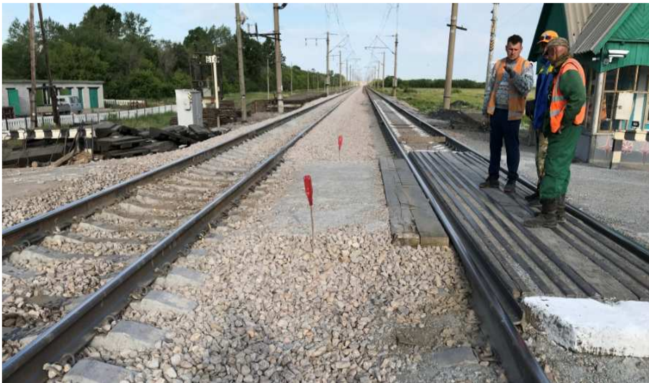
Рисунок 14 - Начальный вид железнодорожного переезда до монтажа настилов резинокордовых
