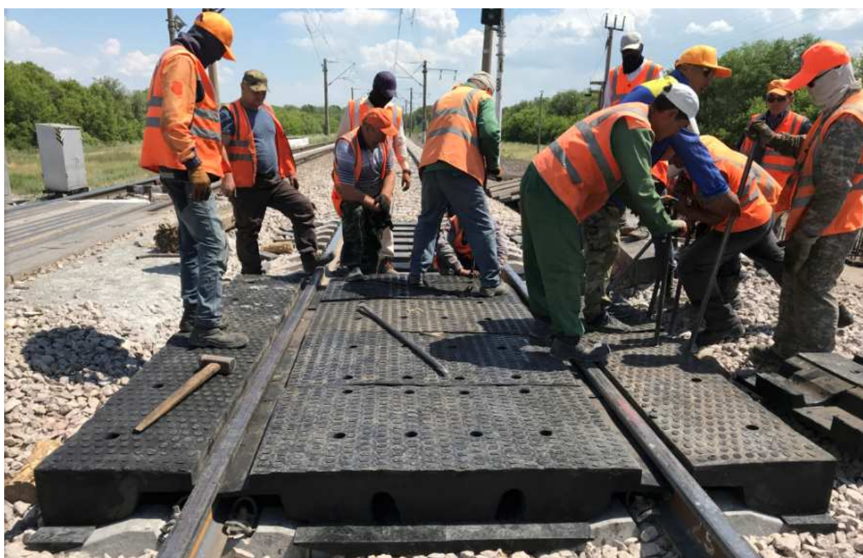
Рисунок 22 – Процесс монтажа настила переезда
