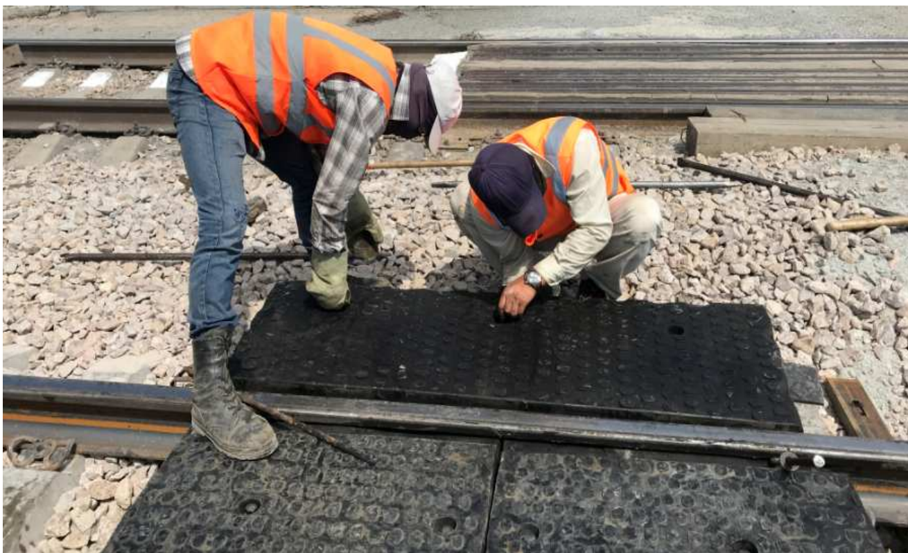
Рисунок 21 – Монтаж наружной плиты
