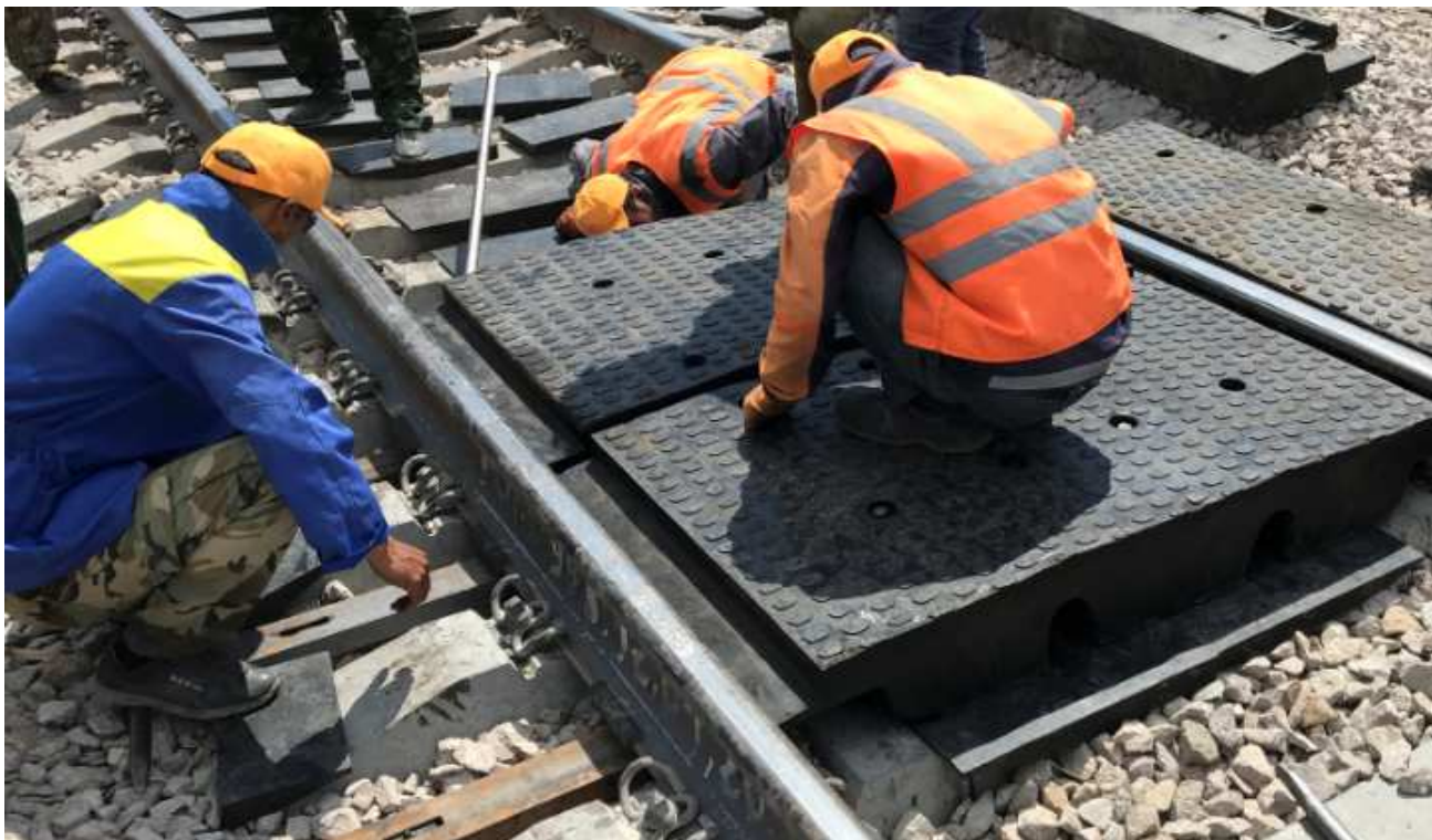
Рисунок 20 – Монтаж второй внутренней плиты
