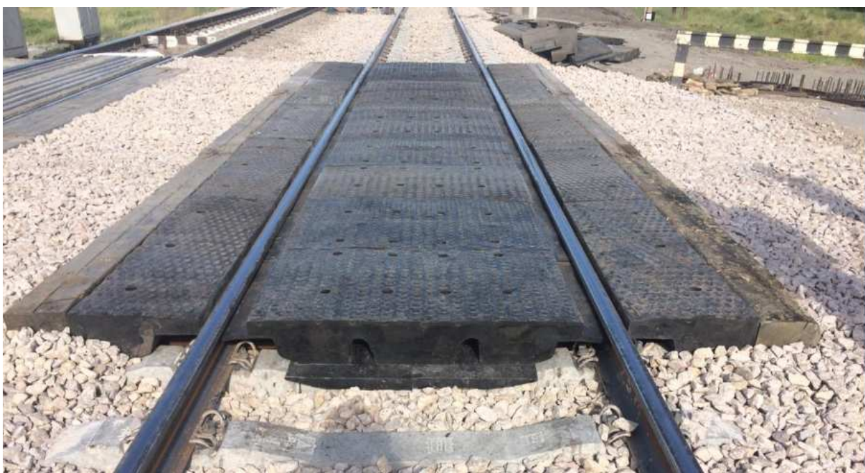
Рисунок 23 – Общий вид железнодорожного переезда из резинокордовых плит
