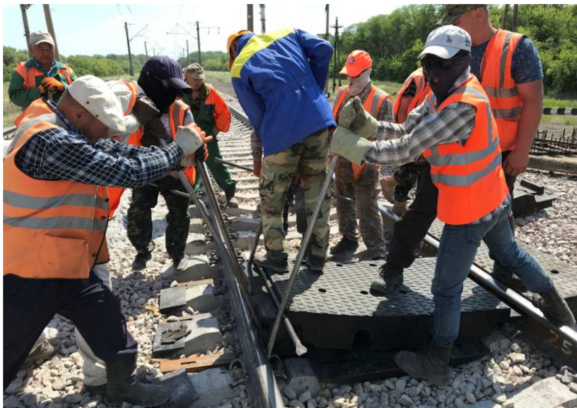
Рисунок 18 – Запрессовка под головку рельсы внутренней плиты
