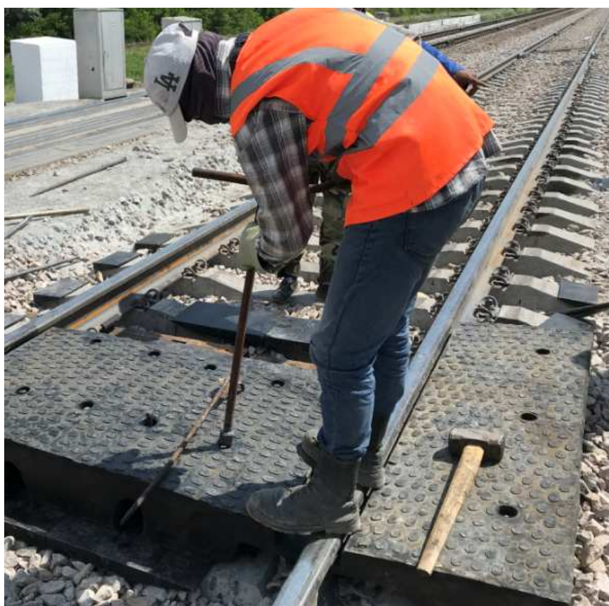
Рисунок 19 – Затягивание болтов на внутренней плите
