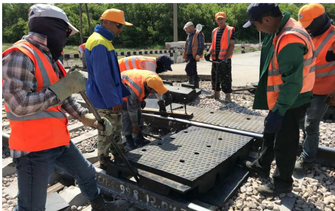
Рисунок 17 – Монтаж первой внутренней плиты
