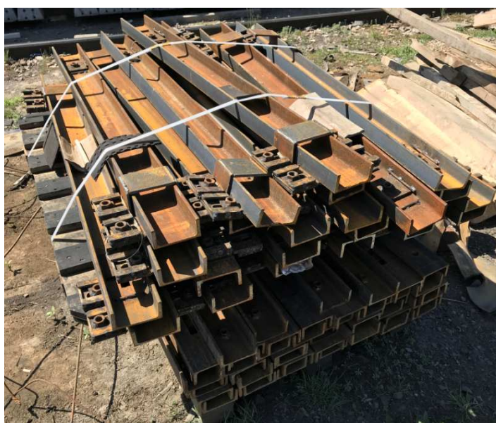
Рисунок 7 – Складирование резинокордовых плит и швеллеров-прижимов
