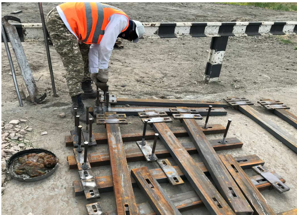
Рисунок 13 - Компоновка и сборка прижимов (тип 2) для крепления настилов
