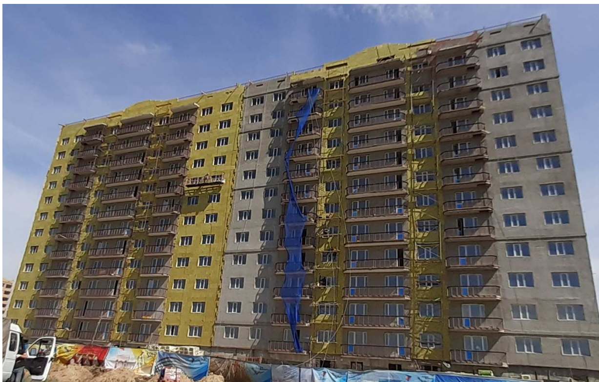
Рисунок 15 – Общий вид утепления стены здания при СФТК
