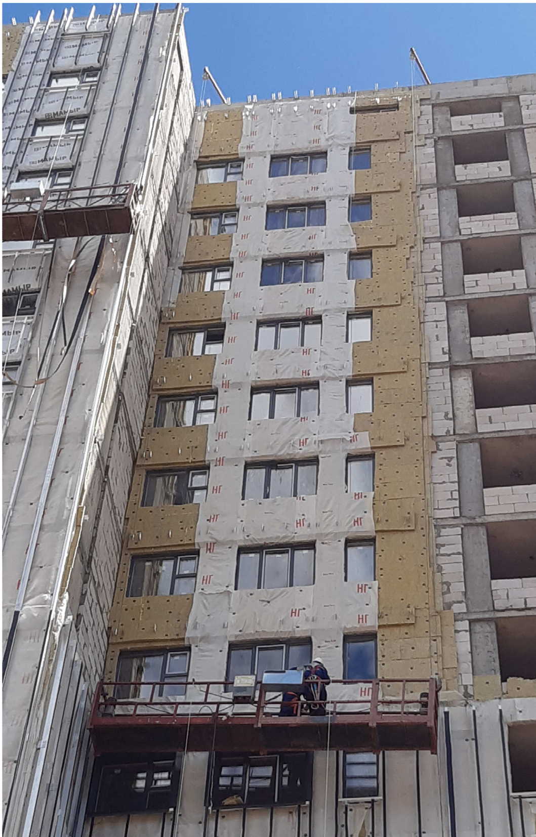
Рисунок 12 – Устройство ветро-влажностной пленки на поверхность утеплителя
