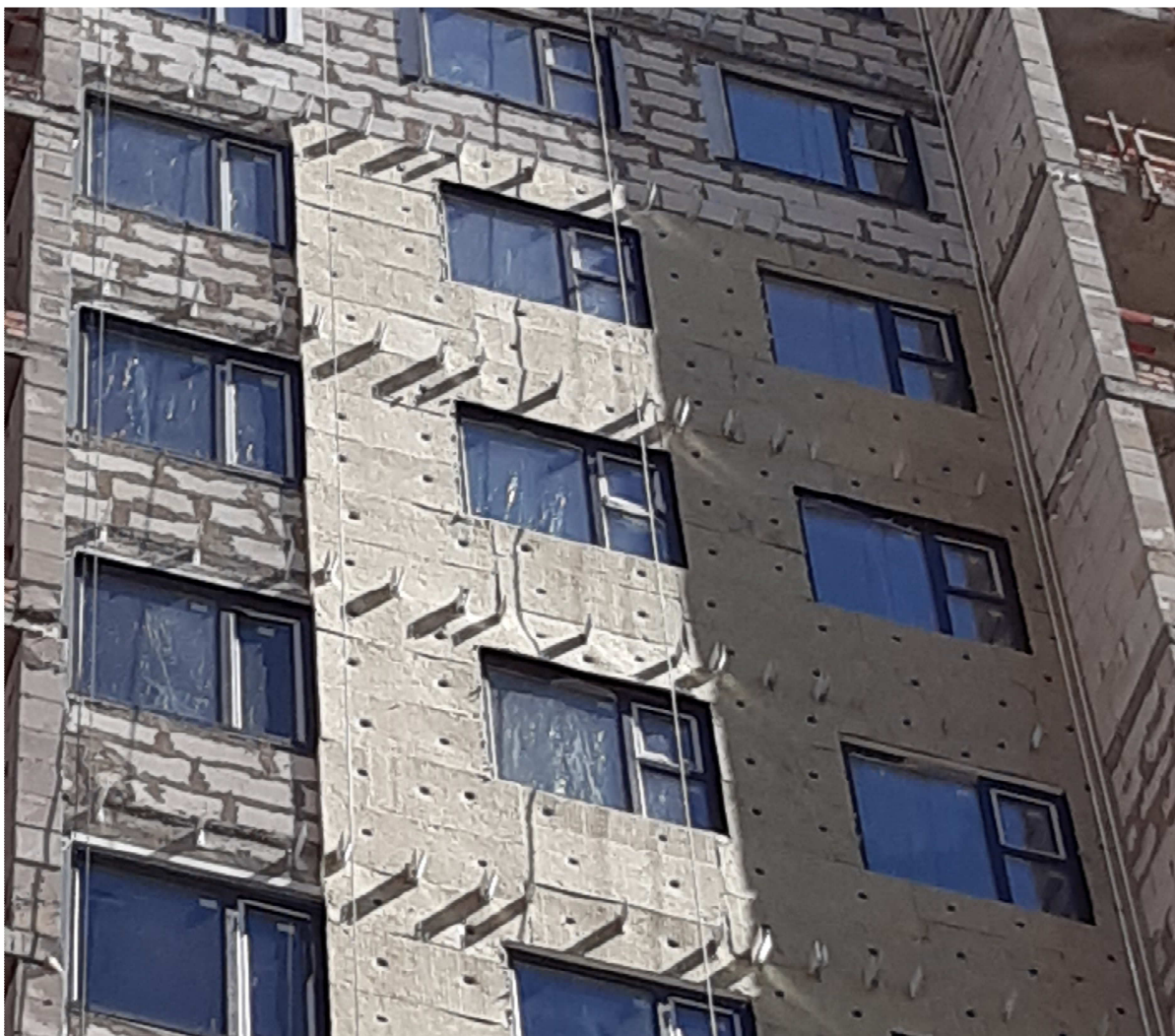
Рисунок 8 – Устройство 1-го слоя утеплителя
