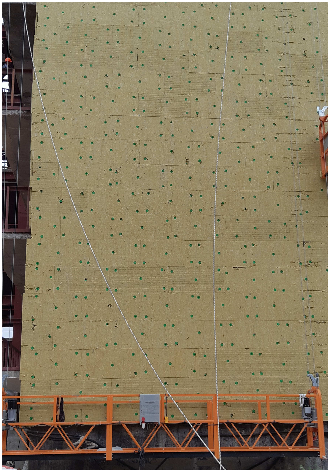
Рисунок 14 – Устройство 2-го слоя утеплителя плитами минваты при СФТК
