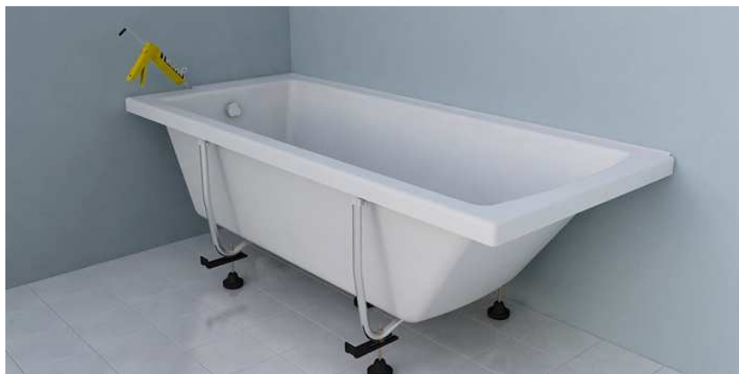
Рисунок 30 – Герметизация стыка ванны со стеной
