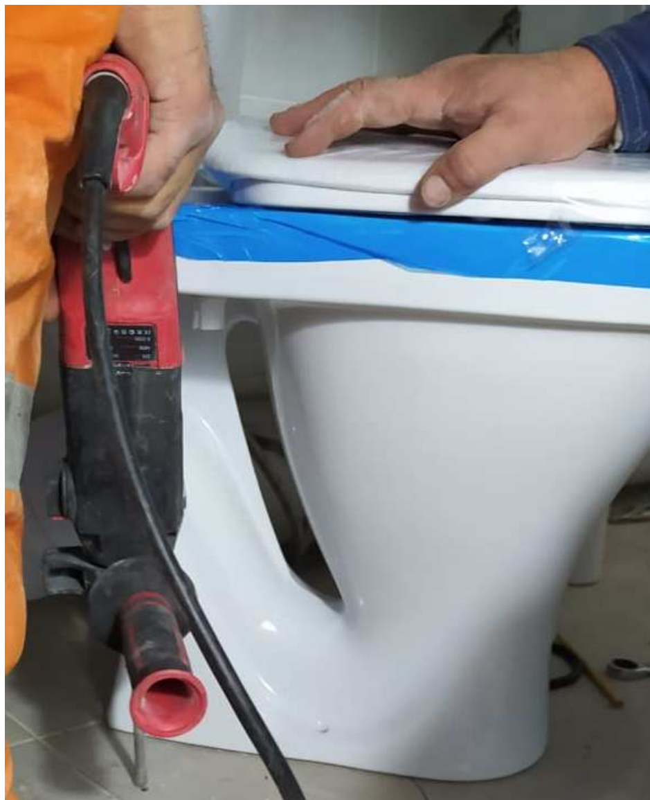
Рисунок 24- Сверление отверстий
