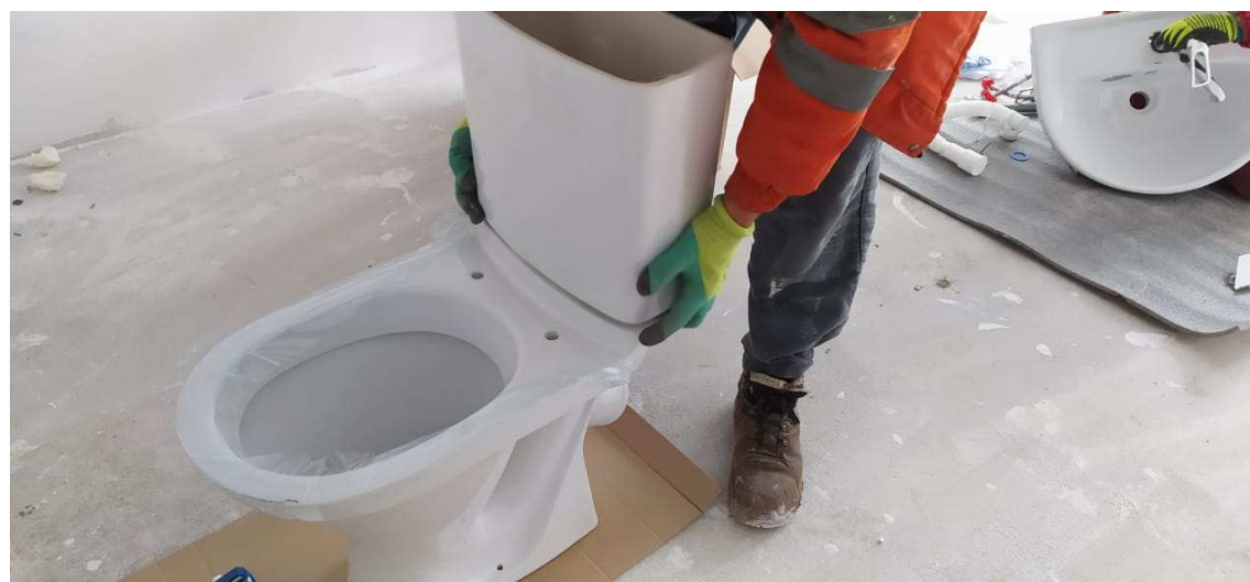
Рисунок 22- Сборка и установка смывного бачка
