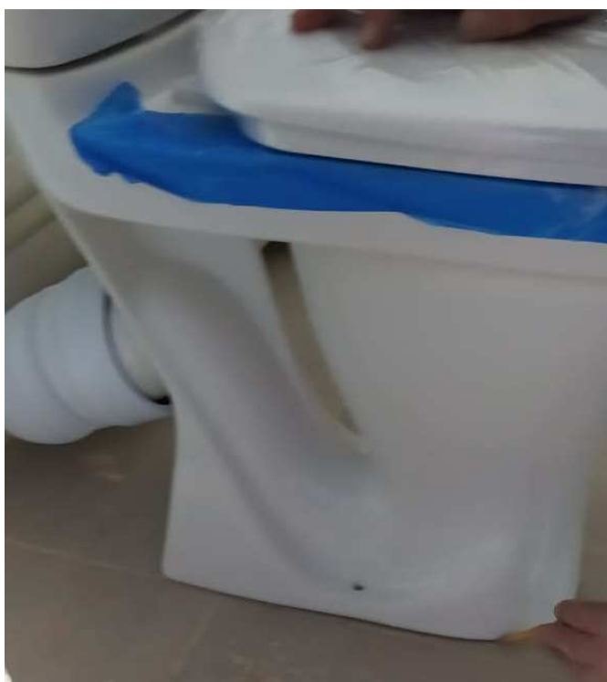
Рисунок 23- Установка гофрированной трубы и разметка
