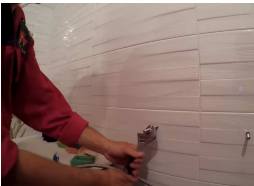
Рисунок 32 – Закручивание шпилек
