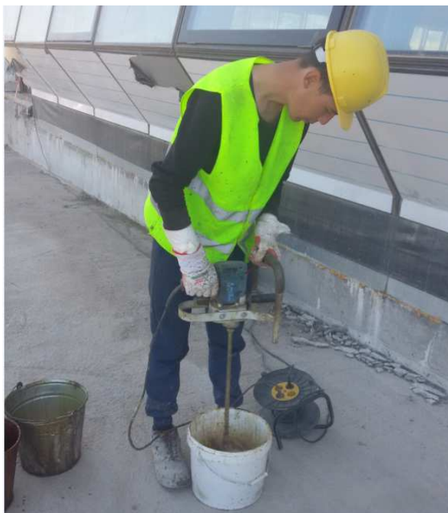
Рисунок 4 – Смешивание грунтовки
