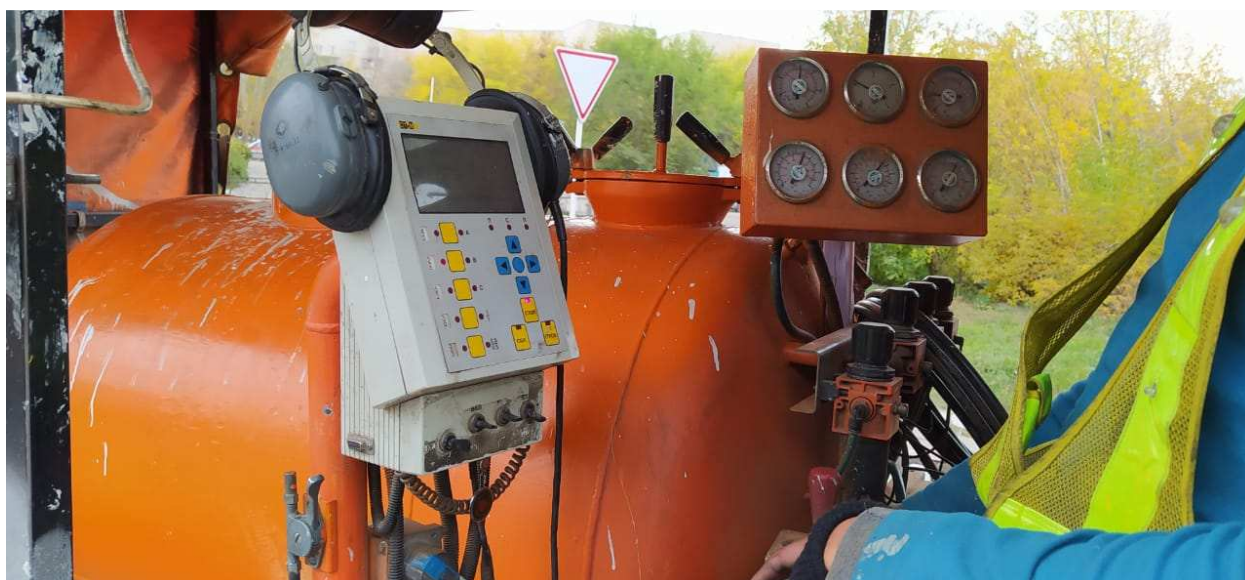
Рисунок 4 – Нанесение продольной разметки
