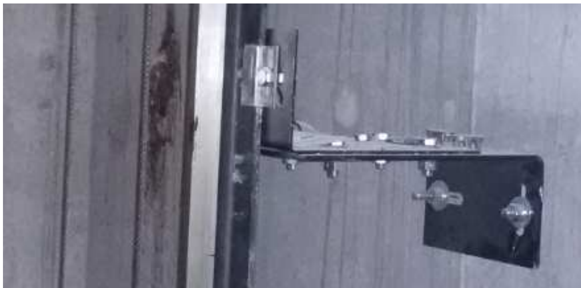
Рисунок 41 – Промежуточный кронштейн противовеса
