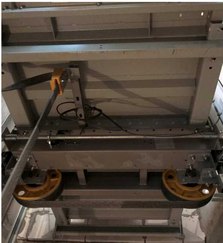
Рисунок 34 – Монтаж (запасовка) канатов для лифтов с без машинным отделением
