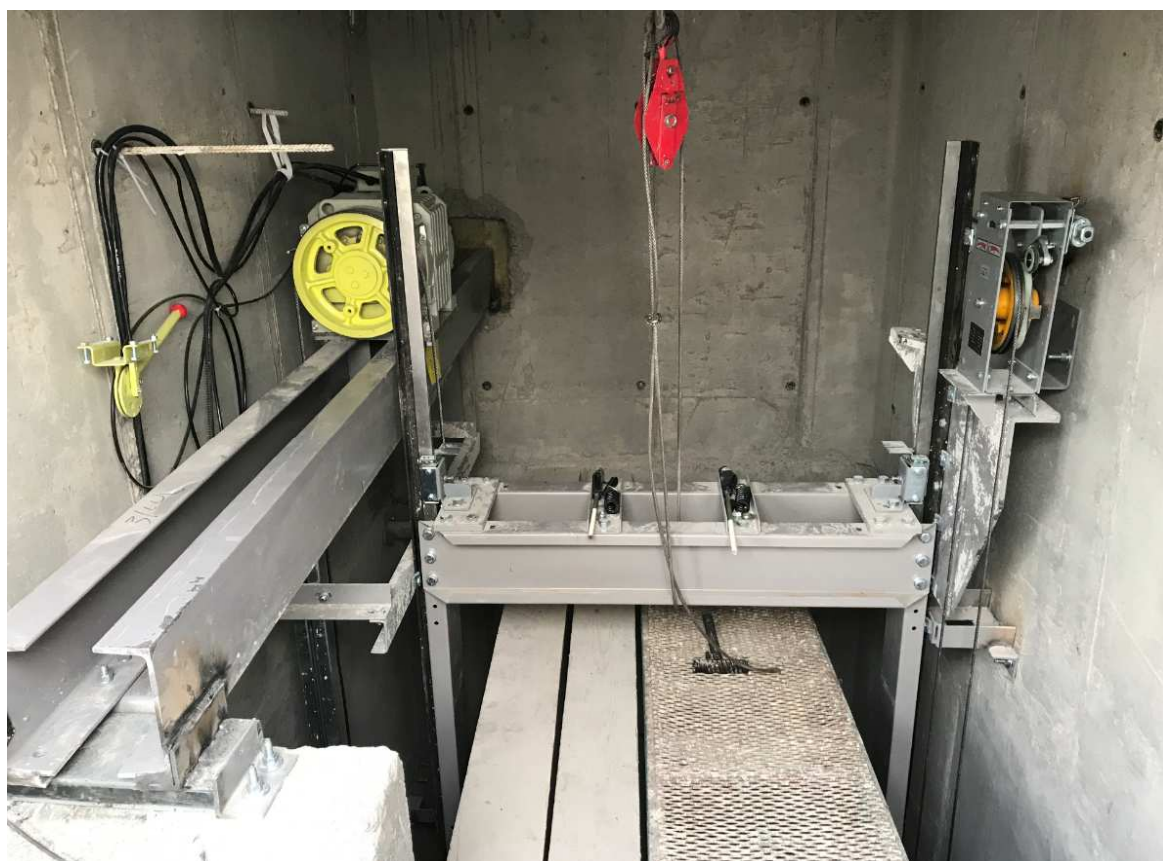
Рисунок 32 – Монтаж (запасовка) канатов для лифтов с машинным отделением а - запасанный шкив на каркасе кабины, б – общий вид запасовки канатов
