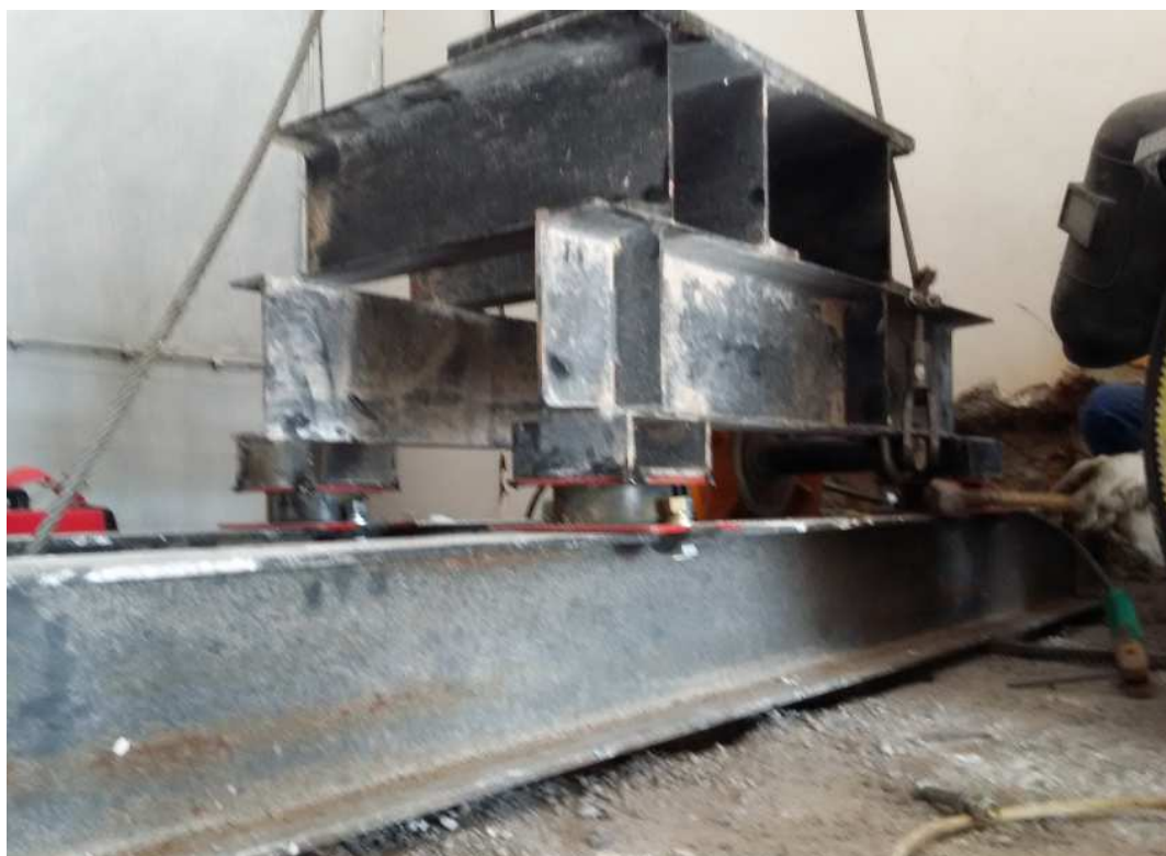
Рисунок 27 – Монтаж станины лифтовой лебедки
