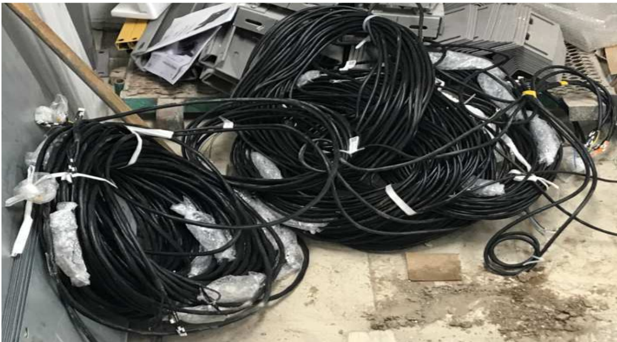
Рисунок 51 – Общий вид бухт электропроводки до монтажа
