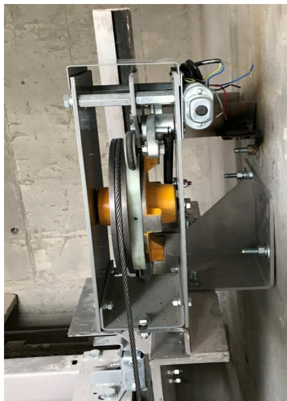
Рисунок 42 – Общий вид ограничителя скорости
