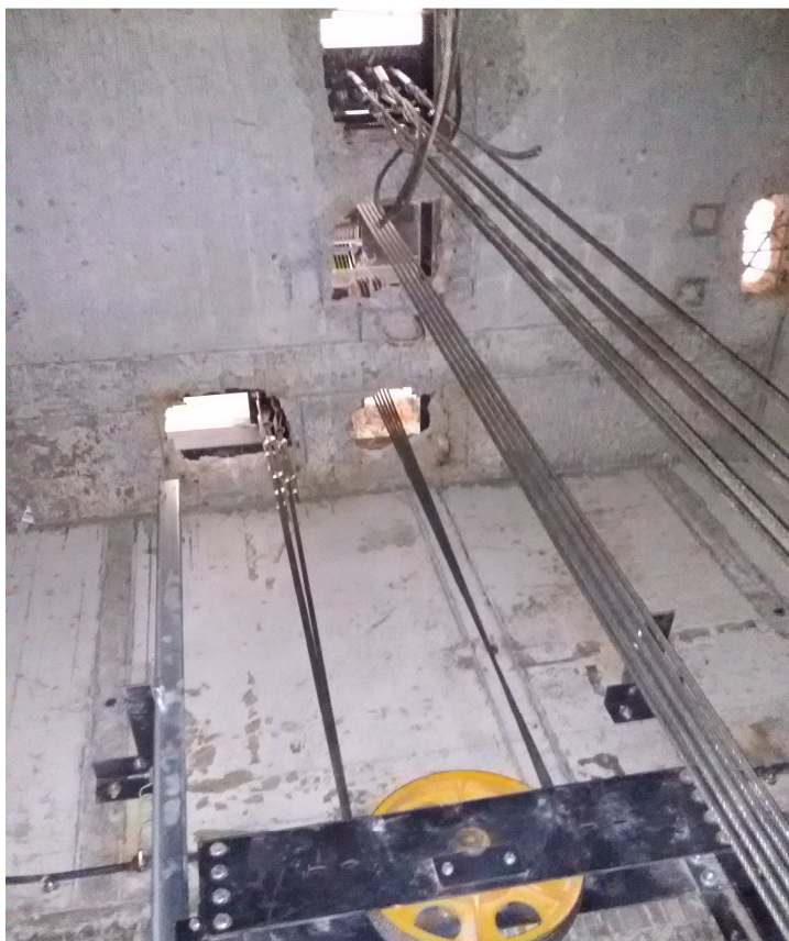
Рисунок 32 – Монтаж (запасовка) канатов для лифтов с машинным отделением а - запасанный шкив на каркасе кабины, б – общий вид запасовки канатов
