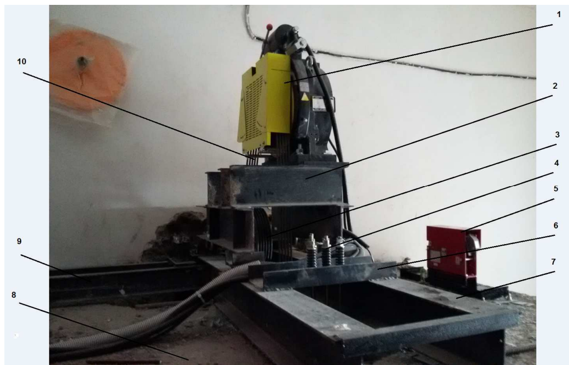
Рисунок 30 – Лифтовая лебедка после монтажа
