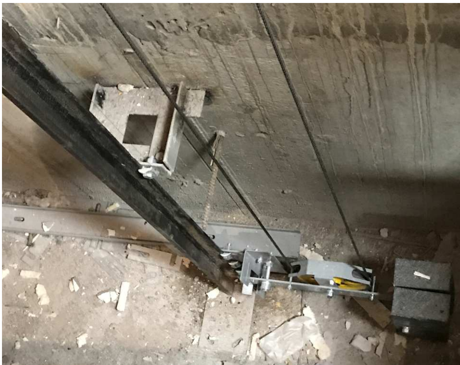
Рисунок 43 – Кронштейн ограничителя скорости с отводным блоком в приемке шахты
