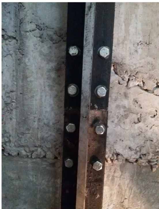
Рисунок 15 – Стык направляющих кабины и противовеса
