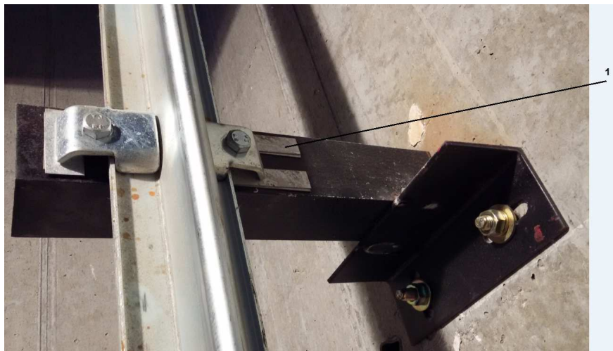
Рисунок 40 – Закрепленная направляющая
