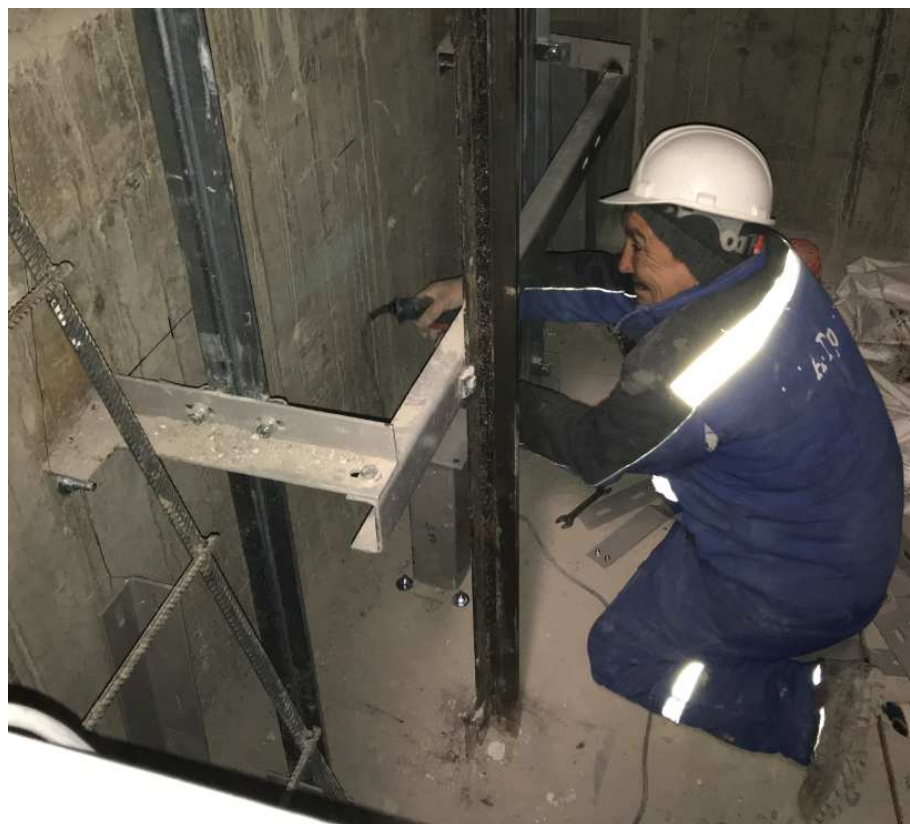
Рисунок 35 – Монтаж в прямке шахты лифта гидравлические буфера кабины и противовеса
