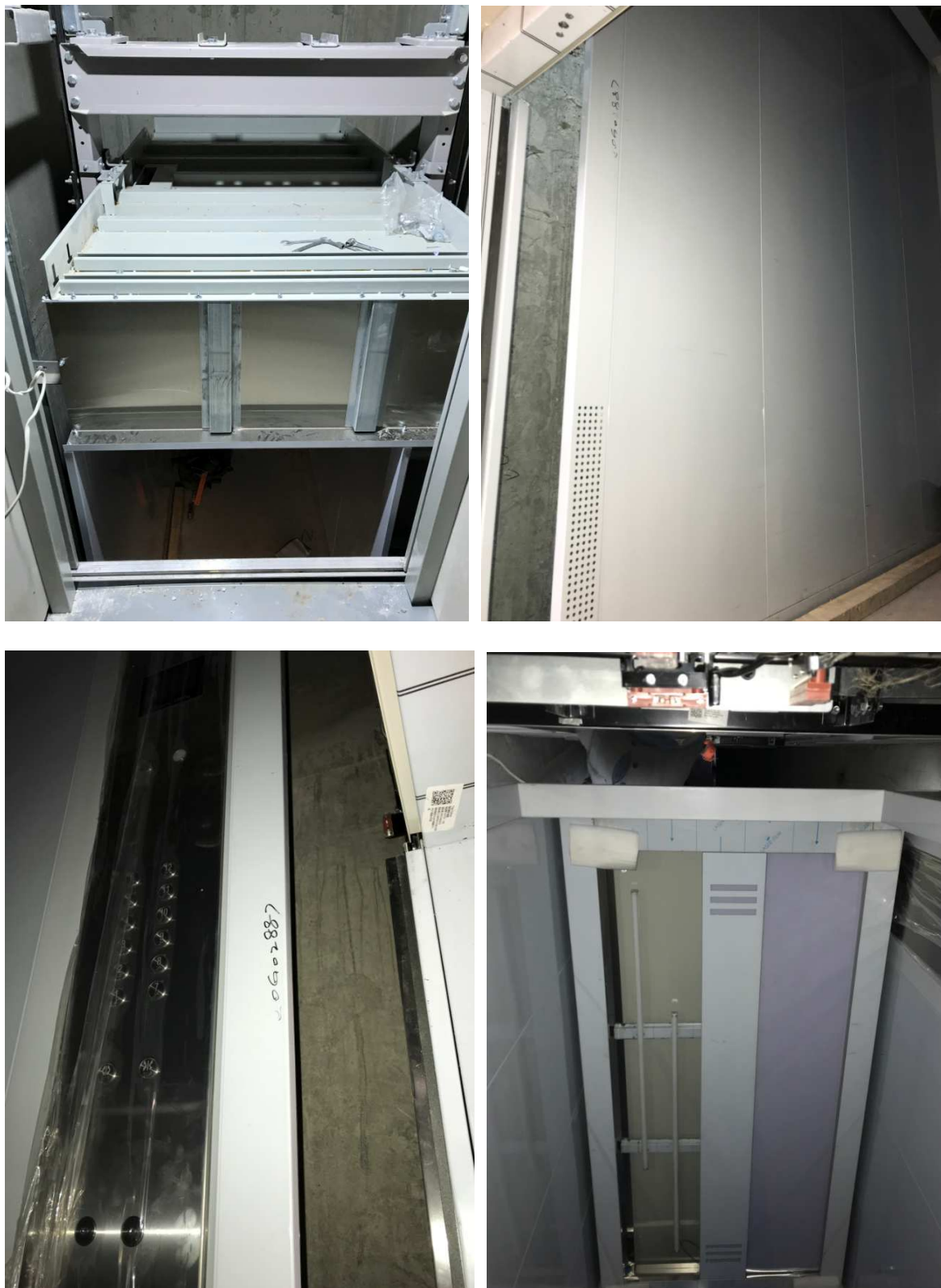
Рисунок 55 – Монтаж ограждающих стенок купе
