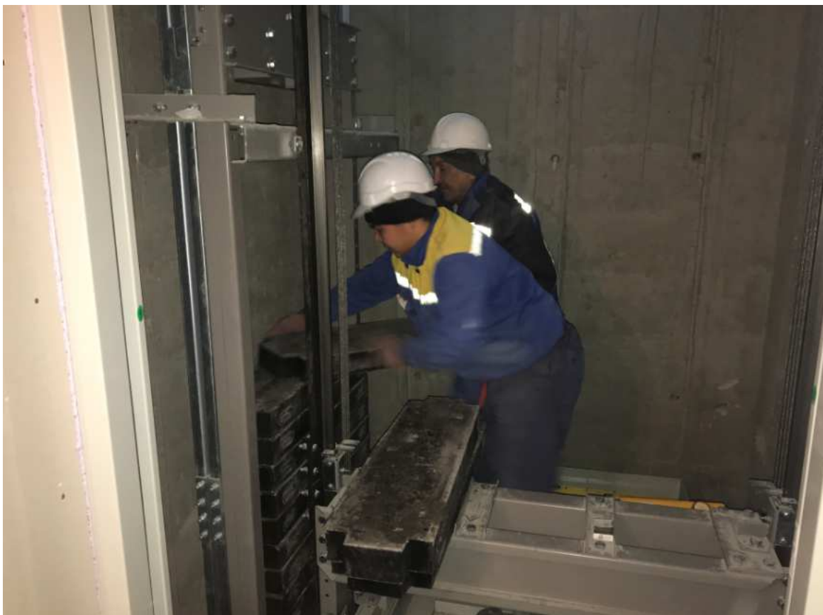
Рисунок 24 – Частичная загрузка противовеса
