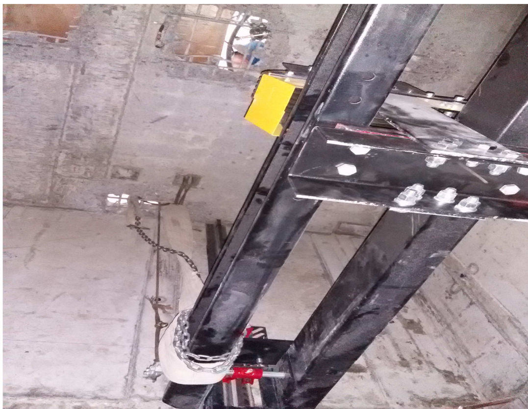
Рисунок 22 – Грузы противовеса
