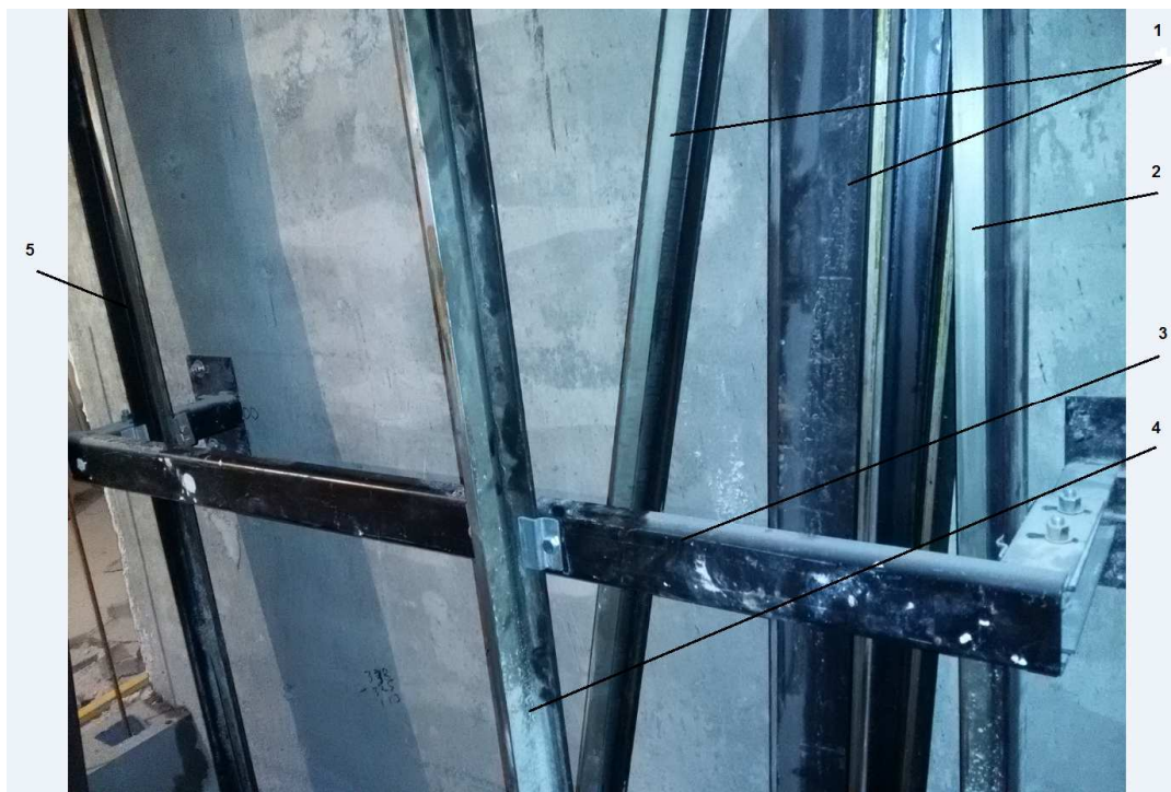
Рисунок 17 – Направляющие кабины и противовеса в шахте лифта при боковом расположении противовеса
