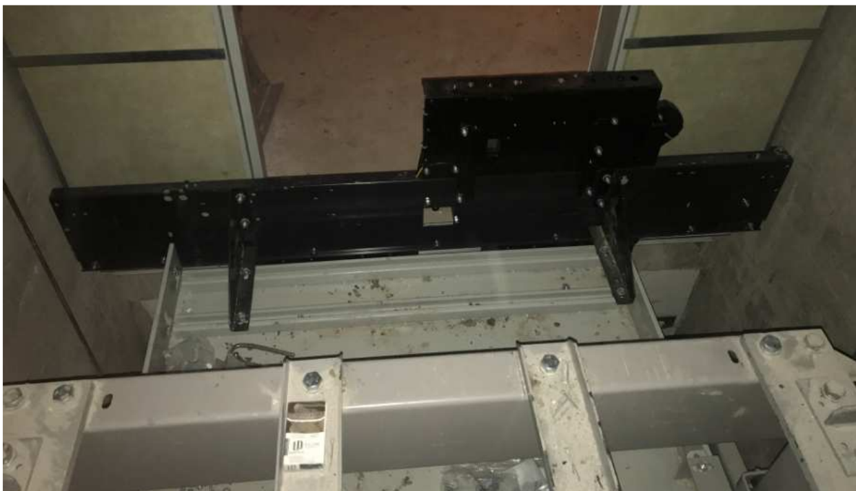
Рисунок 56 – Монтаж привода двери кабины
