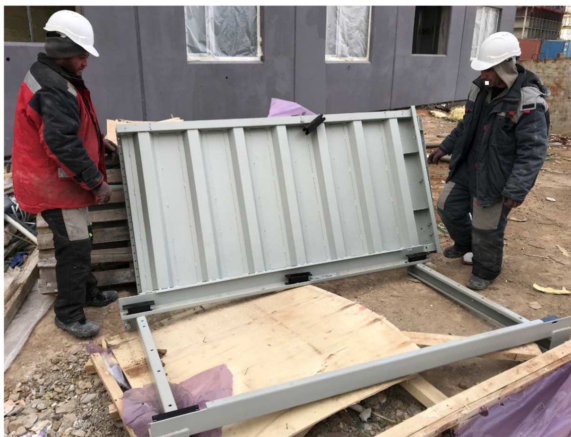
Рисунок 19 – Общий вид смонтированного каркаса кабины и противовеса
