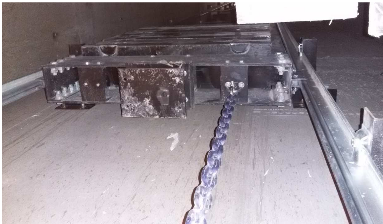
Рисунок 37 – Компенсирующая цепь на противовесе
