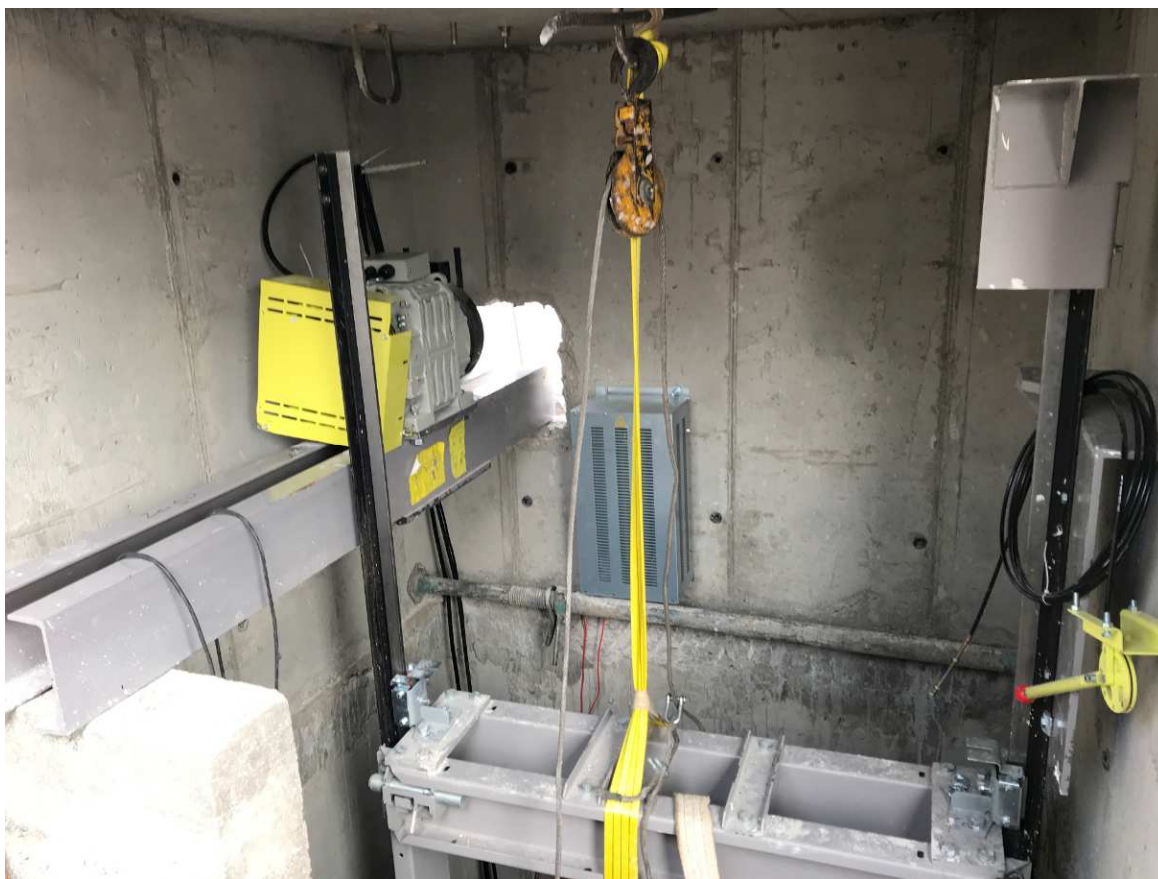
Рисунок 23 – Закрепление каркаса кабины под потолком машинного отделения а – вариант закрепления при наличии машинного отделения, б – вариант закрепления при машинном отделении в шахте лифта
