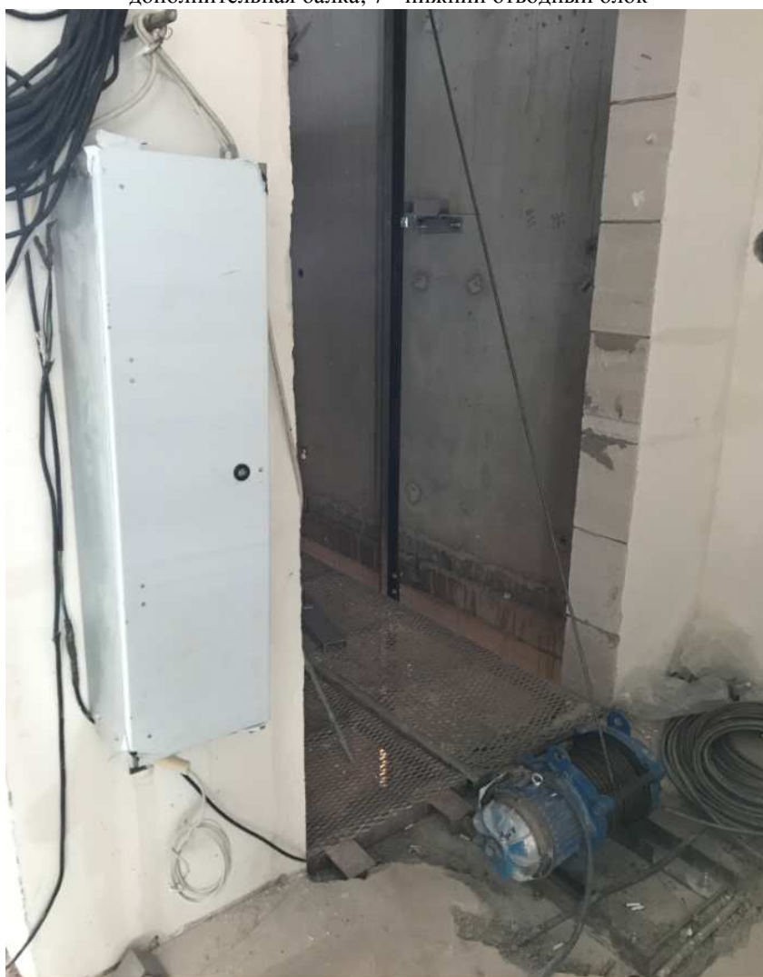
Рисунок 7 – Схемы установки монтажной лебедки и запасовки грузового каната 1 - грузовой крюк; 2 - грузовой канат; 3 - верхний отводный блок; 4 - петля; 5 - монтажная лебедка; 6 - дополнительная балка; 7 - нижний отводный блок
