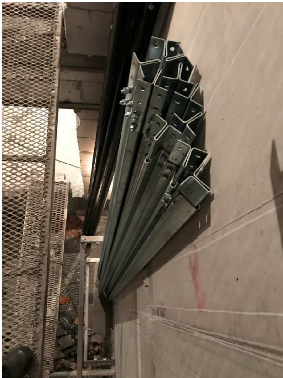
Рисунок 14 – Спуск в приямок направляющих кабины и противовеса
