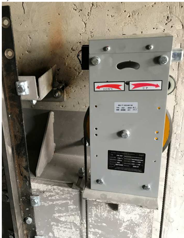
Рисунок 42 – Общий вид ограничителя скорости
