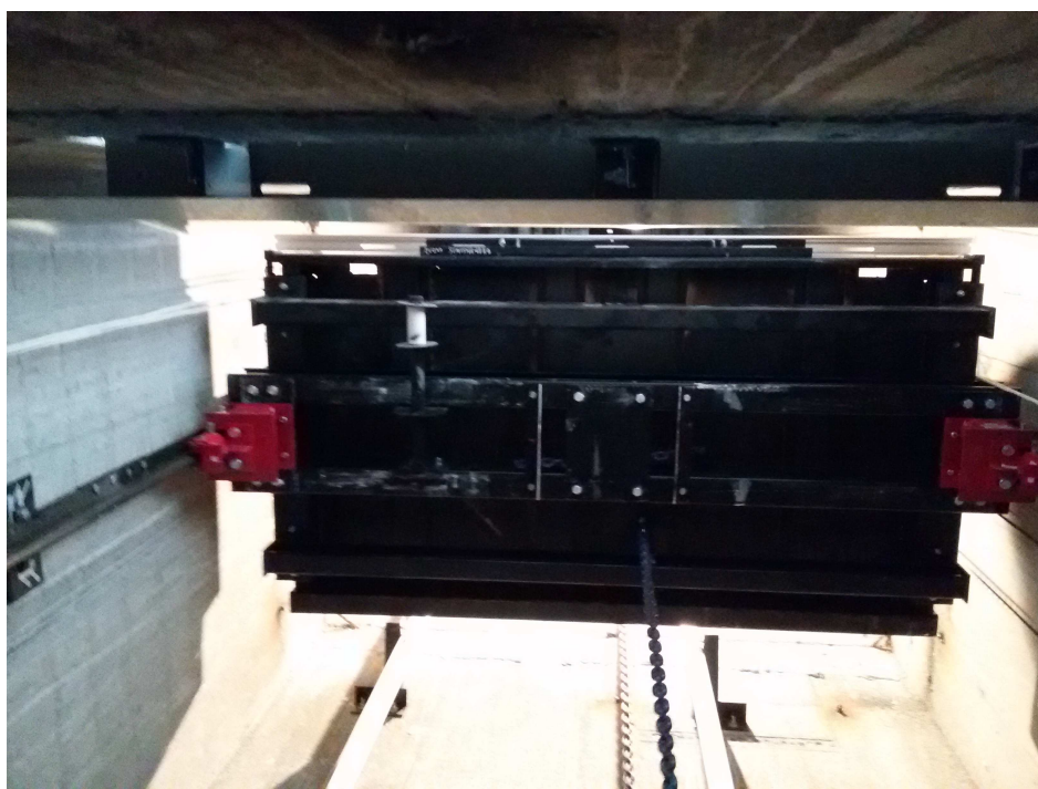
Рисунок 38 – Компенсирующая цепь на кабине
