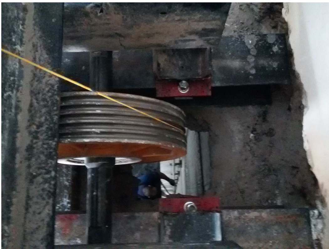
Рисунок 29 – Центрирование лифтовой лебедки
