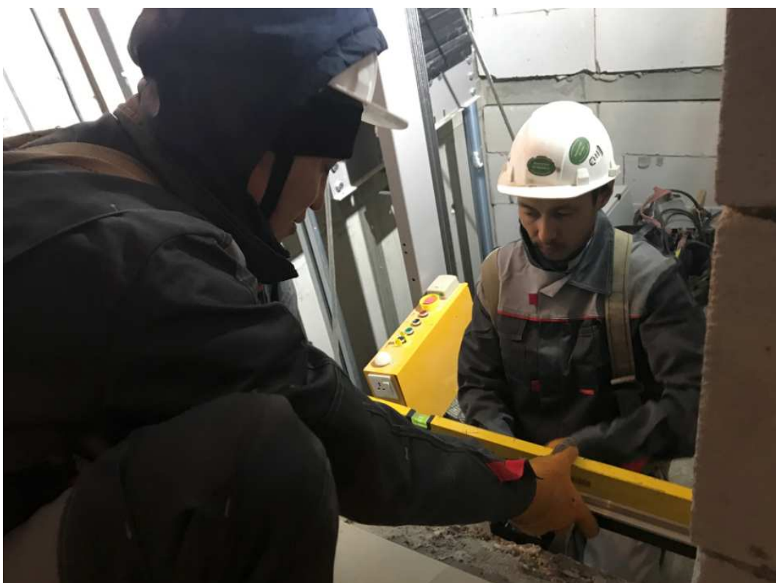
Рисунок 45 – Монтаж порога посадочной площадки
