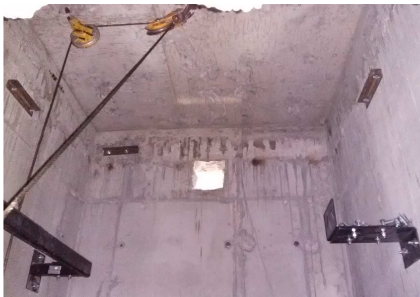
Рисунок 8 – Монтажная лебедка при отсутствии машинного помещения
