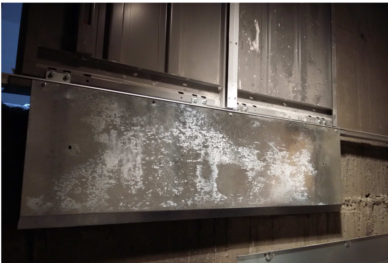
Рисунок 50 –Монтаж дверей шахты и фартука шахтных дверей
