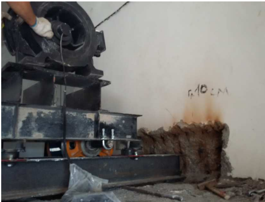
Рисунок 28 – Монтаж лифтовой лебедки
