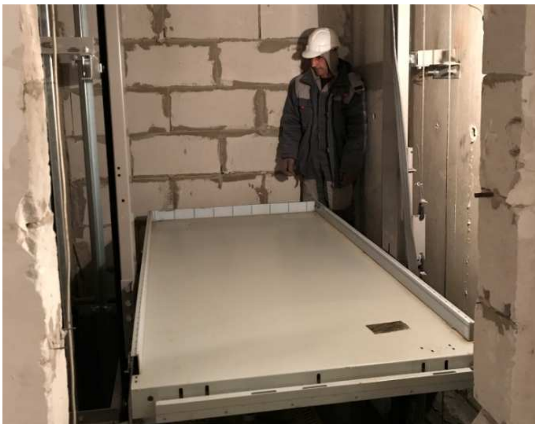
Рисунок 20 – Монтаж пола каркаса кабины
