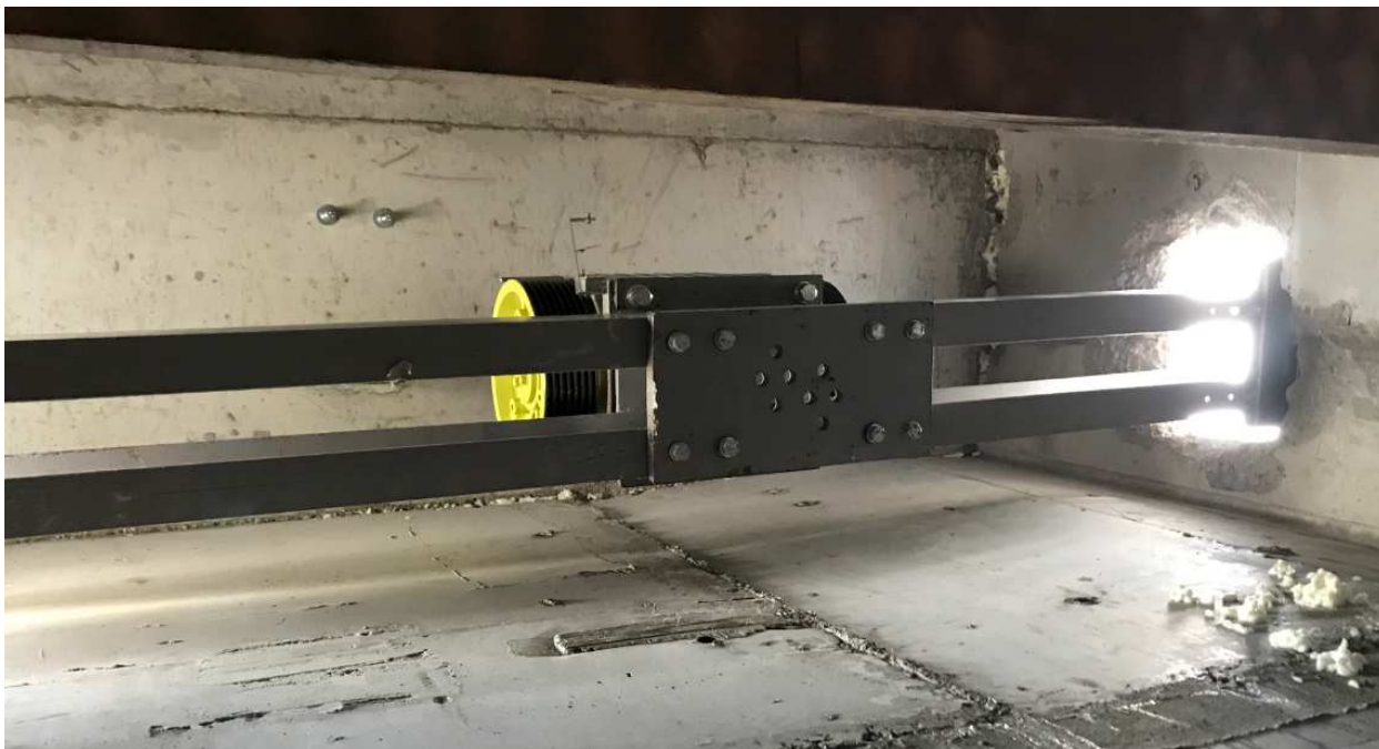
Рисунок 26 – Монтаж опорных балок, станины и отводного блока
