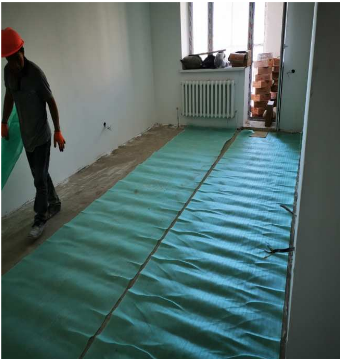
Рисунок 7 – укладка подложки
