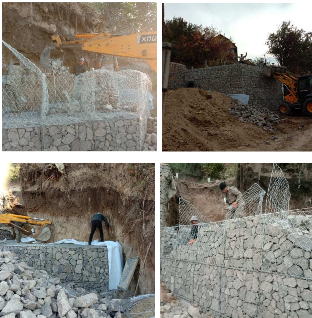
Рисунок 11 – Заполнение коробчатых габионов камнем
