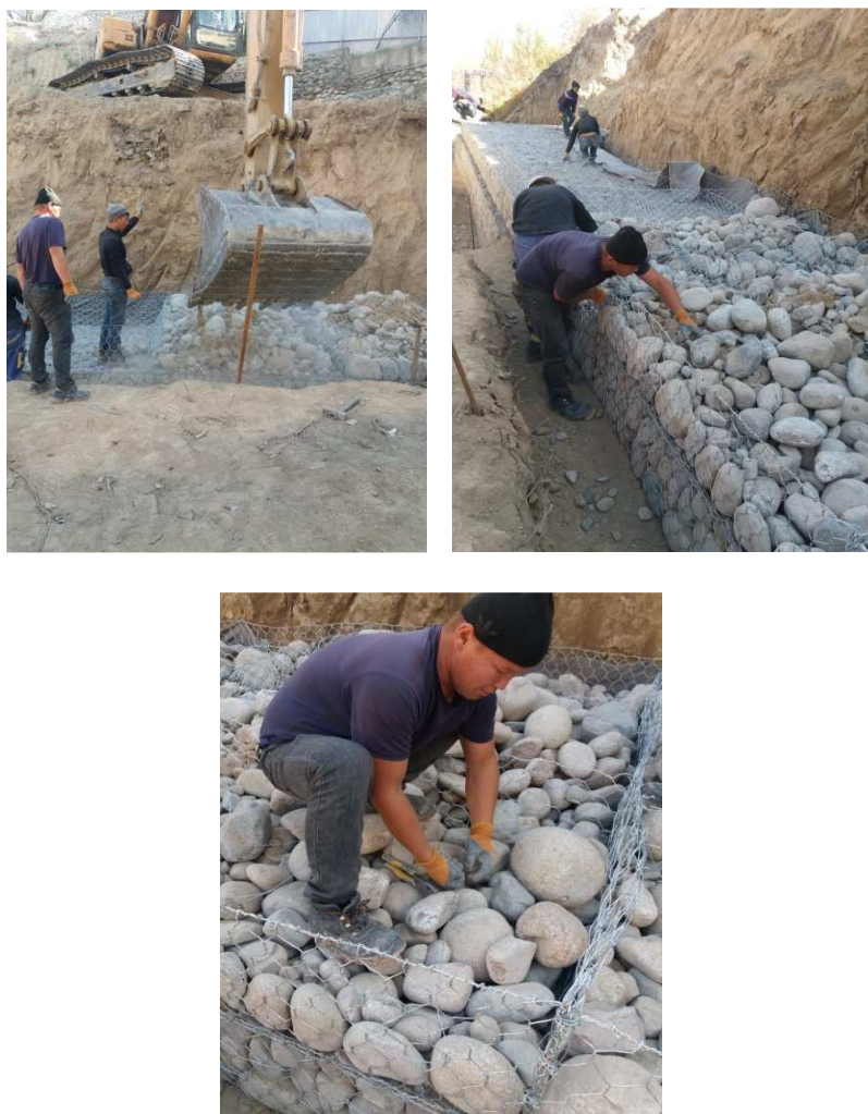
Рисунок 7 – Заполнение габионов камнем
