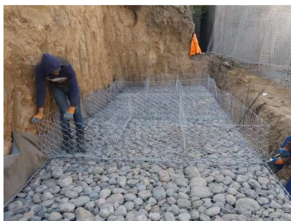
Рисунок 6 – Установка матрацно-тюфячных габионных конструкций
