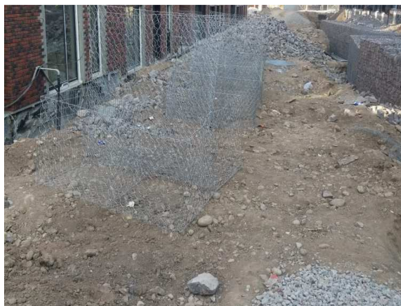
Рисунок 8 – Собранные коробчатые габионы
