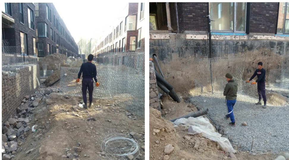
Рисунок 9 - Установка коробчатых габионных конструкций
