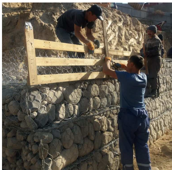
Рисунок 10 - Установка опалубки в лицевой грани габиона
