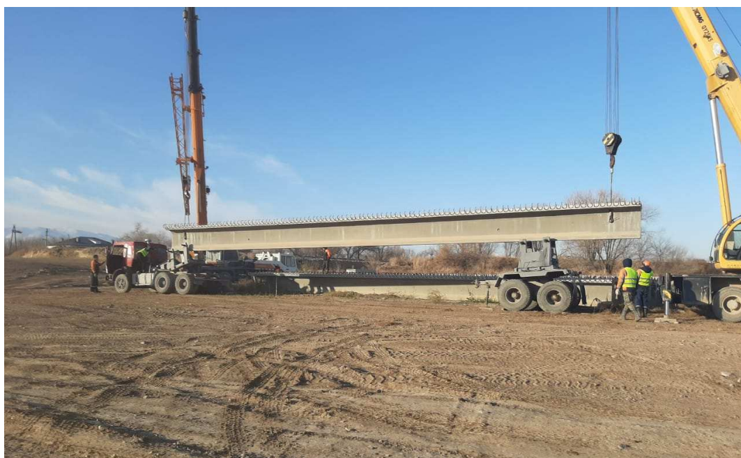
Рисунок 5 – Погрузка балок на стройплощадке
