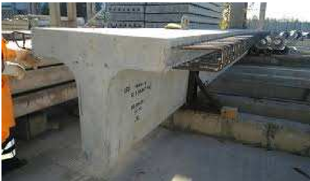
Рисунок 1 – Железобетонные балки пролетных строений
