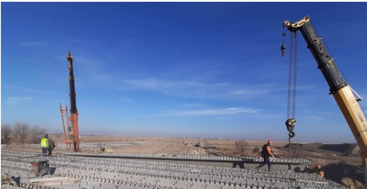
Рисунок 8 - Монтаж балок пролетного строения
