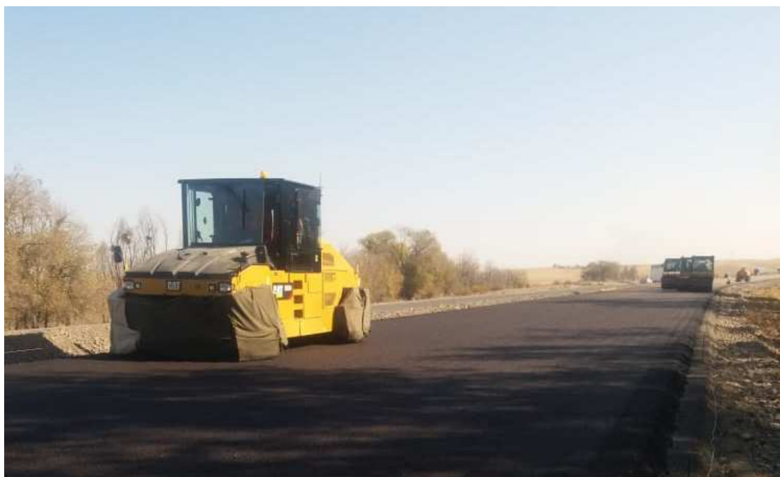
Рисунок 7 – Уплотнение асфальтобетонной смеси катками
