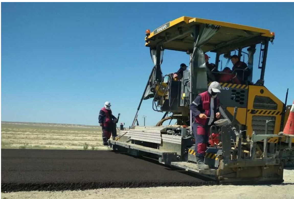
Рисунок 6 – Укладка асфальтобетонной смеси
