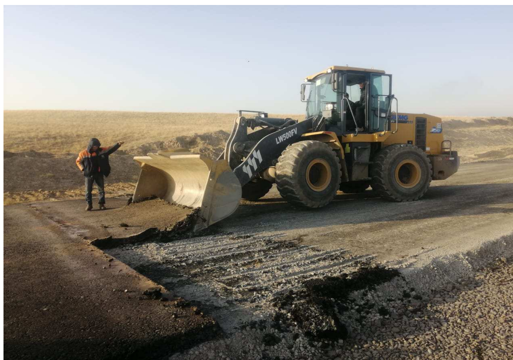
Рисунок 5 – Устройство поперечного шва
