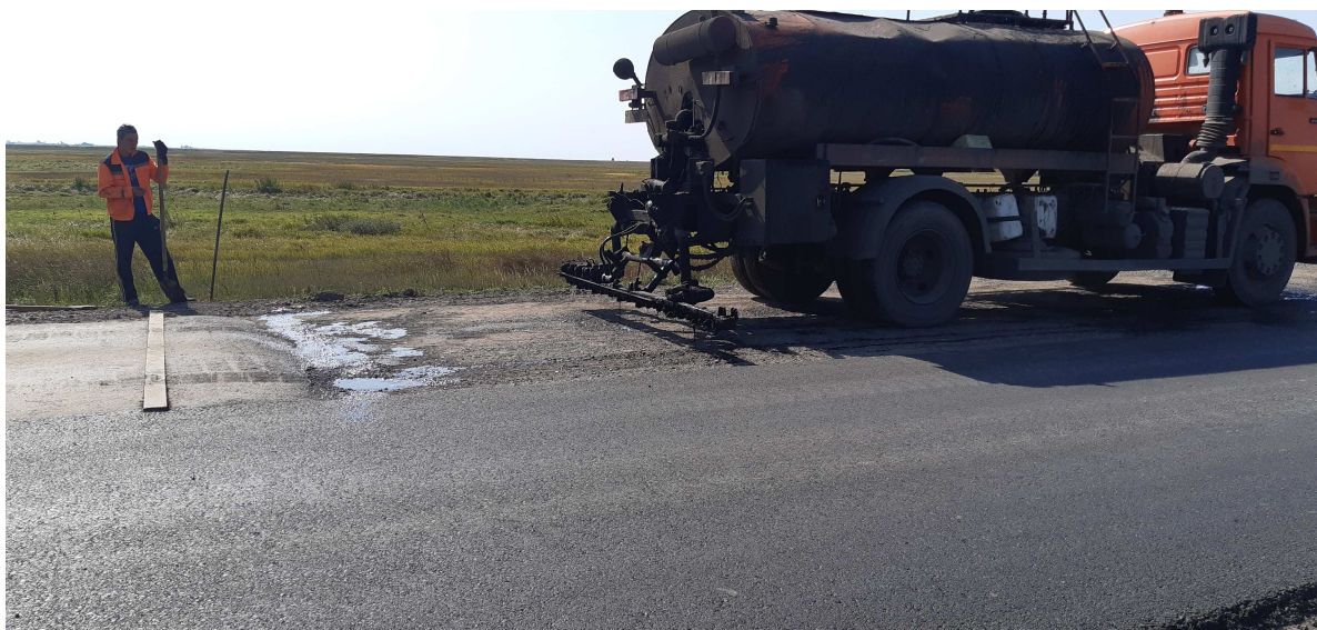
Рисунок 4 – Обработка основания битумной эмульсией
