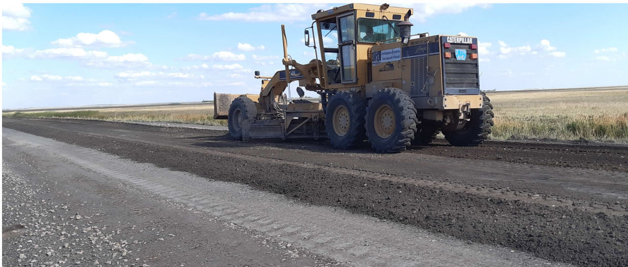
Рисунок 11 – Профилирование ресайклированного слоя основания автогрейдером
