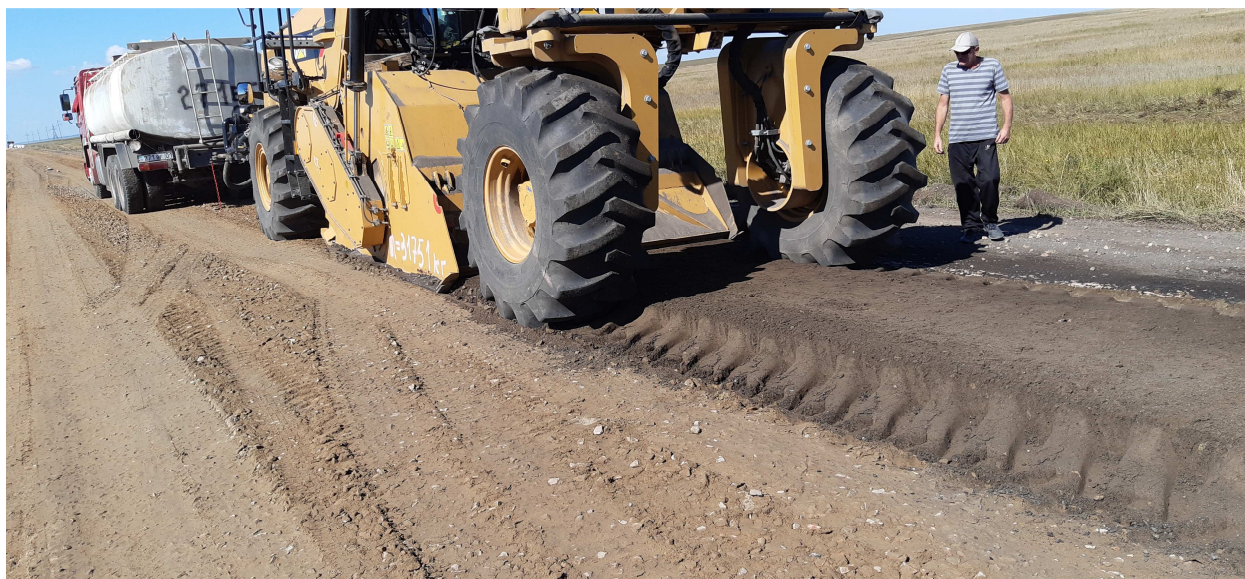
Рисунок 10 – Процесс холодного ресайклирования
