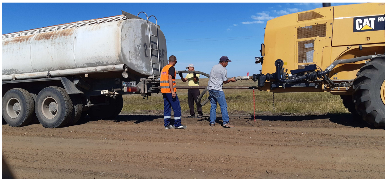
Рисунок 9 – Сцепка автоцистерны с ресайклером
