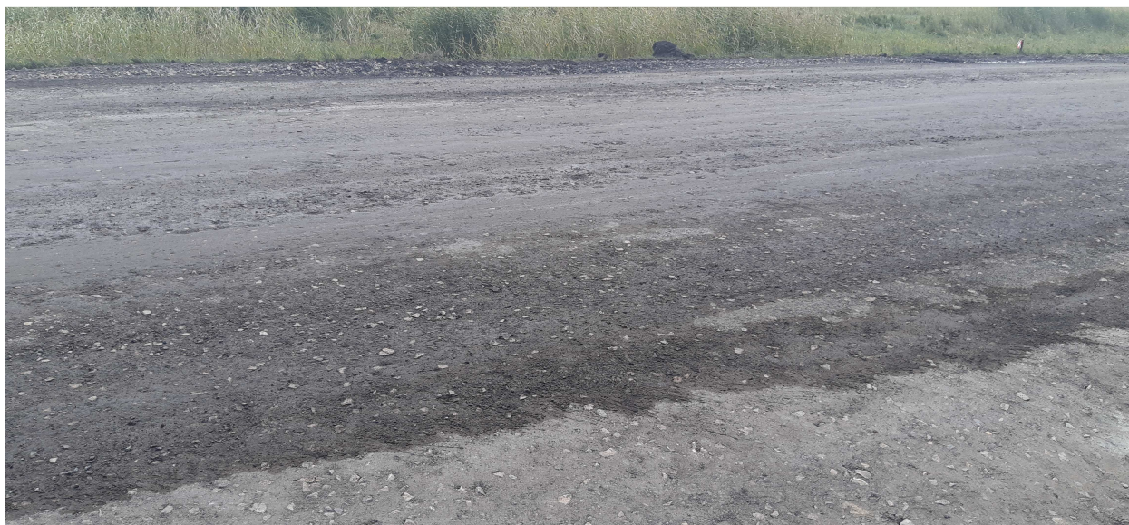
Рисунок 13 – Готовое основание под укладку нового асфальта
