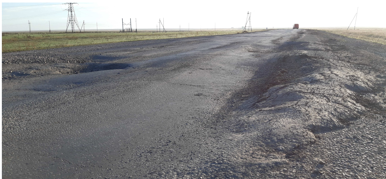
Рисунок 6 – Изношенное дорожное покрытие, подвергаемое холодному ресайклированию
