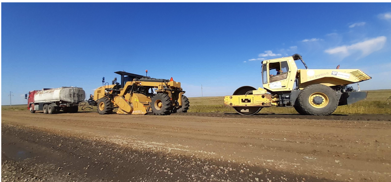
Рисунок 11 – Подкатка самоходным вибрационным катком ресайклированного слоя
