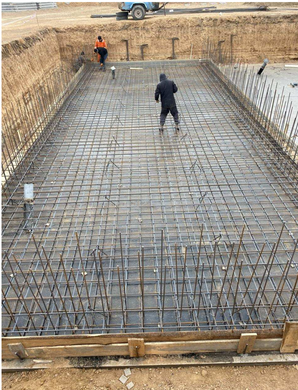
Рисунок 4 – Армирование фундаментной плиты
