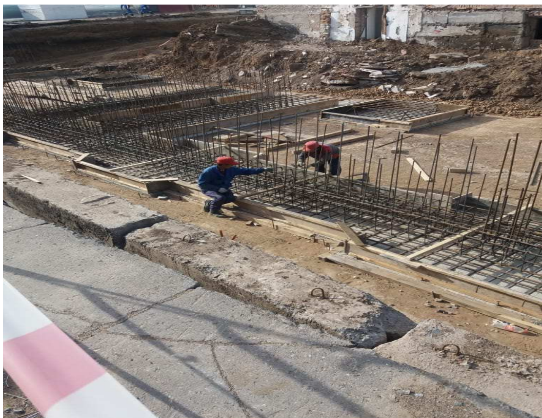
Рисунок 3 – Армирование ленточного фундамента
